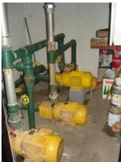
**FIGURA 04:** Bombas do Reservatório Inferior
