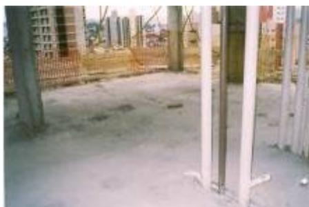
**FIGURA 08:** Tubulação dos shafts instaladas antes da execução dos mesmos
