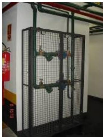
**FIGURA 22:** Vista da válvula redutora de pressão
