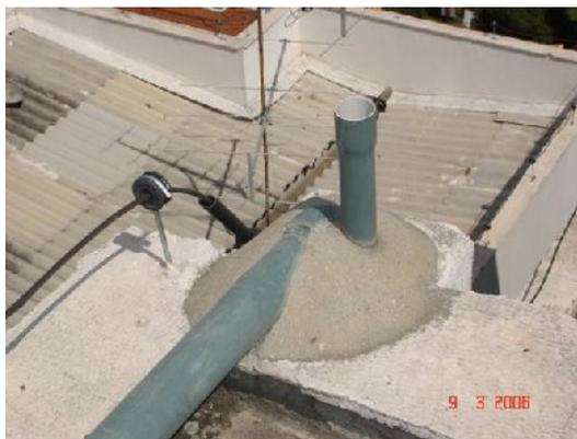
**FIGURA 07:** Detalhe do respiro do reservatório
