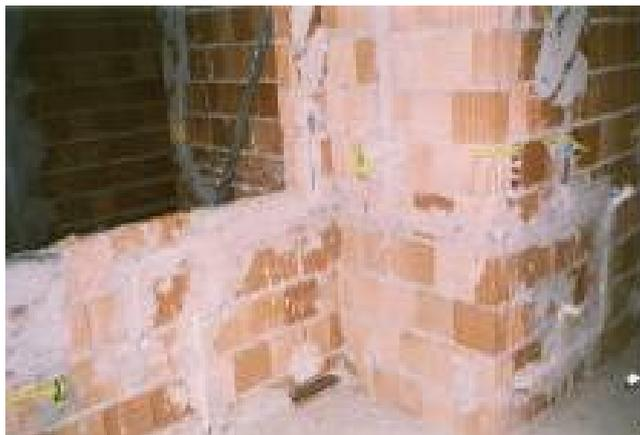
**FIGURA 09:** Instalação dos ramais e sub-ramais na cozinha, através de cortes efetuados após a conclusão da alvenaria
