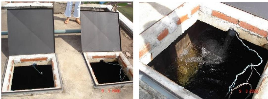
**FIGURA 06:** Vista das duas células que compõe o reservatório, e reservatório sendo abastecido, respectivamente
