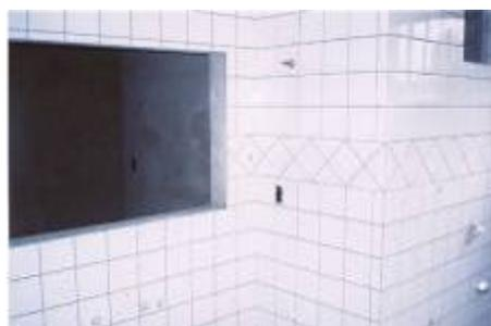
**FIGURA 10:** Vista da cozinha acabada após assentamento de revestimento cerâmico sobre a tubulação embutida
