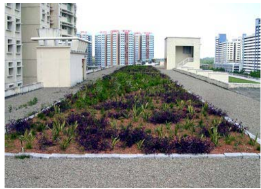
Figura 2.8: Edifício residencial, Singapura
