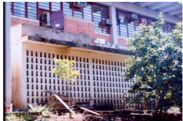
Figura 3.4: Fachada posterior da edificação na UFSCar
