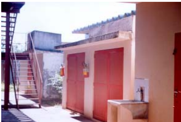
Figura 3.3: Fachada frontal da edificação na UFSCar
