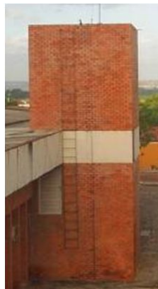
Figura 3.9 - Reservatório em concreto armado
