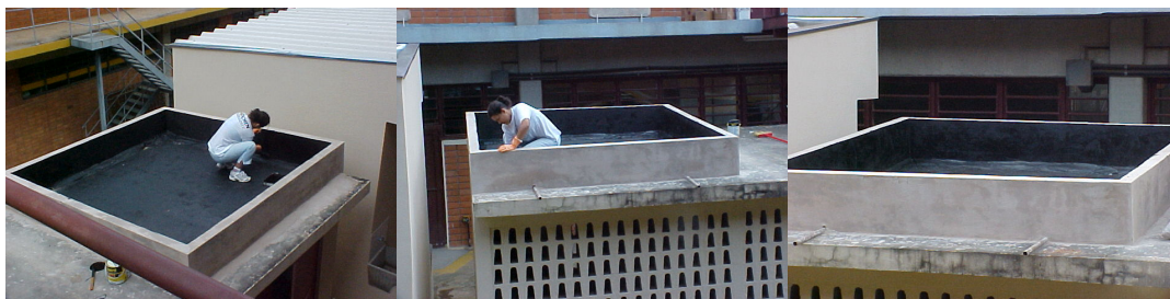
Figura 3.6: Aplicação da segunda demão de impermeabilizante
