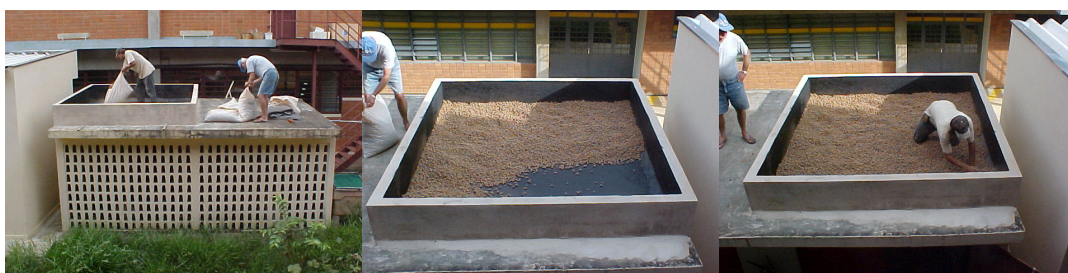
Figura 3.7: Aplicação da camada drenante
