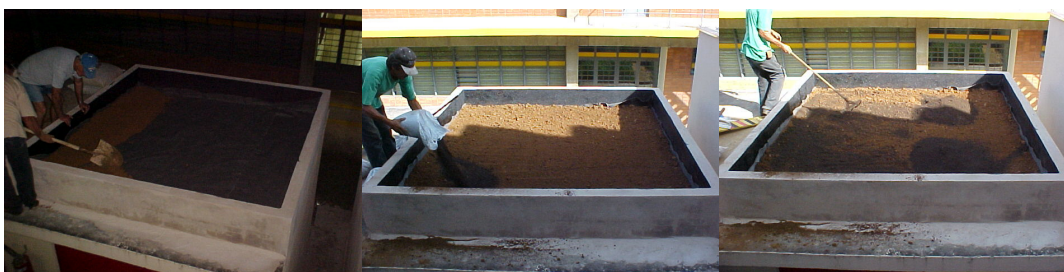
Figura 3.9: Aplicação da camada de terra vegetal
