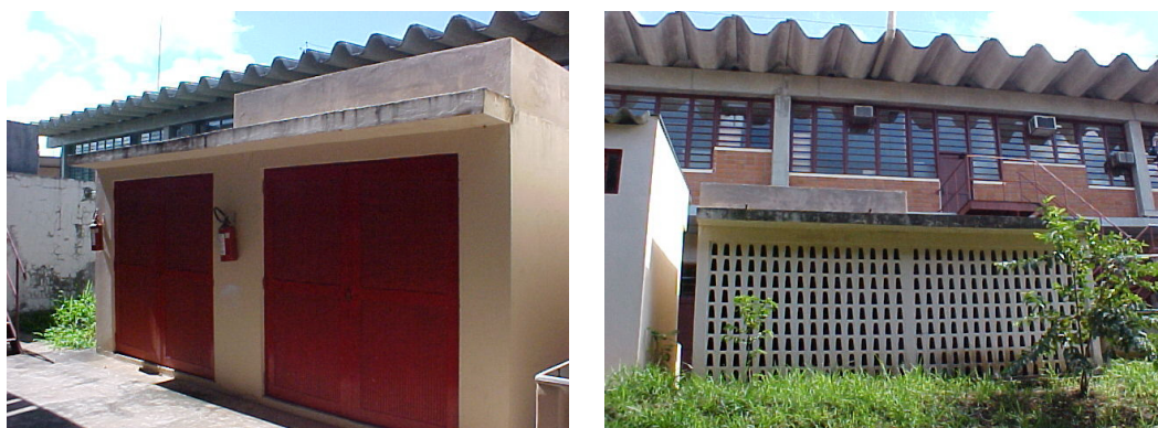
Figura 3.3: Vistas frontal (esquerda) e posterior (direita) da edificação selecionada
