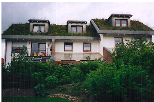
Figura 2.15: Edifício residencial, Stuttgart, Alemanha
