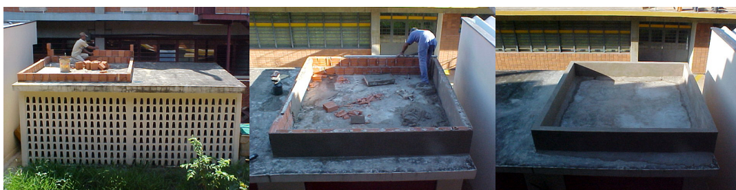
Figura 3.5: Construção das muretas de contenção
