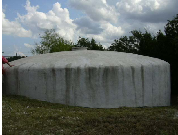
Figura 4.32 Cisterna em Concreto armado
