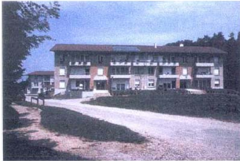
Figura 4.14 Edifício em Mellionas com aproveitamento de água pluvial
