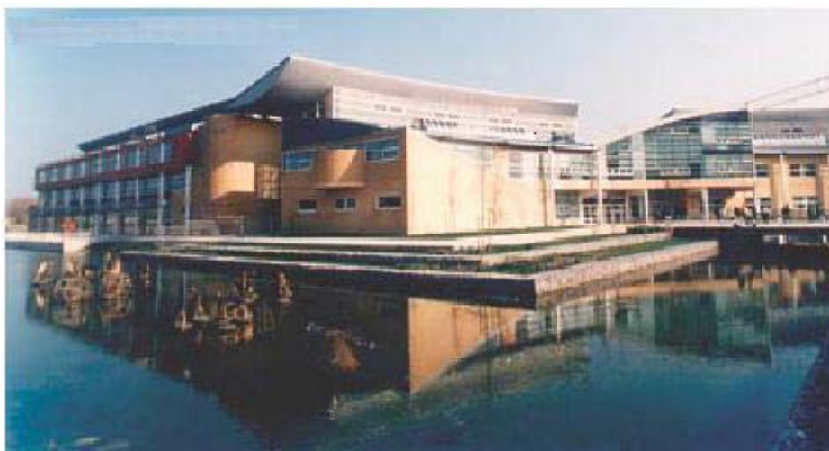
Figura 4.18 Instituto Leonardo da Vinci e lago de armazenamento
