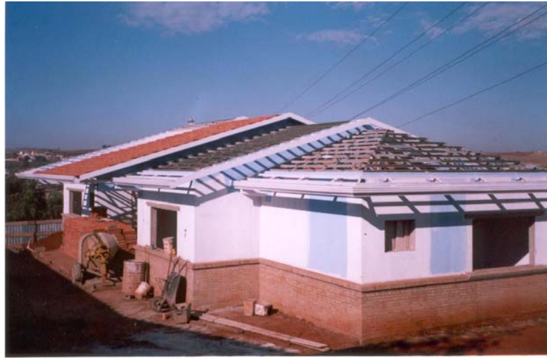
Figura 4.24 Residência em Ribeirão Preto com aproveitamento de água pluvial
