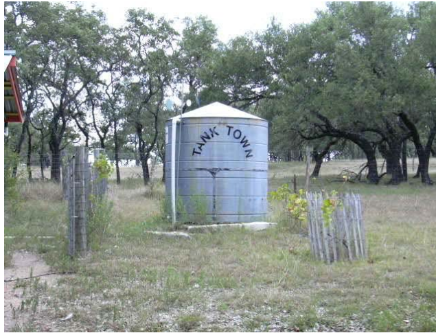
Figura 4.9 Cisterna na entrada - Tank Town
