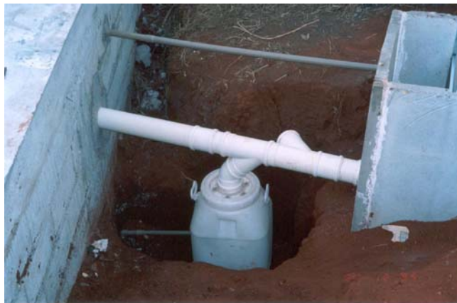
Figura 4.28 Dispositivo de descarte da primeira chuva
