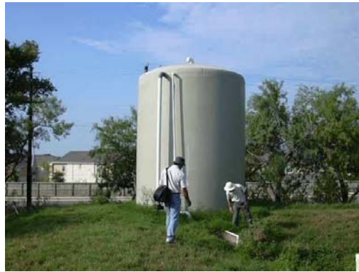
Figura 4.4 Cisterna metálica - Feather & Fuhr Animal Hospital
