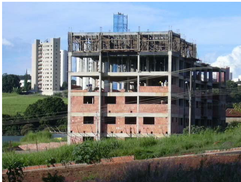
Figura 5.5 Vista lateral do Residencial Paul Klee – Data: 07/04/2004
