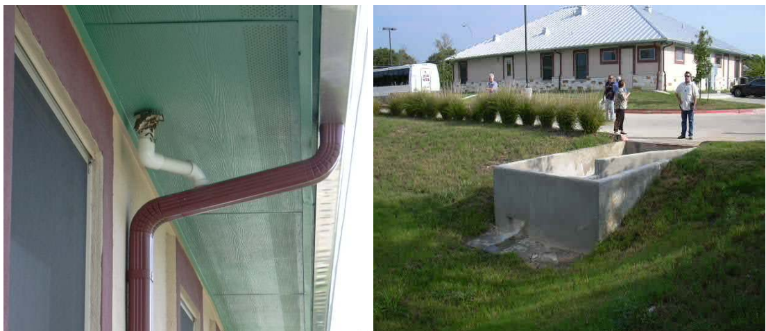
Figura 4.6 Captação da água do ar condicionado e do estacionamento - Feather & Fuhr Animal Hospital
