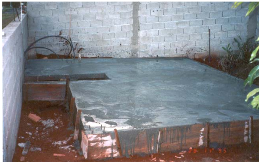
Figura 4.25 Cisterna em concreto armado da residência de Ribeirão Preto
