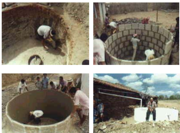
Figura 4.29 Construção de cisterna no semiárido nordestino
