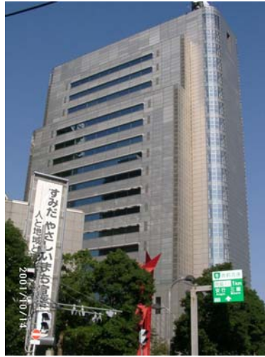
Figura 4.22 – Edifício da Prefeitura de Sumida/ Japão
