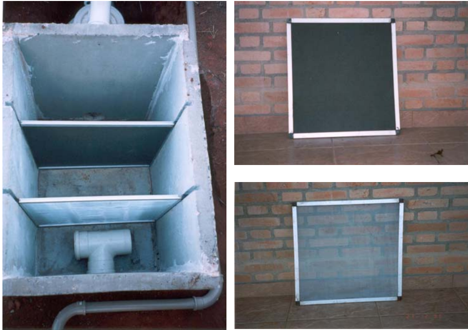
Figura 4.27 Filtro de partículas sólidas e detalhe das telas
