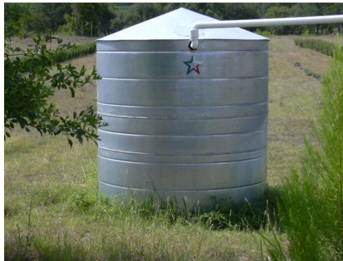
Figura 4.33 Exemplo de cisterna metálica
