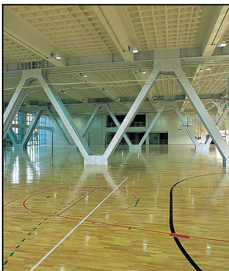
Figura 2.2 – Vigas metálicas com laje nervurada. (Fonte: www.atex.com.br )
