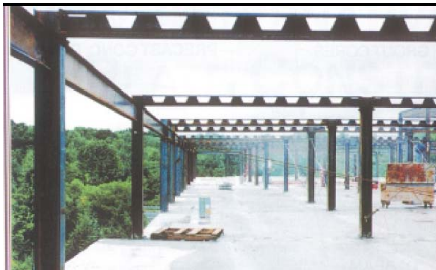
Figura 3.15 – Viga “D” assimétrica (Fonte: Sistema Girder-Slab®)
