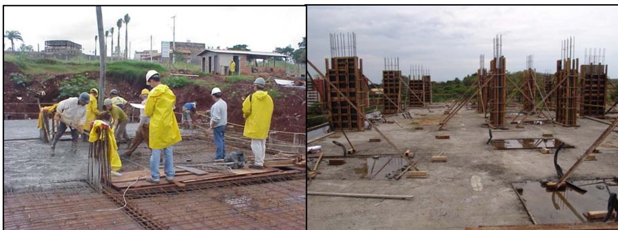
Figura 2.3 – Sequencia de execução laje maciça
