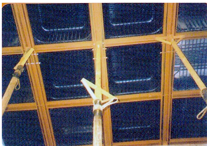
Figura 5.26 – Escoramento para laje nervurada (Fonte: www.atex.com.br )
