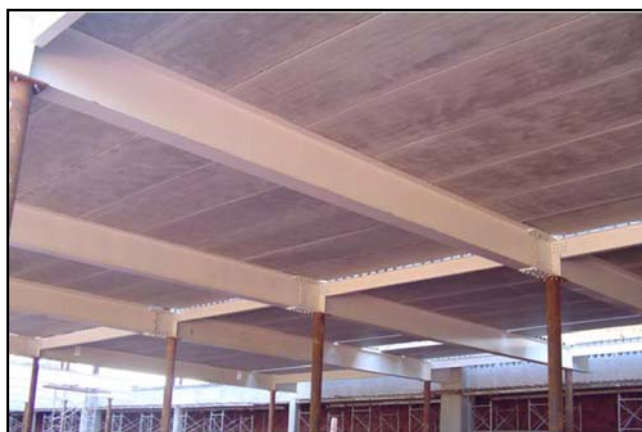
Figura 2.17 – Laje alveolar apoiadas em vigas metálicas. (Fonte: www.tatu.com.br )
