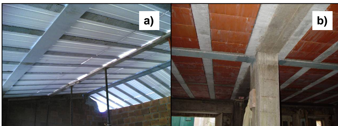
Figura 2.1 – Tipos de materiais inertes para laje com vigotas de concreto.
