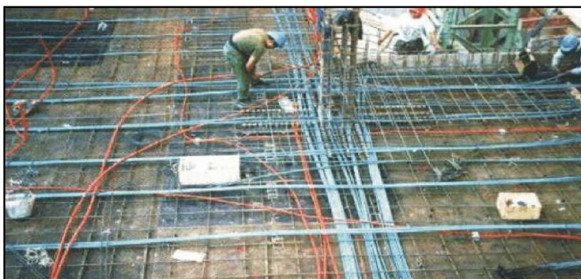
Figura 2.15 – Montagem de uma laje lisa protendida (Fonte: PREMAG - Engenharia)
