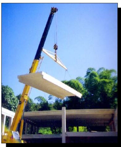
Figura 10 – Montagem de laje com utilização de guindaste e aparelho de elevação (balonier).
