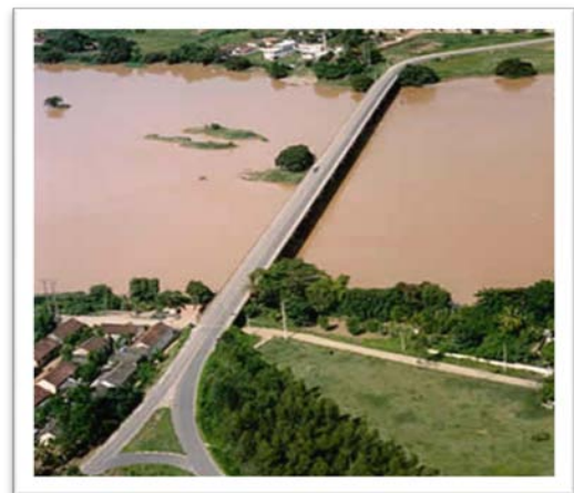
Figura 4: Ponte sobre o Rio Paraíba do Sul em São Fidélis (RJ) – utilização de elementos em concreto protendido.
