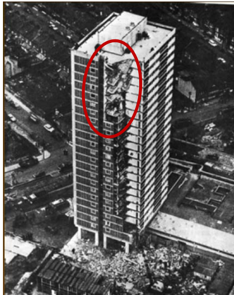
Figura 2: Acidente ocorrido no edifício Rona Point, Inglaterra – 1968. Fonte: ABCP, 2008
