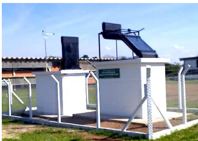
Figura 2.5 – Chaminé convencional (vertical) e chaminé solar (inclinada) localizadas na cidade de São Carlos – SP
