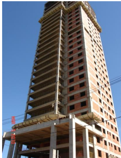
FIGURA 4.3 – Elevação do Edifício A: término do último pavimento. Março de 2010.
