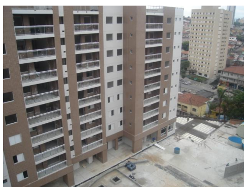
FIGURA 4.7 – Vista frontal da Torre D, indicada na FIGURA 4.6, na fase de acabamento.
