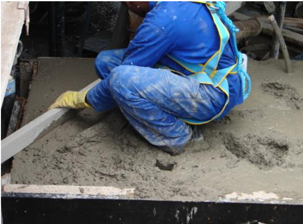
Figura 59 - Nivelamento da escada
