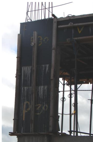
Figura 31 - Pilar numerado e travado pronto para a concretagem
