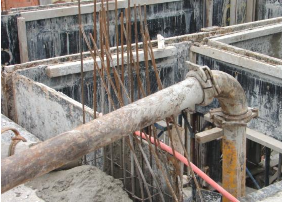
Figura 52 - Aço dobrado para permitir passagem da mangueira para concretagem
