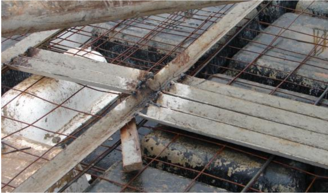
Figura 42 - Preparo para elementos que ficarão embutidos na laje
