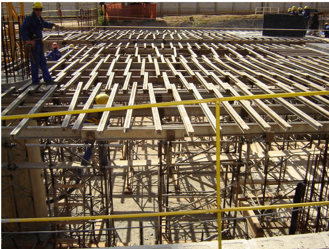
Figura 3 - Posicionamento de escoramentos que servirão para a montagem e suporte das fôrmas
