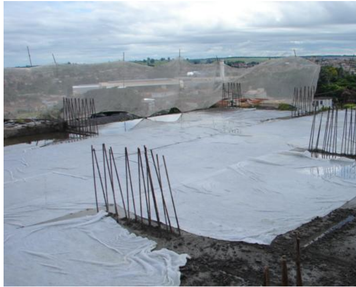
Figura 66 - Mantas para evitar a evaporação excessiva e brusca da água do concreto
