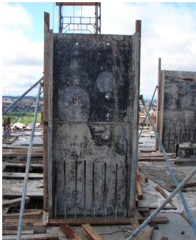
Figura 27 - Fôrmas do pilar
