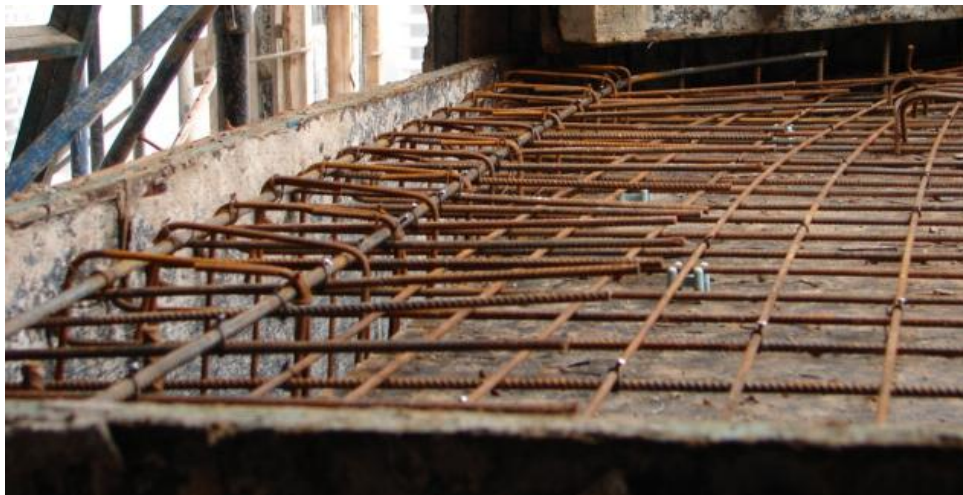
Figura 46 - Patamar da escada pronto para concretagem
