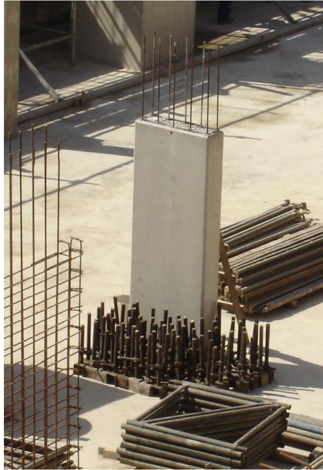
Figura 11 - Exemplo de pilar executado de maneira correta e sem problema patológico de 'bicheiras'
