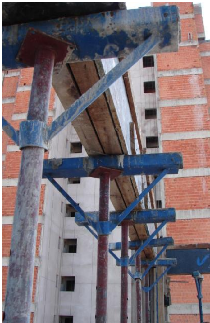
Figura 34 - Escoras e madeiramento das vigas
