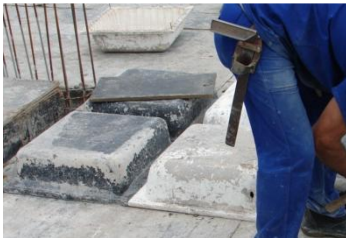
Figura 4 - Fôrmas plásticas para execução das nervuras na laje
