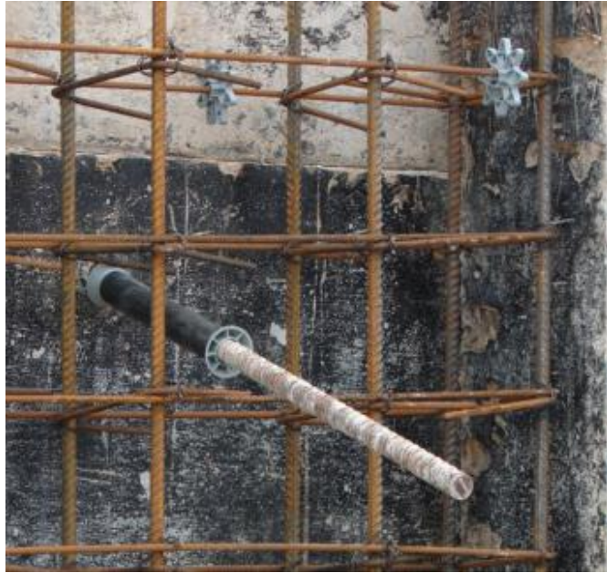
Figura 32 - Tubo cilíndrico usado para melhor travamento e espaçador
