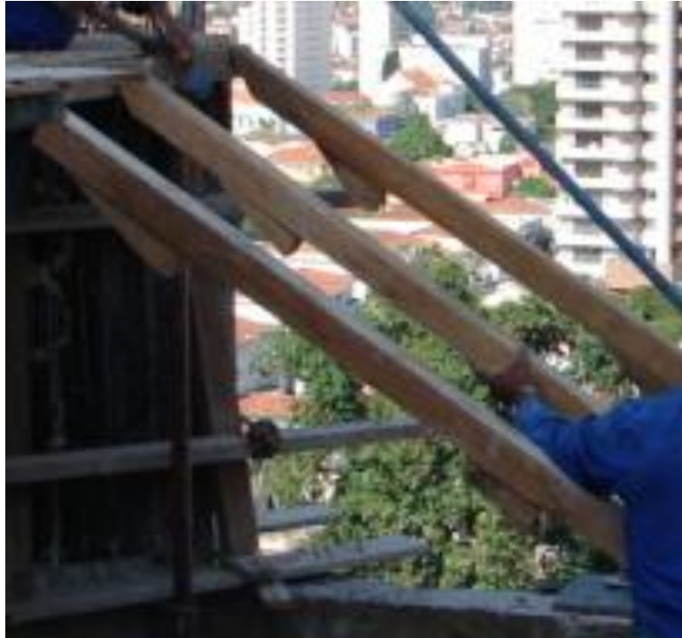
Figura 25 - Posicionamento da primeira etapa da escada
