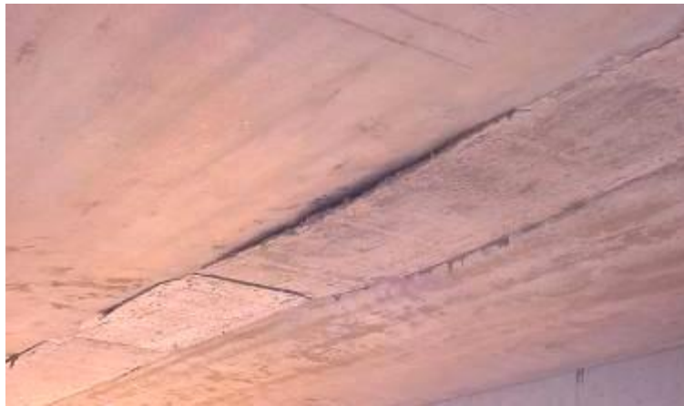
Figura 16 - Abertura da fôrma durante o processo de concretagem Fonte: ALVES, et al., 2006
