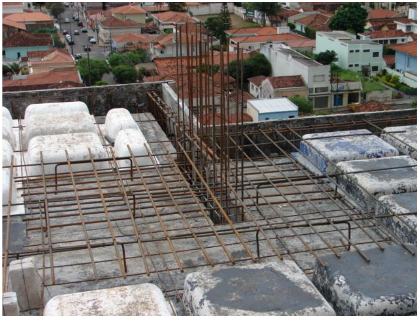
Figura 44 - Uso de caranguejos para posicionar armadura
