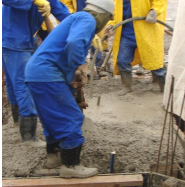
Figura 60 - Passagem de pessoas e equipamento na armadura sem um caminho pré definido
