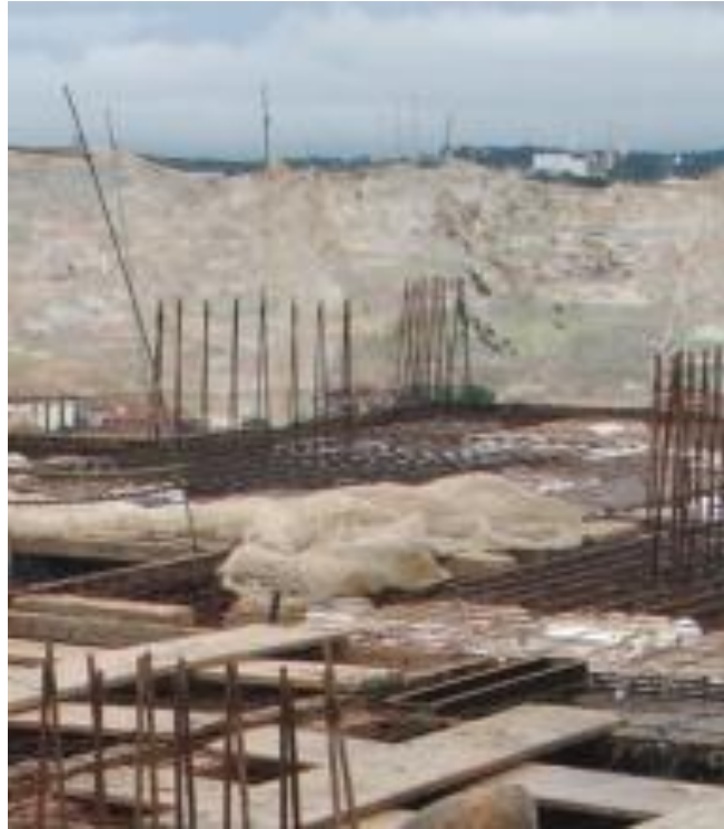
Figura 51 - Colocação de uma tela lateral para evitar que o excesso de concreto seja arremessado do pavimento
