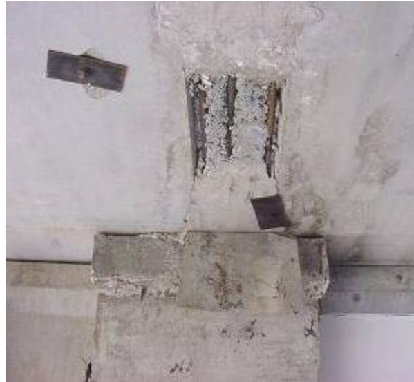
Figura 17 - Bicheiras com ferragem exposta
