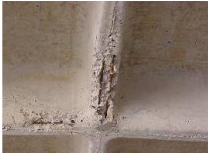
Figura 18 - Bicheira em lajes nervuradas Fonte: ALVES, et al ; 2006
