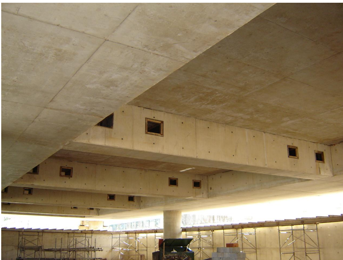
Figura 2 - Lajes e vigas com excelente grau de execução
