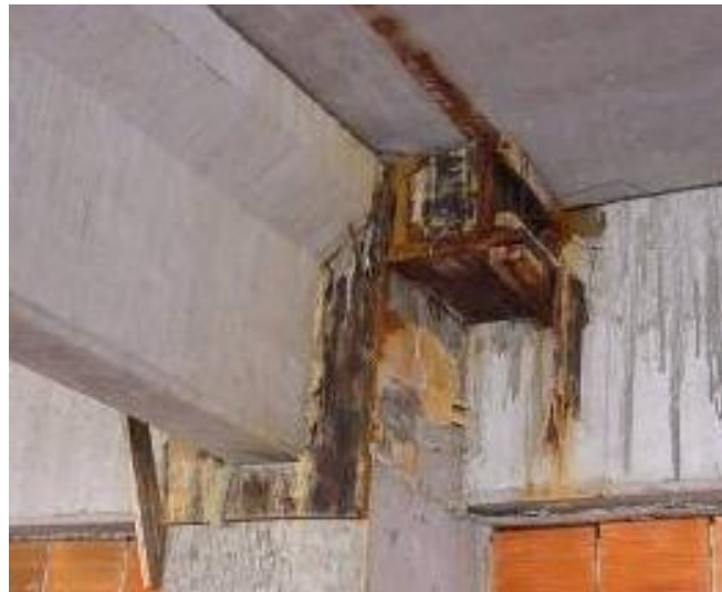
Figura 22 - Fragmentos de fôrma incorporados ao pilar Fonte: ALVES, et al , 2006
