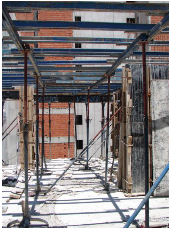
Figura 38 - Escoramento distribuído pelo pavimento para montagem das fôrmas da laje
