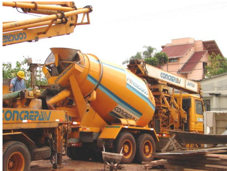
Figura 53 - Caminhão betoneira com acesso fácil para a concretagem
