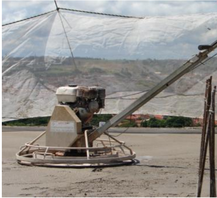
Figura 64 - Alisamento da superfície da laje
