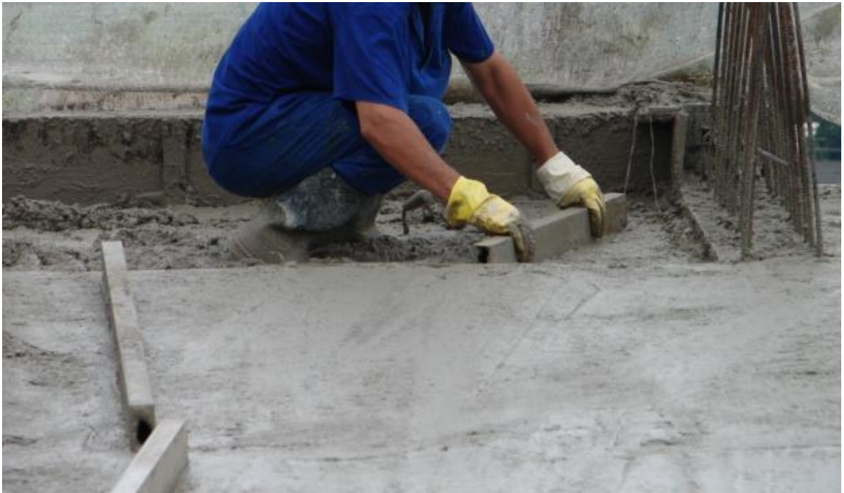
Figura 61 - Nivelamento do concreto na laje
