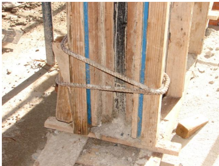
Figura 29 - Travamento do pilar usando escora de madeira e 'anel' de aço
