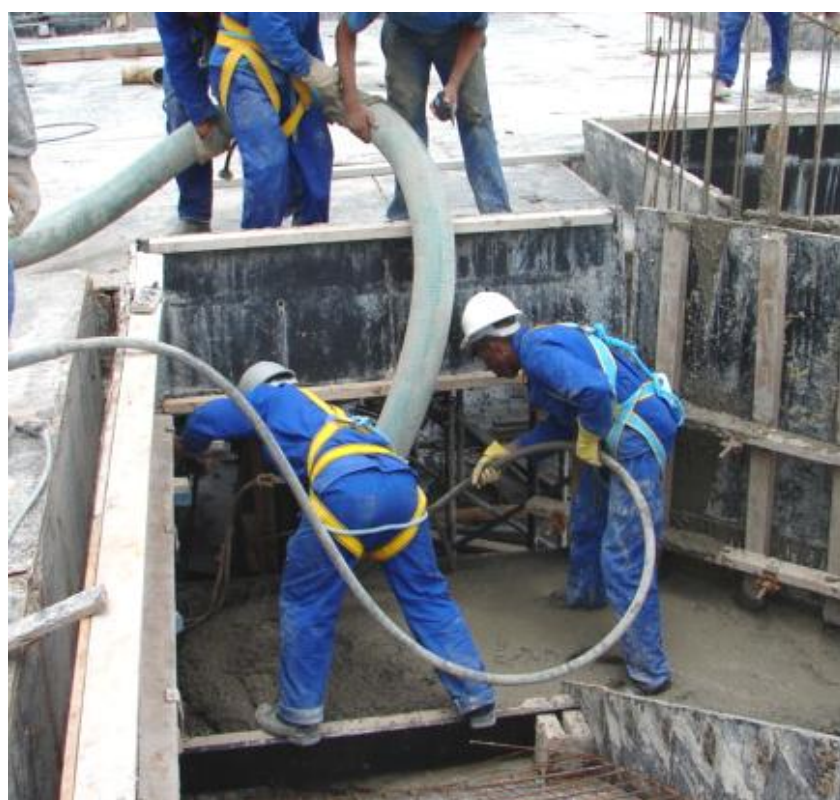
Figura 57 - Lançamento e adensamento do concreto na escada
