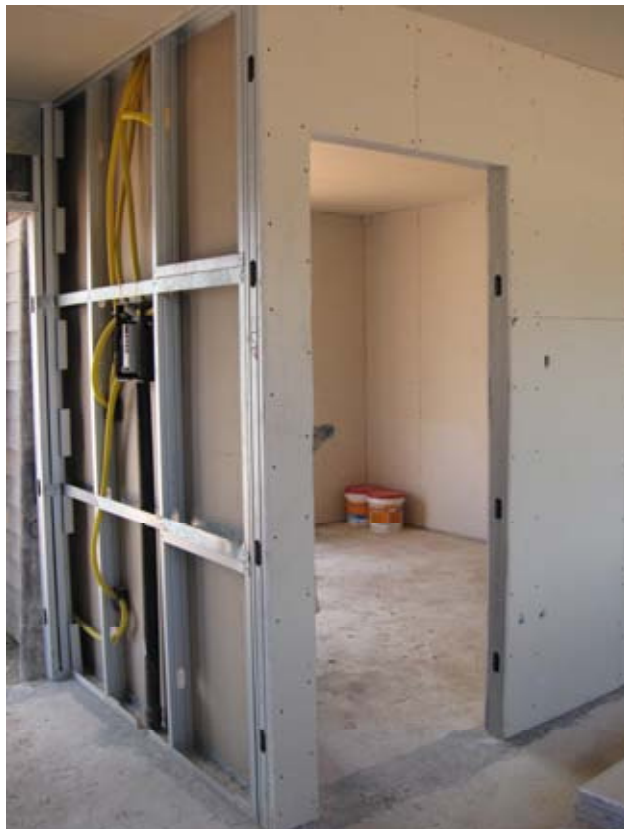
Figura 36: Detalhe de painel sendo revestido com placas de gesso acartonado
