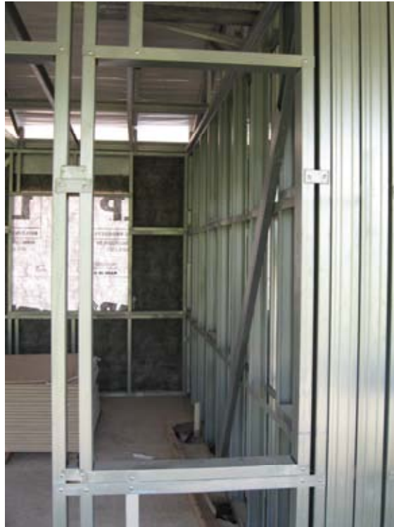
Figura 45: Abertura para esquadria em painel em LSF
