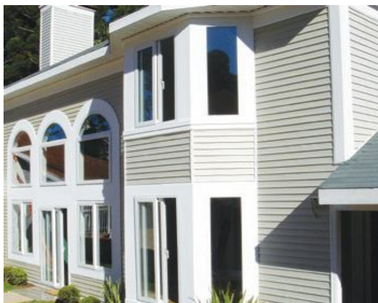
Figura 35: Exemplo de aplicação do siding vinílico em fachada residencial (LPBRASIL, 2011)
