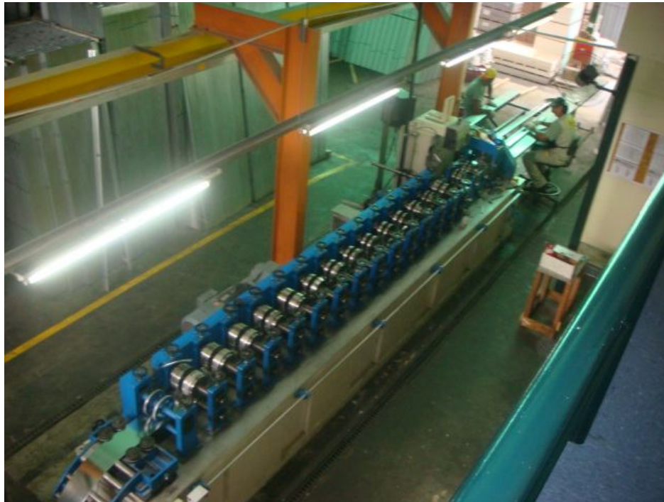
Figura 69: Operários verificando a qualidade dos perfis fabricados
