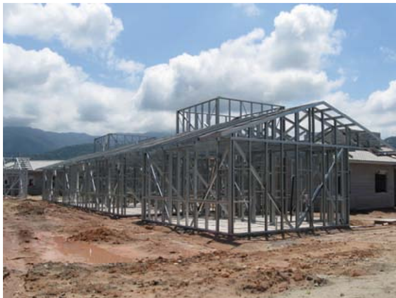
Figura 4: Visão geral da estrutura de uma residência em LSF
