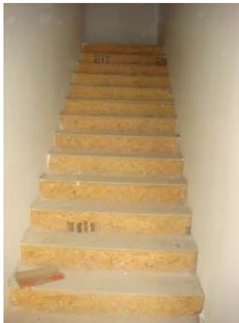
Figura 27: Escada estruturada em LSF revestida com placas OSB
