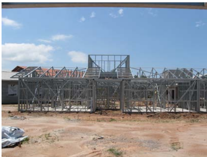
Figura 5: Fachada principal da residência em LSF
