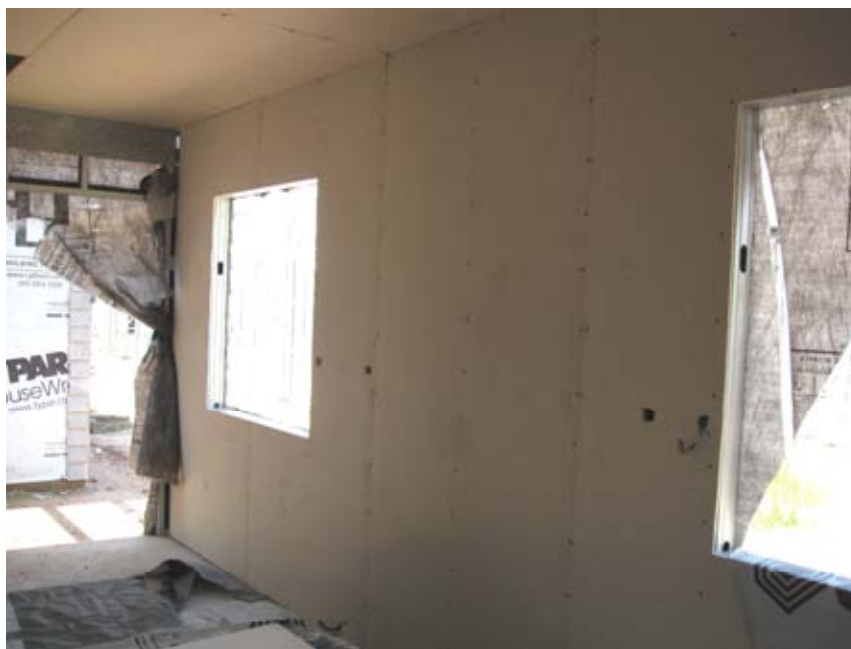
Figura 37: Placas de gesso acartonado instaladas em painel com abertura para esquadrias
