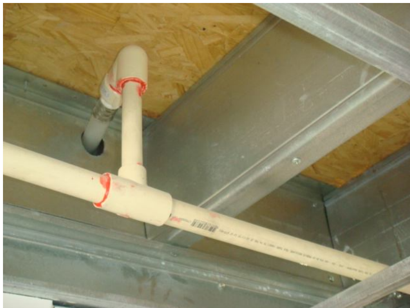
Figura 43: Tubulação passando pelo perfil que compõe uma laje em LSF
