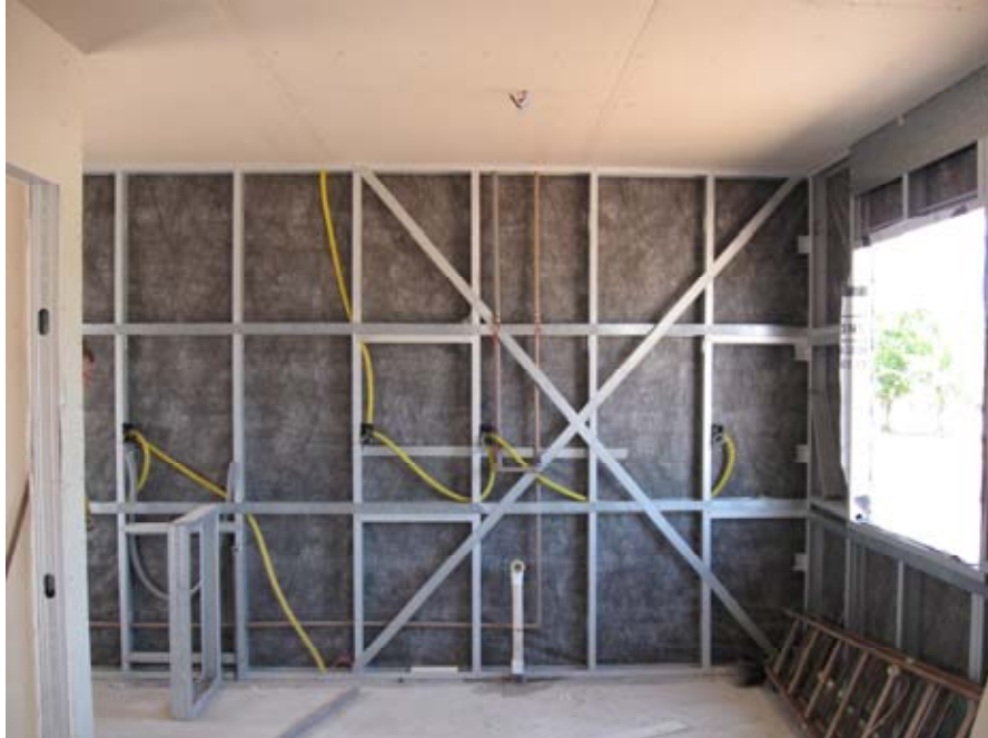
Figura 20: Painel contraventado com fita metálica
