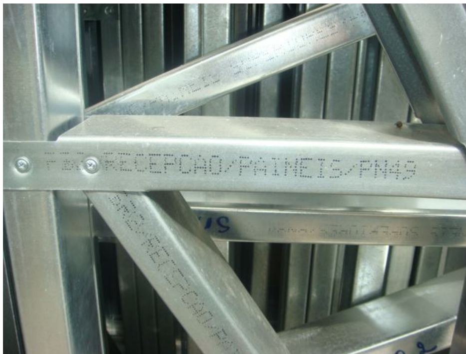
Figura 70: Perfil com identificação originada pela máquina em consonância com o projeto
