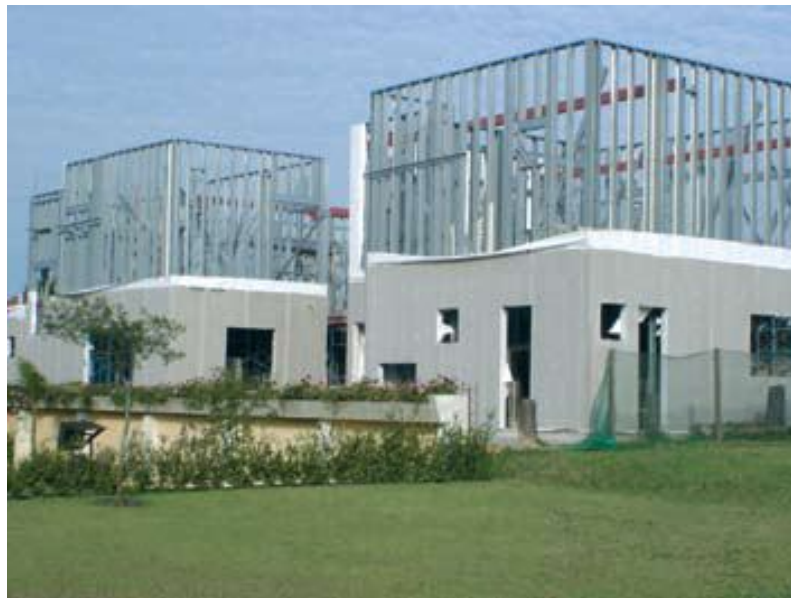
Figura 39: Fechamento de painéis externos com placas cimentícias (BRASILIT, 2010)
