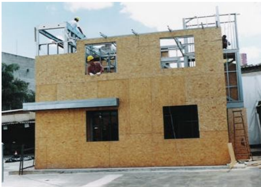
Figura 31: Exemplo de aplicação de placas OSB em painéis estruturais (CRASTO, 2005)
