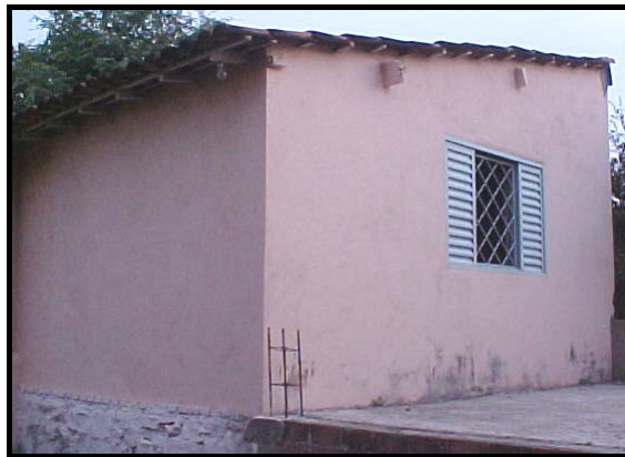
Figura 4.15: Edificação 5, vista das fachadas Leste e Norte.
