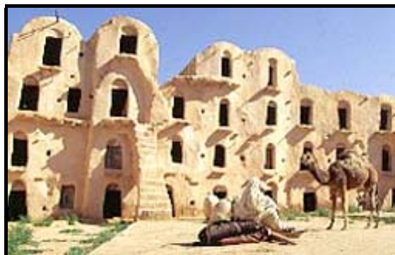
Figura 2.3: Exemplo de edificação em clima quente e seco (Tunísia).
