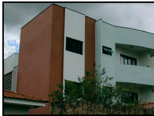
Figura 4.3: Edificação 1, vista das fachadas Norte e Oeste do ambiente 1.
