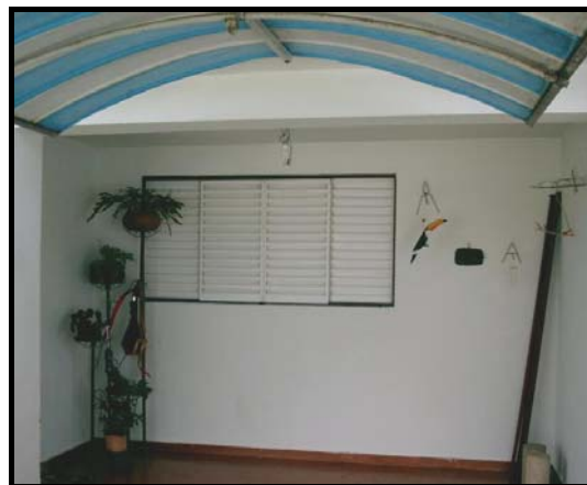
Figura 4.6: Edificação 2, vista da fachada Leste do ambiente 2.
