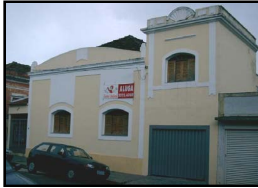
Figura 4.18: Edificação 6, vista das fachadas Norte e Oeste.
