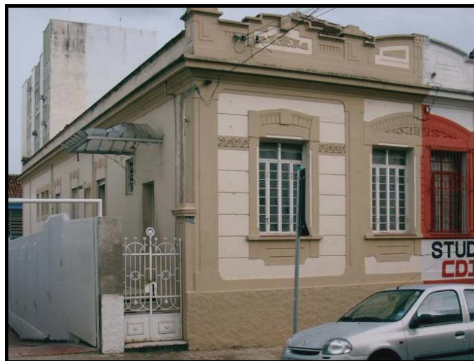
Figura 4.21: Edificação 7, vista das fachadas Leste e Norte.
