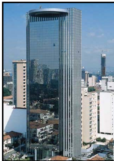
Figura 2.4: Exemplo de edificação com grande área de vidros, São Paulo.
