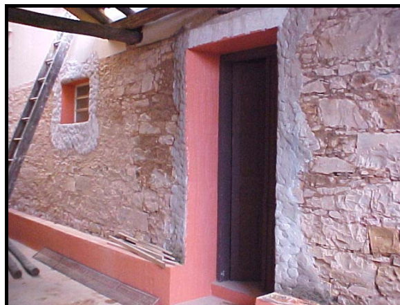
Figura 4.12: Edificação 4, vista da fachada Oeste do ambiente 4.
