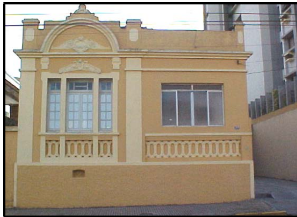
Figura 4.9: Edificação 3, vista da fachada Sul.
