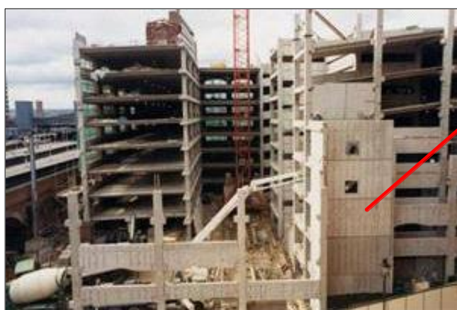
Figura 2. 13 – Parede de contraventamento pré-fabricada (FONTE: Ferreira, 2008).
