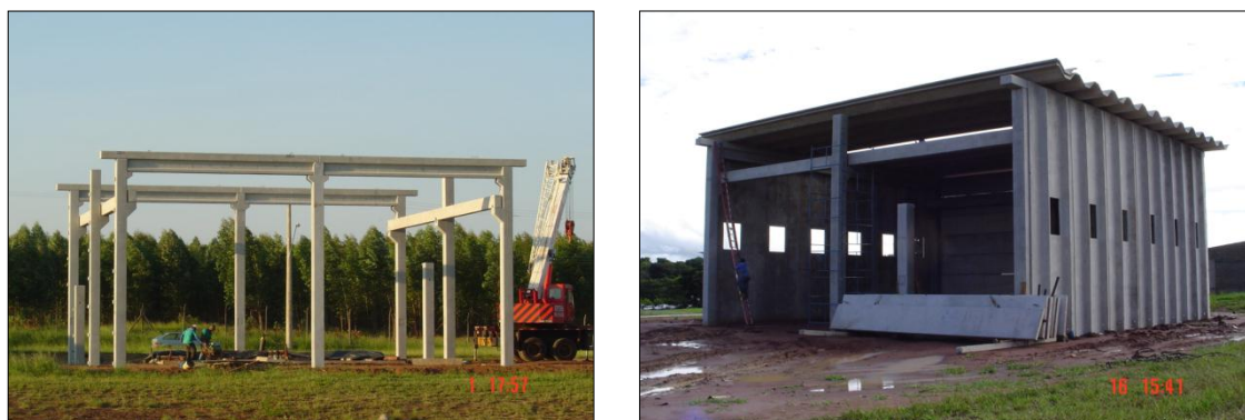
Figura 2. 3 – Sistema de fechamento de um galpão: (a) Somente os elementos dos pórticos: (b) Painel de fechamento sendo inserido (FONTE: Ferreira, 2008).
