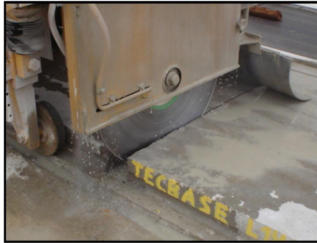
Figura 3. 6 – Corte transversal com disco na laje alveolar (FONTE: Petrucci, 2009).
