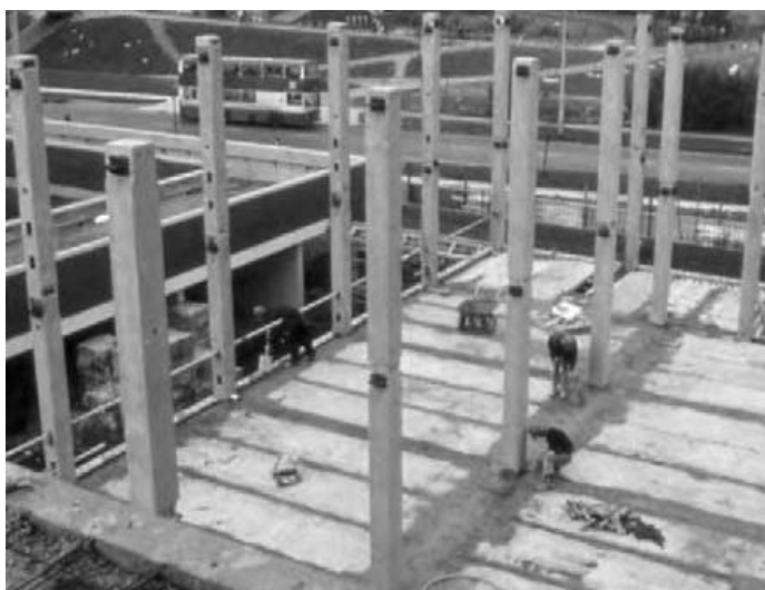
Figura 3. 13 – Execução de pavimento com laje alveolar sem utilização de capa estrutural (FONTE: Elliot, 2002).
