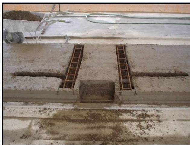
Figura 3. 16 – Reforço realizado ao redor de um recorte (FONTE: Petrucelli, 2009).
