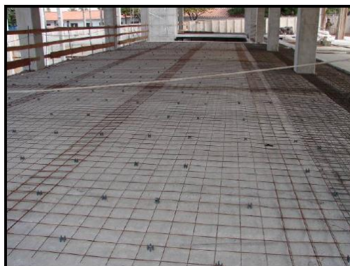
Figura 4.3 – Pavimento pronto para receber a capa estrutural (FONTE: Petrucelli, 2009).
