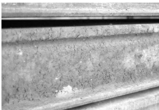
Figura 4. 14 – Rugosidade lateral de um painel de laje alveolar (FONTE: Elliot, 2002).
