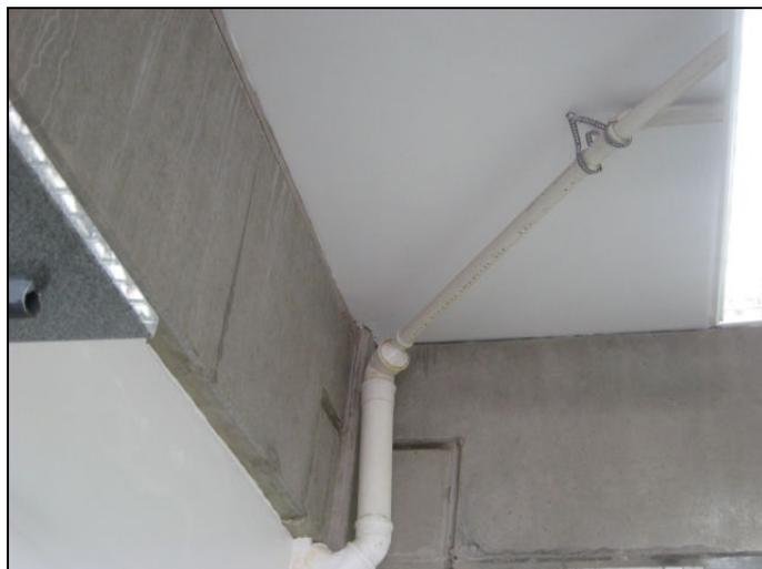
**Figura 4.15** – Tubulações aparentes do SPES no pavimento térreo
