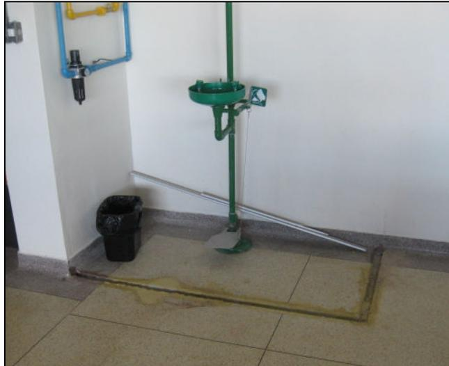
**Figura 4.18** - Adequação de piso para captação de água do chuveiro lava-olhos (Projeto B)
