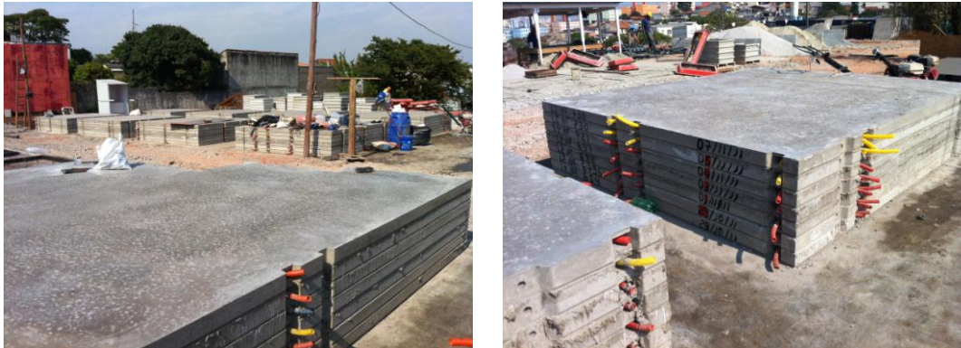
Figura 106 – Lajes nível zero pré-moldadas Fonte: Fotos enviadas pela EMPRESA 4 (Apêndice 2)
