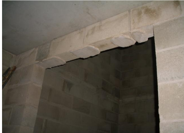
Figura 103 – Verga de porta pronta realizada com blocos canaleta. Detalhe para a argamassa seca grudada na face interna do vão
