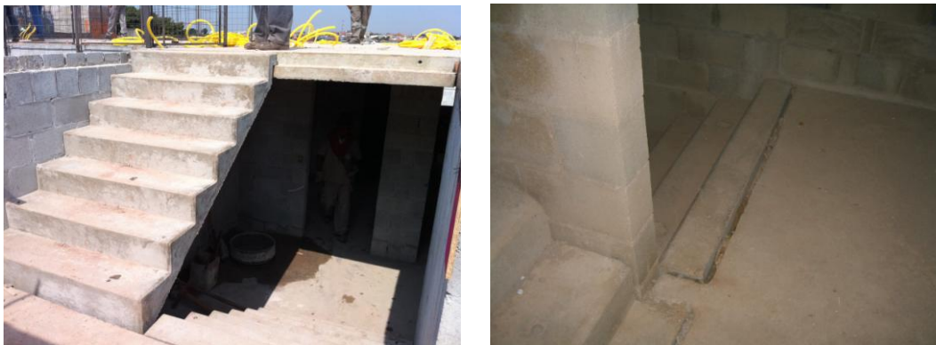
Figura 108 – Escadas pré-moldadas de concreto. Obras em alvenaria estrutural Fonte: Foto 1 Fornecida pela EMPRESA 4. Foto 2 tirada pela autora em visita a obra da EMPRESA 1 (Apêndice 2)
