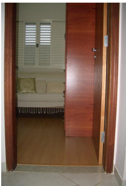
Figura 119 – Influência dimensional da folha da porta no vão livre Fonte: Foto tirada pela autora
