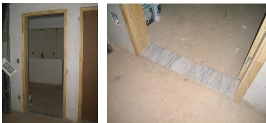
Figura 110 – Entrada da unidade habitacional. Desnível representado pela soleira Fonte: Foto tirada pela autora em visita a obra da EMPRESA 1 (Apêndice 2)
