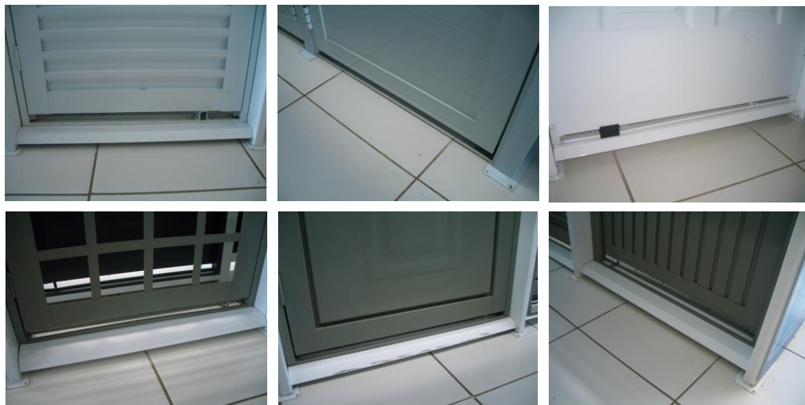
Figura 133 – Portas de aço com e sem pintura e portas de alumínio. Diferentes fabricantes. Detalhe para variação na distância da travessa em relação à folha Fonte: Fotos tiradas pela autora
