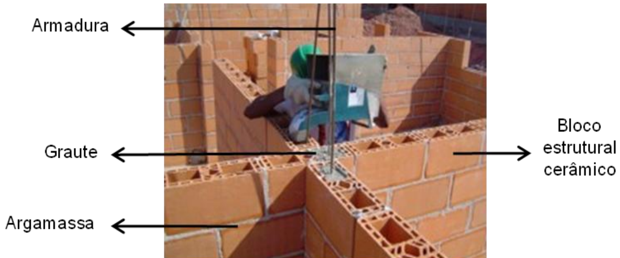
Figura 17 – Exemplo de obra em alvenaria estrutural de blocos cerâmicos, destaque para bloco estrutural, argamassa, armadura e graute
