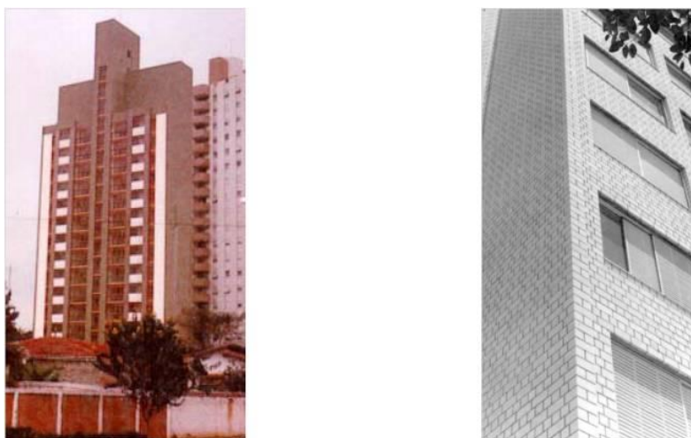
Figura 22 – Edifício Muriti, São José dos Campos. Edifício Jardim Prudência, São Paulo Fonte: ABCI (1990)
