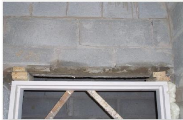
Figura 3 – Porta não modular instalada na alvenaria estrutural Fonte: DM2 METALÚRGICA (a) (2011)
