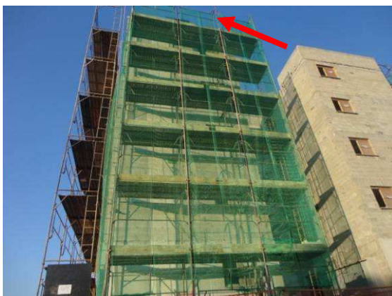
Figura 6.23 – Vista frontal de andaime fachadeiro – Obra 3
