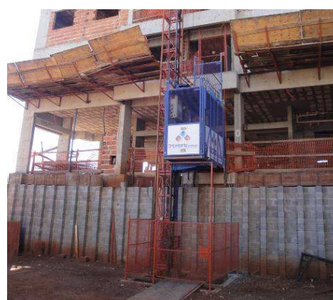
Figura 6.157 – Barreira de proteção da torre do elevador – Obra 1
