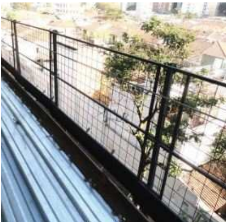
Figura 4.22 - GcR em laje stell deck – Orman
