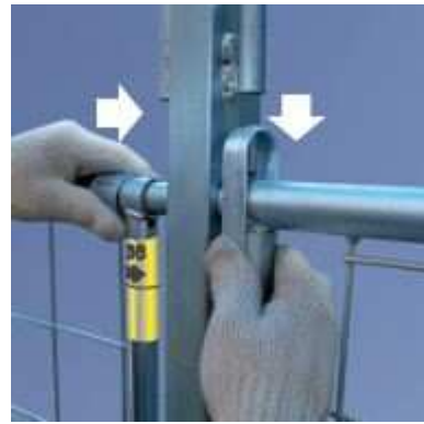
Figura 4.33 - Encaixe de placas de GcR ScanMetal
