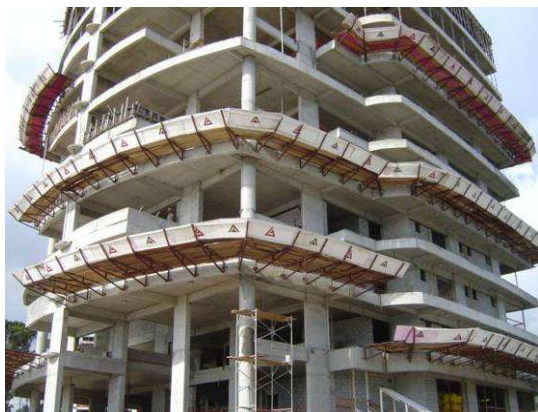
Figura 4.76 – Plataformas de proteção - MetroForm
