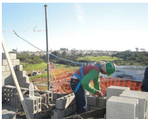
Figura 6.43 – GcR constituído por cordas e tela de fechamento – Obra 2
