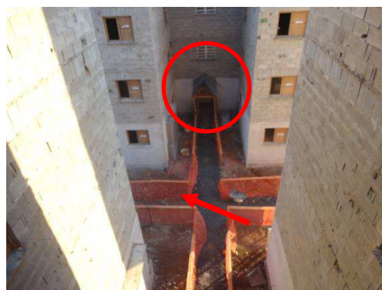
Figura 6.95 – GcR para isolamento periférico das torres – Obra 9
