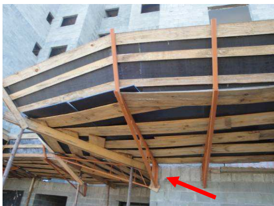
Figura 6.100 – Plataforma de proteção principal – Obra 2
