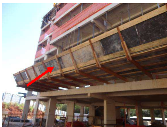
Figura 6.98 – Inclinação do complemento da plataforma de proteção – Obra 8
