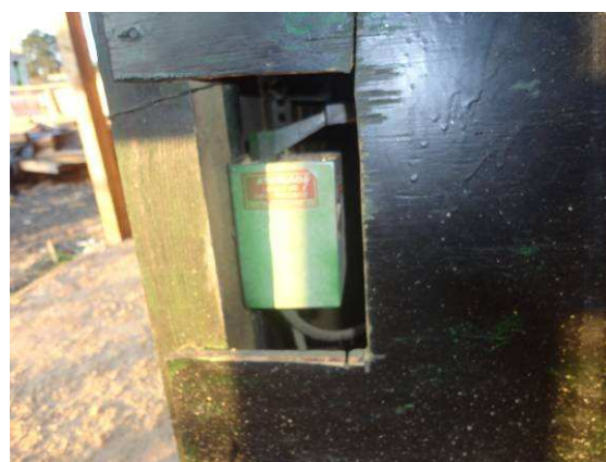
Figura 6.133 – Chave rotativa de duas posições com proteção – Obra 3
