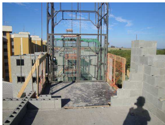
Figura 6.159 – Rampa e GcR de acesso a guincho – Obra 2
