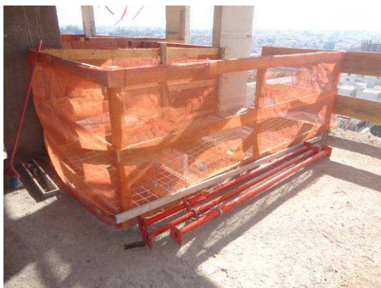
Figura 6.77 – GcR em madeira para proteção do poço do elevador – Obra 7
