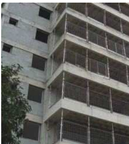
Figura 4.60 – Sistema GcR com fixação por postes - Perame
