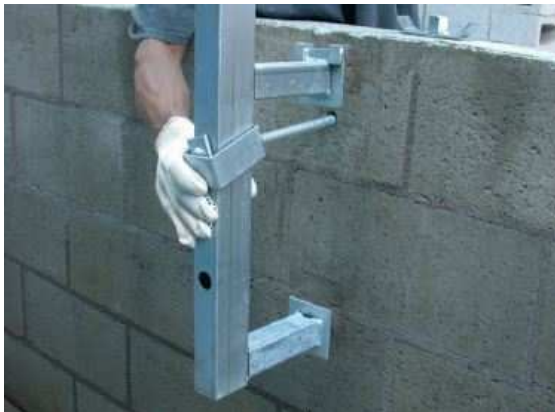
Figura 4.30 – Colocação de parafuso para fixação de poste do sistema ScanMetal
