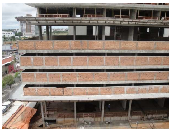
Figura 4.78 – Plataforma principal com forramento em chapa metálica
