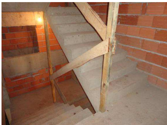
Figura 6.55 – GcR da escada de uso coletivo – Obra 4
