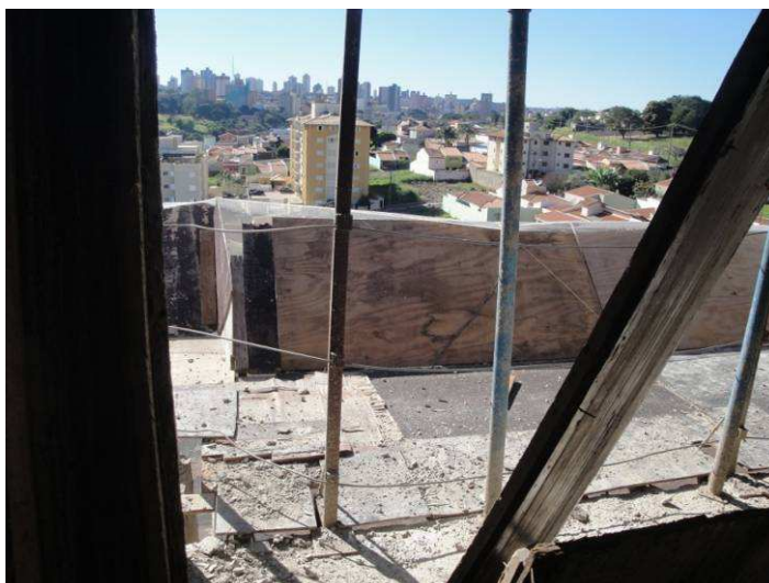
Figura 6.36 – Sistema GcR empregado nas lajes a serem concretadas – Obra 1
