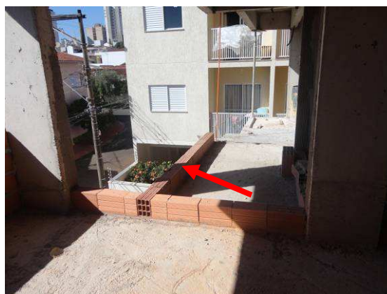
Figura 6.54 – Trecho da periferia da torre sem GcR para proteção – Obra 4
