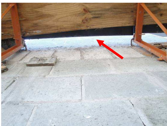
Figura 6.113 – Distância entre plataforma primária o limite da torre – Obra 2
