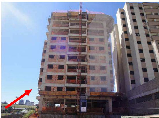
Figura 6.96 – Plataforma de proteção – Obra 1
