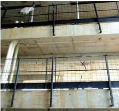
Figura 4.20 - GcR em estrutura moldada no local - Orman
