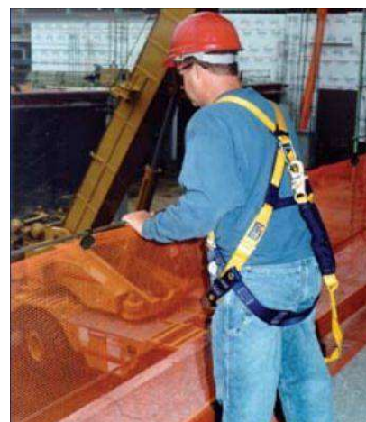
Figura 4.42 - GcR composto por cabo de aço e rede de proteção
