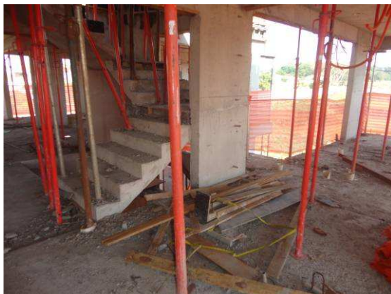
Figura 6.86 – Escada de uso coletivo sem GcR – Obra 8
