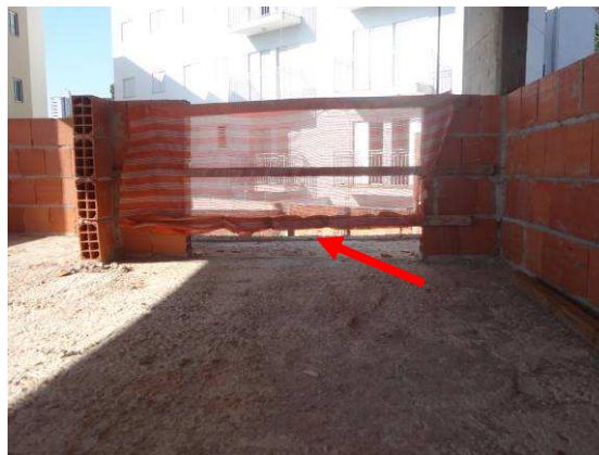
Figura 6.74 – GcR em madeira com rodapé elevado – Obra 7
