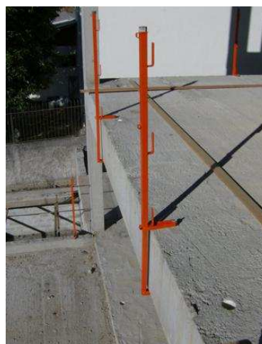
Figura 4.57 - Fixação de montante tipo sargento
