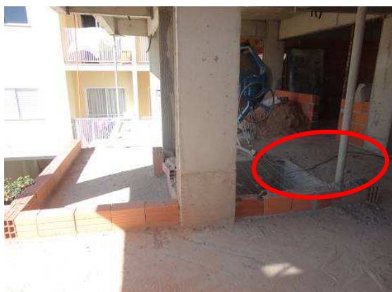
Figura 6.145 –Condutor elétrico para betoneira inadequado – Obra 6
