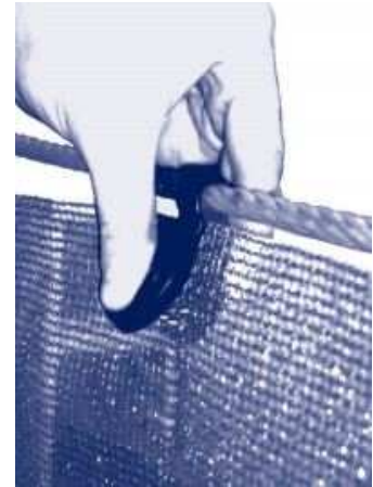
Figura 4.45 – Colocação de clipes em rede
