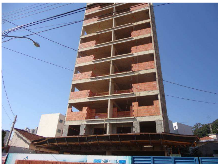
Figura 6.8 – Vista da Obra 7
