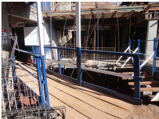
Figura 6.59 – GcR em madeira – Obra 5
