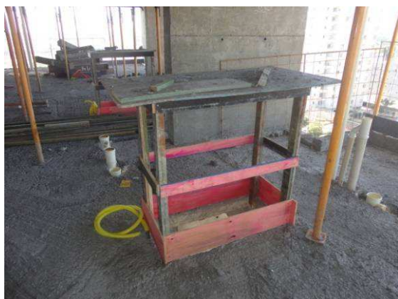
Figura 6.11 – Proteção de abertura de piso – Obra 6
