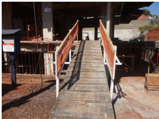
Figura 6.29 – Rampa provisória – Obra 8
