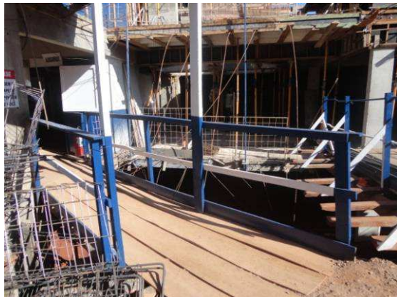
Figura 6.31 – Rampa provisória – Obra 5
