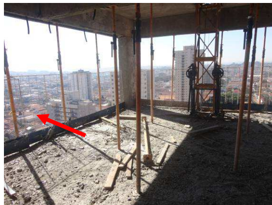
Figura 6.60 – GcR metálico – Obra 5
