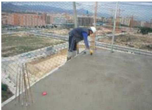
Figura 4.50 - Colocação de dispositivo embutido, durante a concretagem, de dispositivo para fixação de GcR
