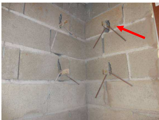
Figura 6.47 – Fixação de GcR metálico modular – Obra 3
