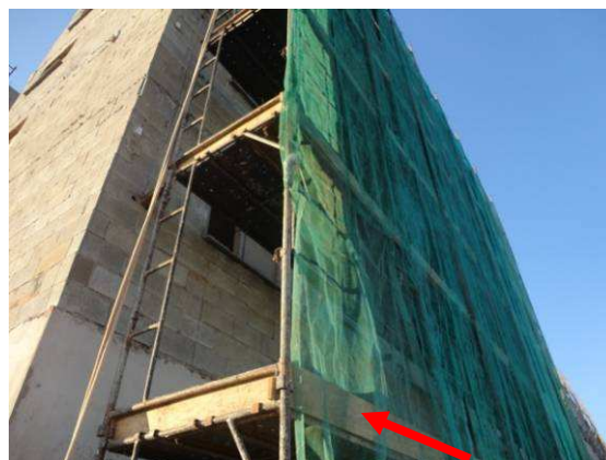
Figura 6.24 – Vista lateral de andaime fachadeiro – Obra 3
