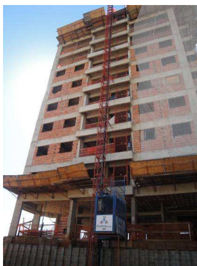
Figura 6.160 – Elevador cremalheira em movimento – Obra 1
