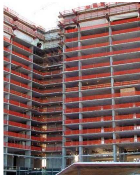
Figura 4.47 - Edificação com GcR em rede instalado
