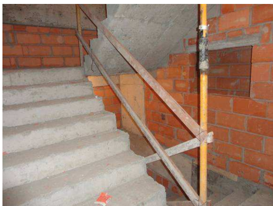
Figura 6.65 – GcR em madeira utilizado em escada de uso coletivo – Obra 5
