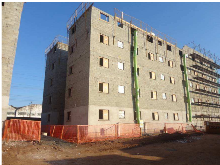
Figura 6.4 – Vista de um dos blocos da Obra 3
