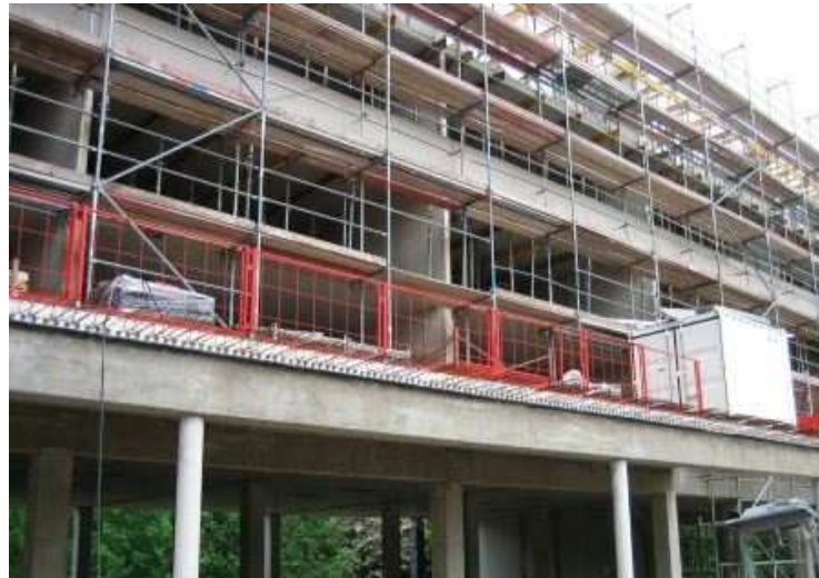
Figura 4.15 - Sistema de barreira Miller EPIC™ POST-N
