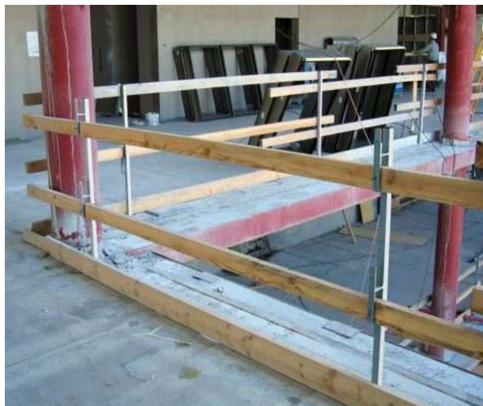
Figura 4.6 - Sistema de barreira Miller Epic ultra
