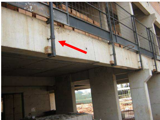
Figura 6.92 – Sistema de fixação do GcR Orman – Obra 9
