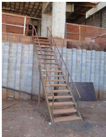
Figura 6.27 – Escada provisória – Obra 1
