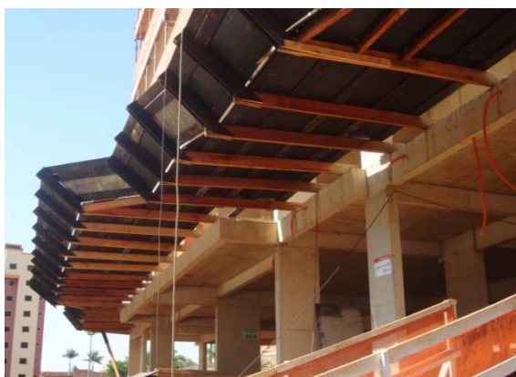
Figura 6.169 – Plataforma de proteção – Obra 8
