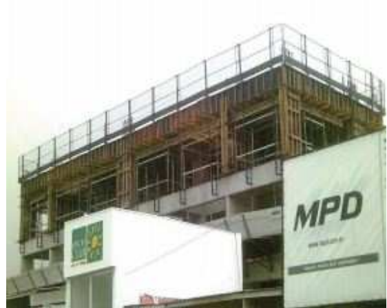
Figura 4.21 - GcR em concretagem - Orman
