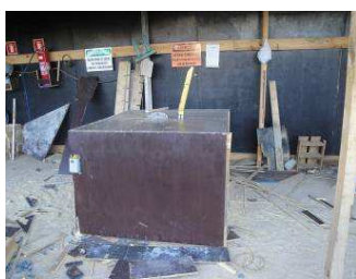
Figura 6.125 – Coifa protetora para serra circular – Obra 6
