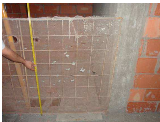
Figura 6.62 – Tela aplicada no GcR modular metálico – Obra 5
