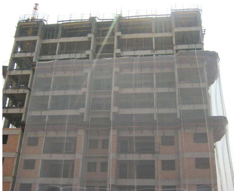
Figura 6.10 – Vista de uma das torres da Obra 9
