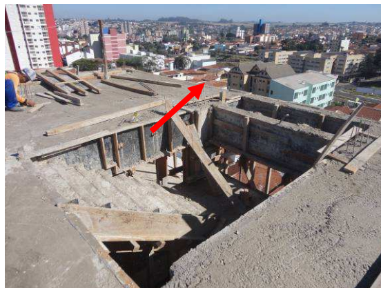
Figura 6.58 – Pavimento sem GcR instalado – Obra 4
