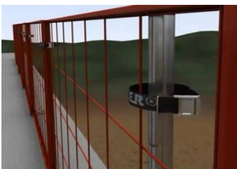
Figura 4.13 - Colocação de travas nos elementos Miller Post-N
