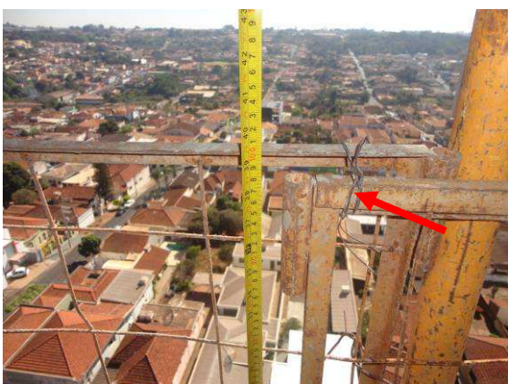
Figura 6.61 – Fixação de GcR metálico com arame – Obra 4
