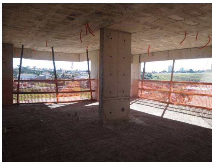
Figura 6.35 – Pavimento com GcR para proteção periférica – Obra 1
