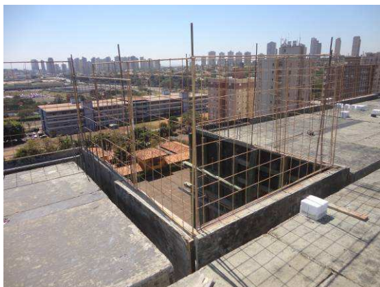
Figura 6.67 – GcR metálico em periferia de laje à ser concretada – Obra 6
