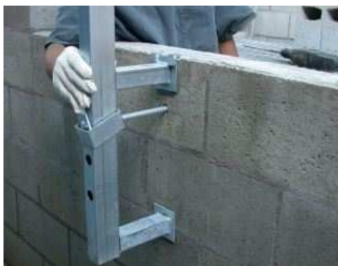
Figura 4.66 - Fixação de GcR com parafuso - ScanMetal
