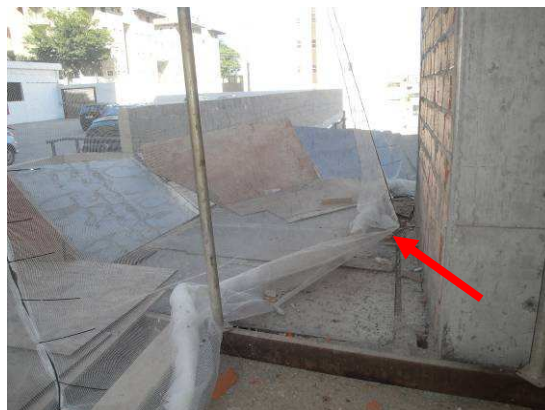
Figura 6.106 – Fixação da parte inferior da tela de proteção – Obra 1
