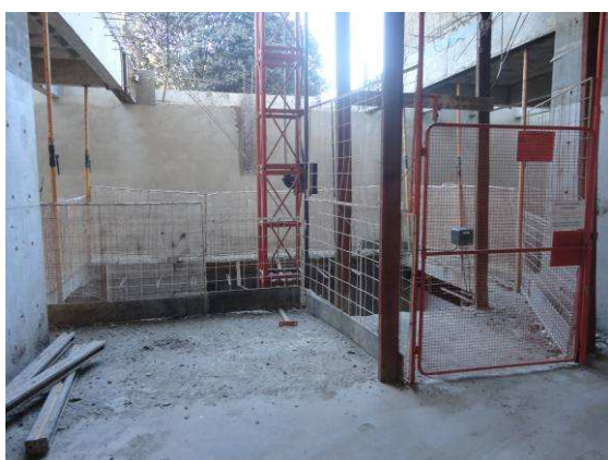
Figura 6.156 – Barreira de proteção da torre do elevador – Obra 5
