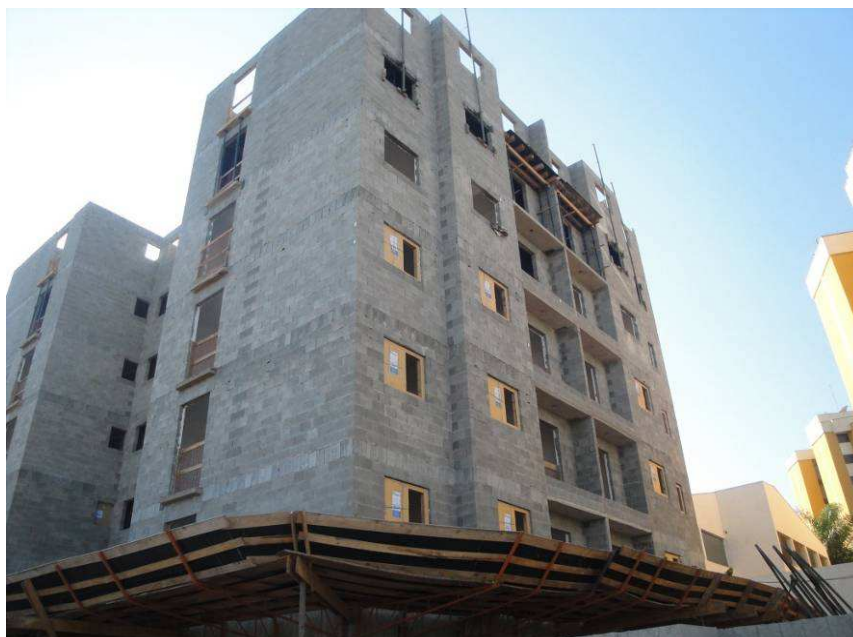
Figura 6.3 – Vista de uma das torres da Obra 2
