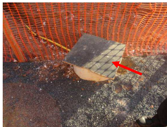
Figura 6.14 – Fechamento provisório de piso – Obra 3
