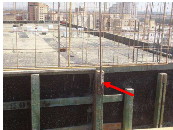
Figura 6.68 – Fixação de GcR metálico em forma de viga de borda – Obra 6
