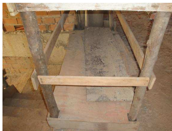
Figura 6.12 – Proteção de abertura de piso – Obra 1
