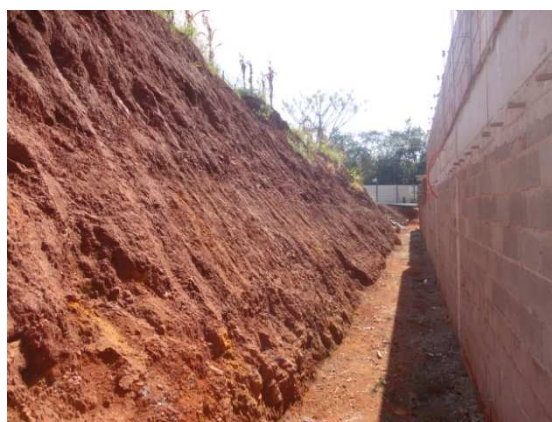
Figura 6.164 – Contenção do terreno no subsolo – Obra 8
