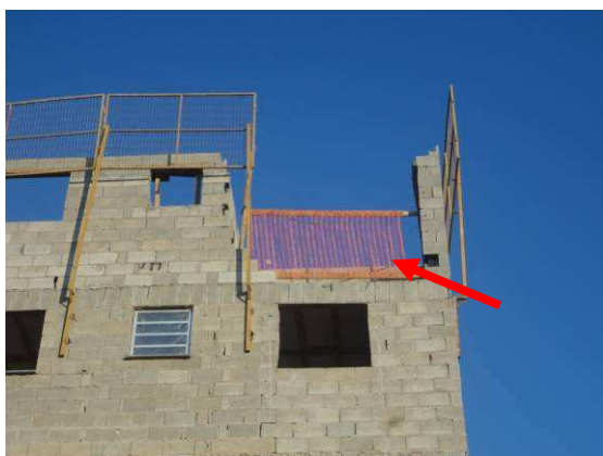
Figura 6.49 – GcR em madeira – Obra 3
