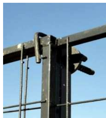
Figura 4.65 – Travamento de placas com parafuso - Orman
