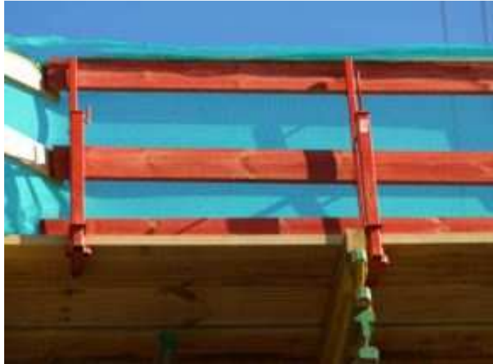
Figura 4.5 - GcR de madeira com montantes metálicos - Espanha
