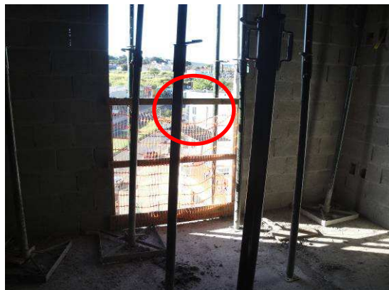
Figura 6.42 – Parte da periferia da torre sem GcR instalado – Obra 2
