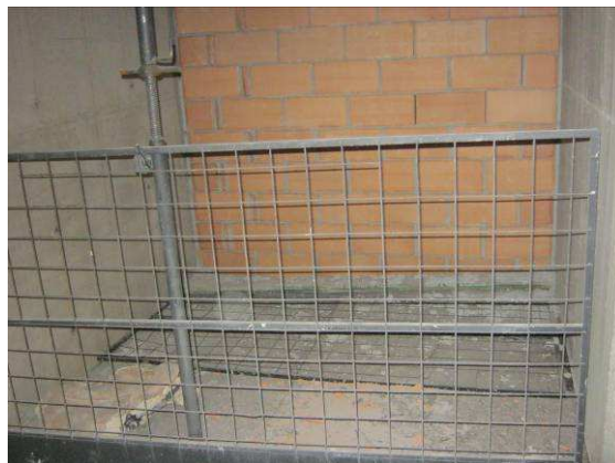
Figura 6.89 – Sistema GcR Orman para proteção de poço do elevador – Obra 9
