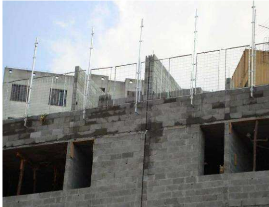
Figura 4.24 – Sistema MetroForm para alvenaria estrutural
