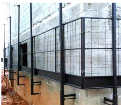
Figura 4.64 - Fixação de GcR com parafuso - Orman
