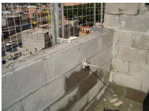
Figura 4.62 – Fixação de GcR com parafuso - MetroForm
