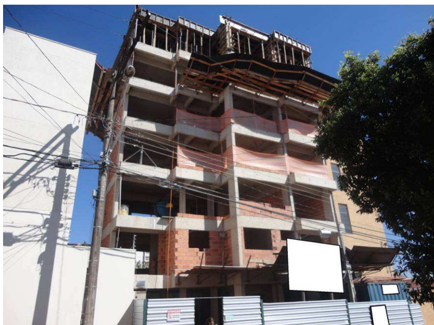
Figura 6.5 – Vista da Obra 4
