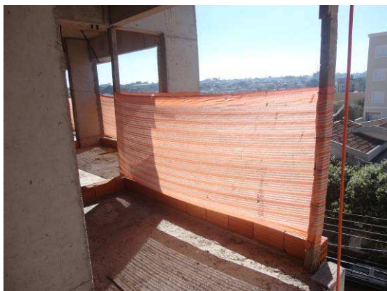
Figura 6.51 – Tela para aplicada na periferia da torre – Obra 4
