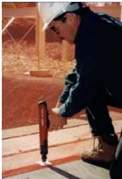
Figura 4.46 - Fixação inferior de GcR em rede
