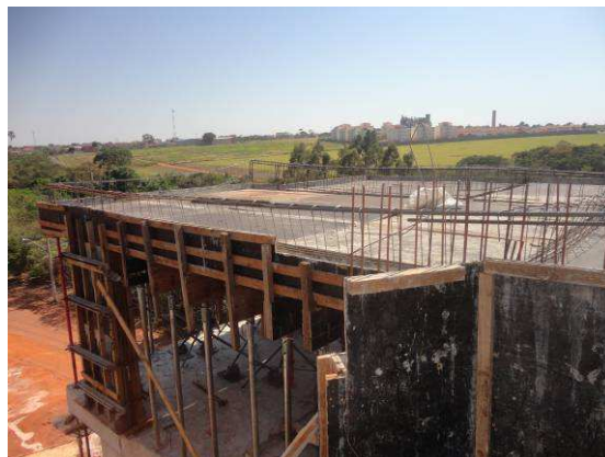
Figura 6.87 – 6º pavimento sem GcR para proteção periférica – Obra 8
