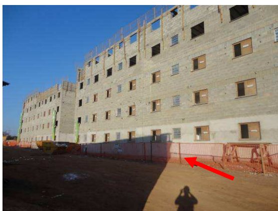
Figura 6.94 – Isolamento periférico das torres – Obra 3
