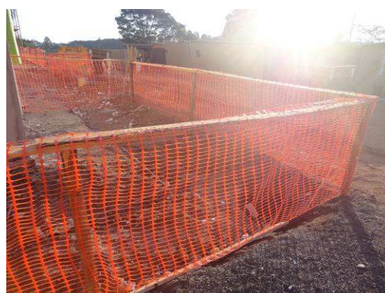
Figura 6.50 – GcR em madeira para evitar acesso a lateral do edifício - Obra 3
