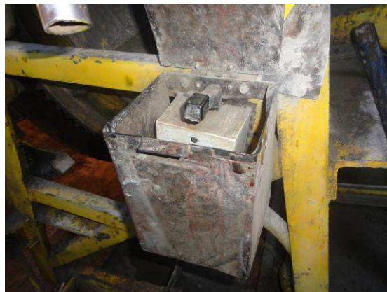
Figura 6.136 – Chave rotativa de duas posições com proteção – Obra 5
