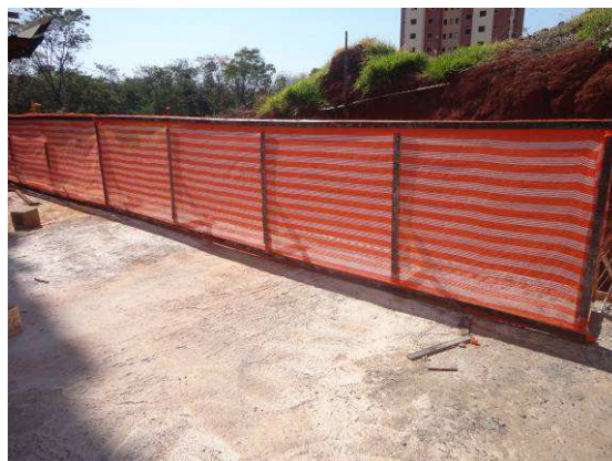
Figura 6.83 – GcR em madeira – Obra 8
