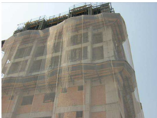
Figura 6.111 – Tela e plataforma de proteção– Obra 9
