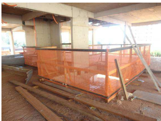
Figura 6.84 – GcR em madeira para proteção do poço do elevador do térreo – Obra 8
