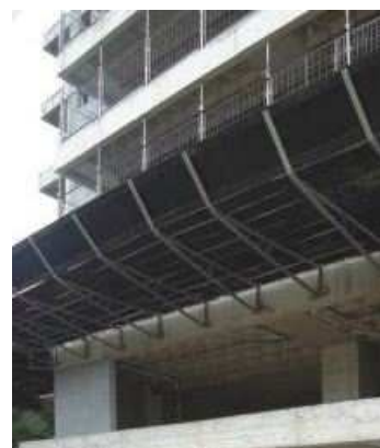
Figura 4.77 – Plataforma de proteção primária - Perame
