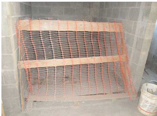
Figura 6.41 – GcR para fechamento do poço do elevador – Obra 2
