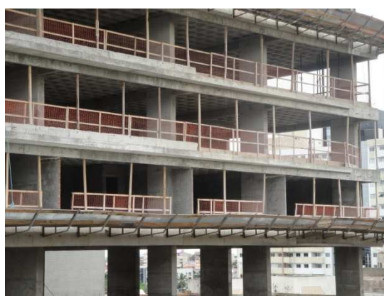
Figura 4.79 – Plataforma secundária com forramento em chapa metálica
