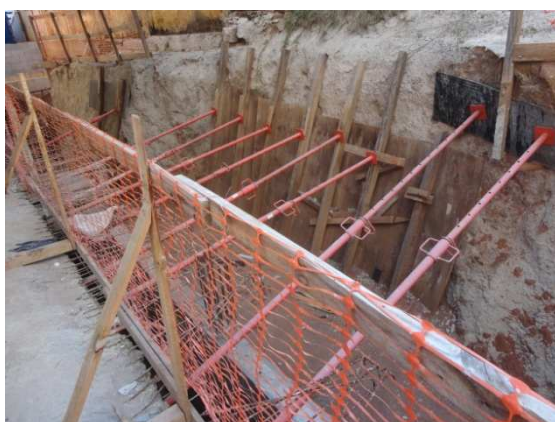
Figura 6.163 – Contenção do terreno no subsolo – Obra 7
