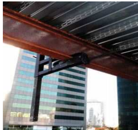
Figura 4.23 - Fixação de montantes de GcR em laje stell deck - Orman
