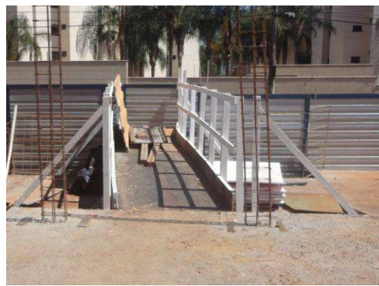
Figura 6.32 – Rampa provisória – Obra 6
