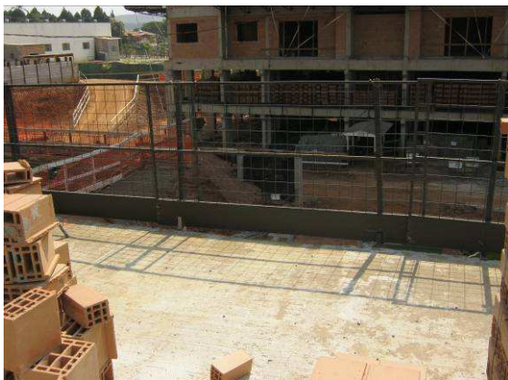
Figura 6.88 – Sistema GcR Orman para proteção periférica de laje – Obra 9
