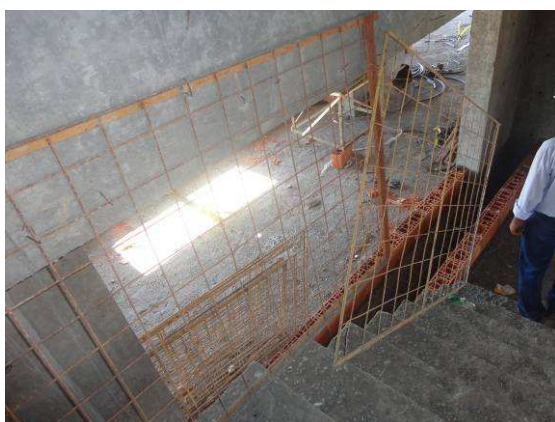
Figura 6.71 – GcR metálico para proteção lateral de escada de uso coletivo – Obra 6
