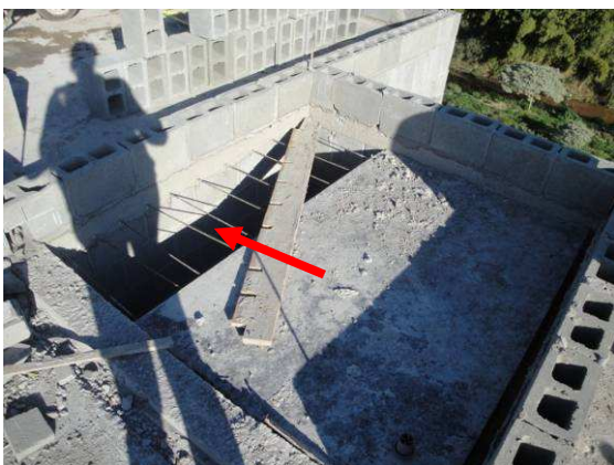
Figura 6.13 – Fechamento provisório de piso – Obra 2
