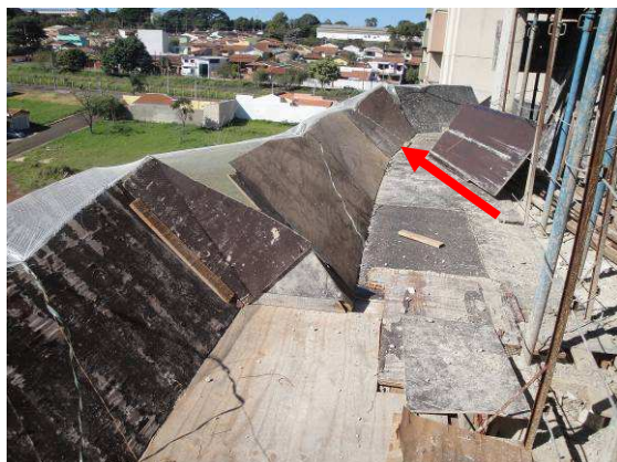
Figura 6.107 – Fixação superior de tela de proteção instalada entre plataformas de proteção – Obra 1
