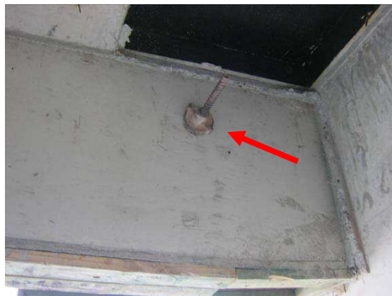
Figura 6.93 – Porca para fixação do sistema GcR Orman – Obra 9
