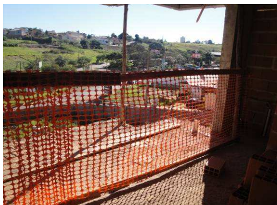
Figura 6.33 – GcR em madeira sem travessa intermediária – Obra 1
