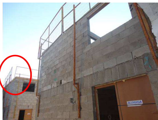
Figura 6.48 – GcR metálico modular – Obra 3
