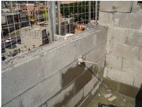
Figura 4.26 – Fixação de sistema MetroForm para alvenaria estrutural
