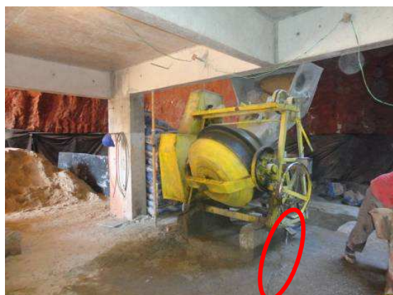
Figura 6.145 –Condutor elétrico para betoneira inadequado – Obra 6
