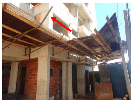
Figura 6.99 – Plataforma de proteção principal – Obra 4
