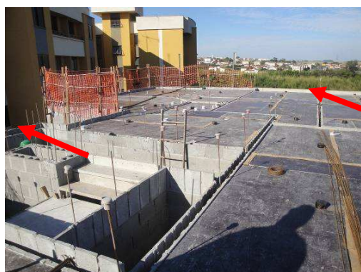
Figura 6.40 – Parte da periferia da torre sem GcR instalado – Obra 2
