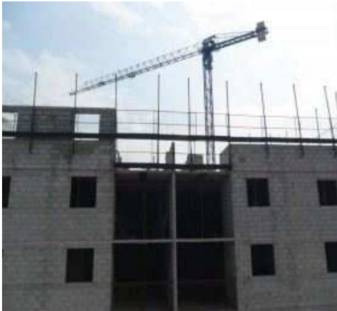
Figura 4.18 - GcR - Alvenaria estrutural - Orman
