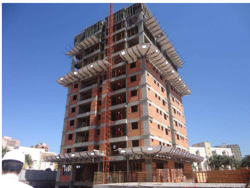
Figura 6.7 – Vista da Obra 6
