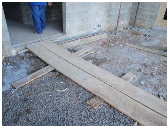
Figura 6.30 – Rampa provisória – Obra 2
