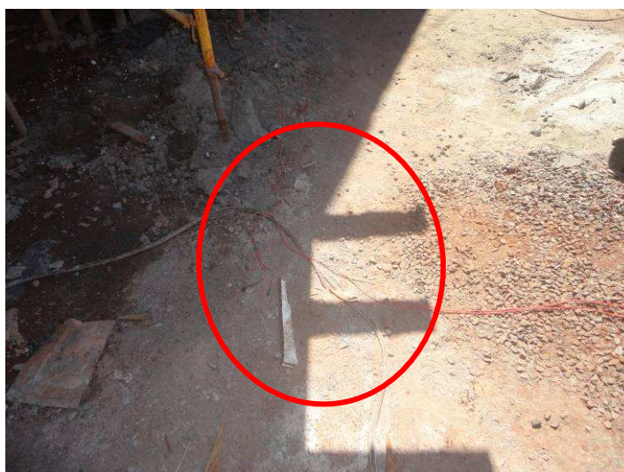
Figura 6.145 –Condutor elétrico para betoneira inadequado – Obra 6
