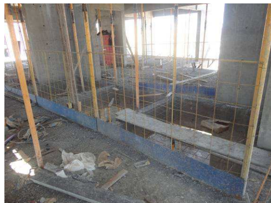
Figura 6.70 – GcR metálico com montantes a cada 1,5 m – Obra 6
