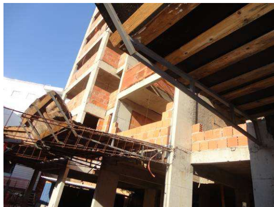
Figura 6.97 – Plataforma de proteção – Obra 7
