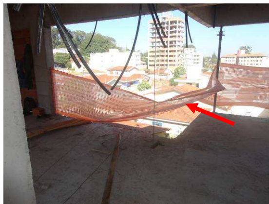
Figura 6.52 – Fixação de tela aplicada na periferia da torre por arame – Obra 4
