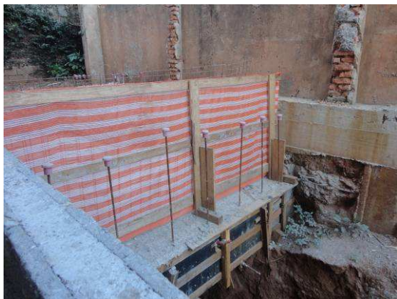
Figura 6.73 – GcR em madeira com tela de fechamento – Obra 7
