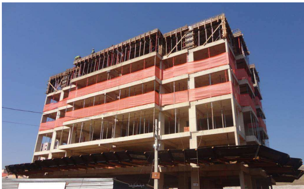
Figura 6.9 – Vista da Obra 8
