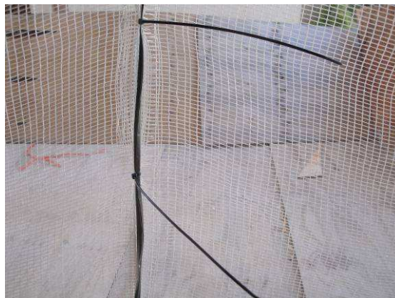
Figura 6.108 – Fechamento entre trechos de tela de proteção – Obra 1
