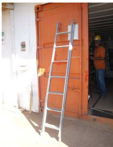
Figura 6.25 – Escada de mão – Obra 2
