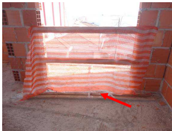
Figura 6.76 – GcR em madeira para fechamento da varanda – Obra 7
