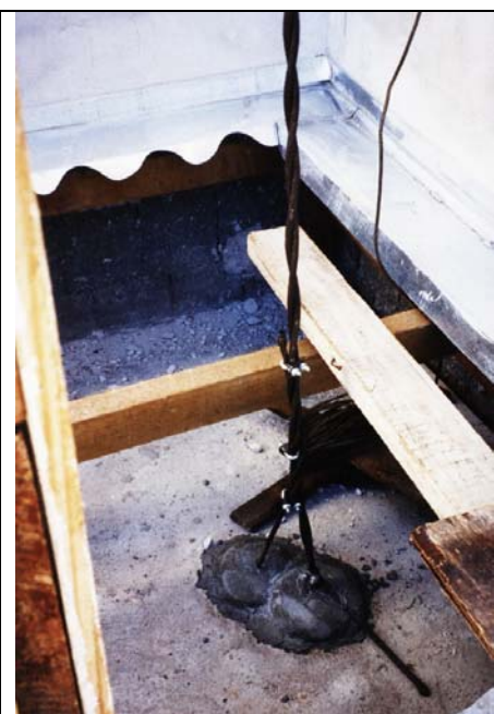
Figura 17 - Fixação de andaime suspenso com cabo de aço em furo de laje, deixado embaixo do telhado
