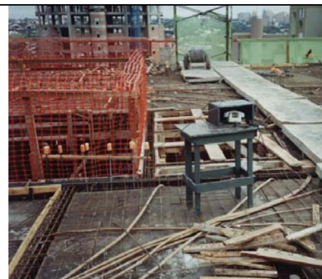
Figura 25 – GcR em madeira e tela
