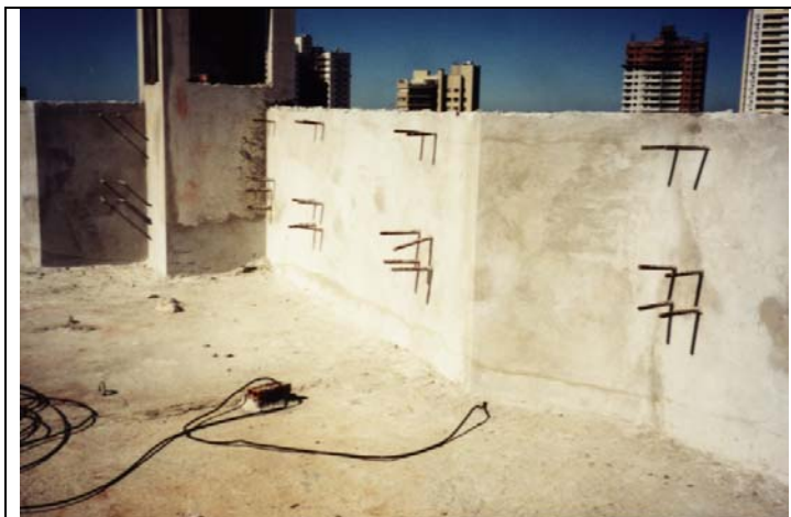
Figura 24 – Sistema para manutenções com andaimes suspensos
