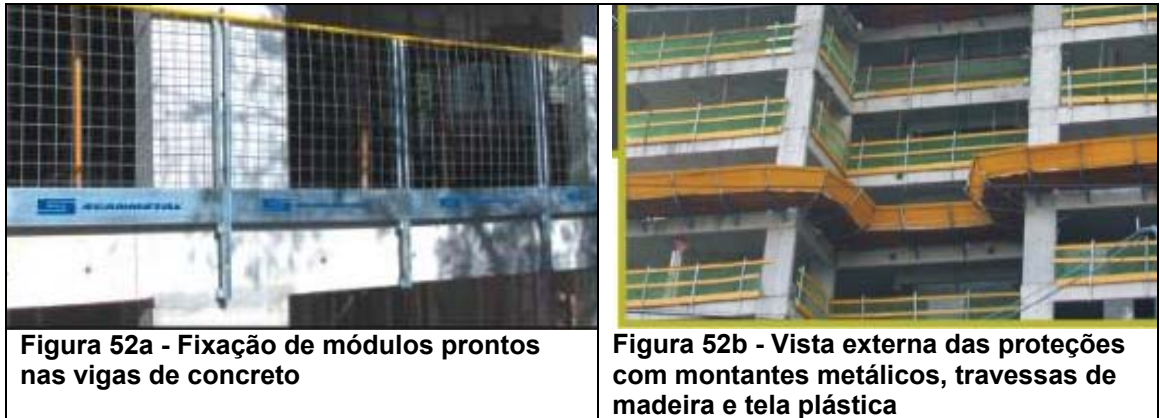
Figura 52 – GcR fixado pelo lado externo da estrutura Fonte: Scanmetal (2003)
