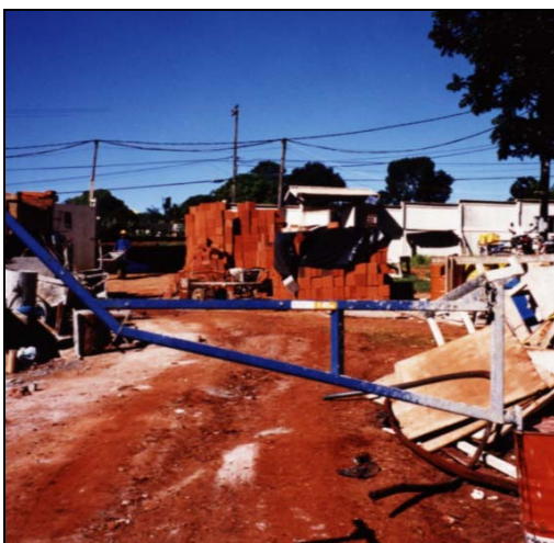
Figura 15 - Viga metálica da Gethal para instalação de plataformas de limitação de quedas de materiais
