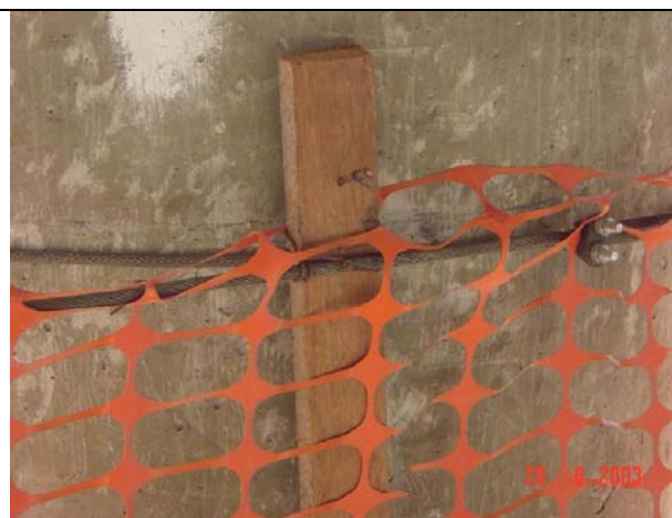
Figura 34 – Fixação da barreira com rede com madeira
