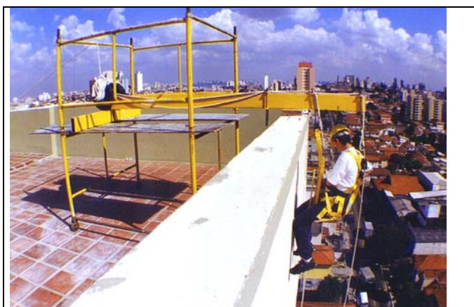
Figura 65 - Cadeira suspensa sustentada por contrapesos.
