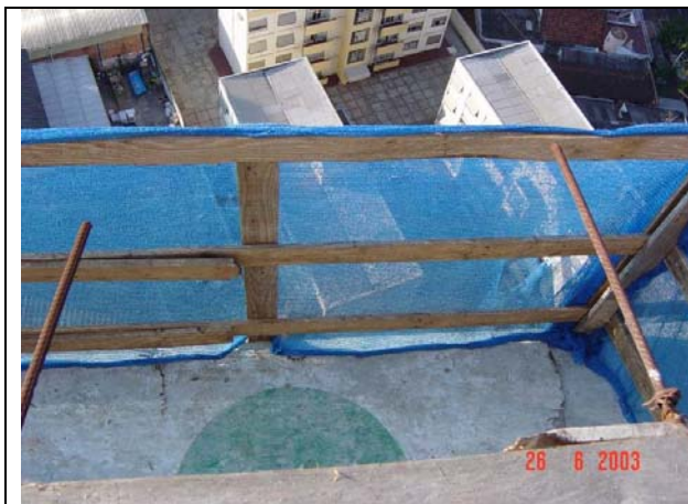
Figura 29 - GcR em andaime suspenso
