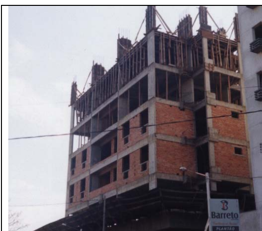
Figura 12 – Elevação de alvenaria sem plataforma secundária
