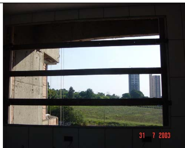
Figura 45 - Proteção provisória em aberturas de janelas
