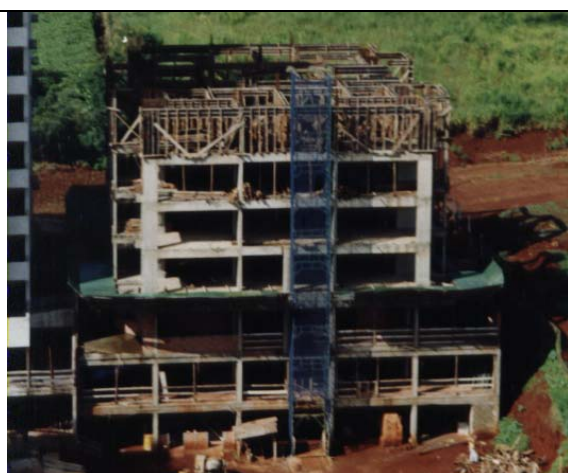
Figura 13 – Confeção de formas sem plataforma secundária
