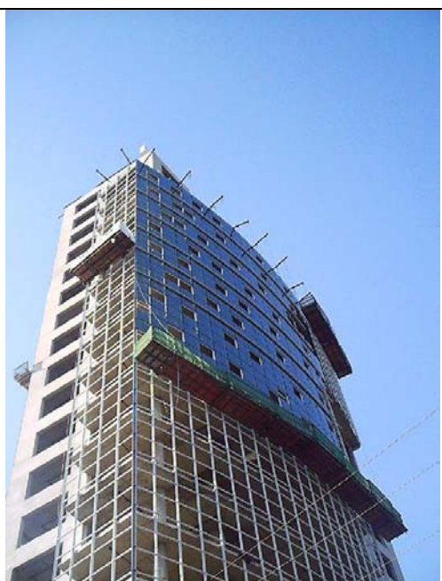
Figura 18 - Andaime suspenso utilizado para instalação de structural glassing
