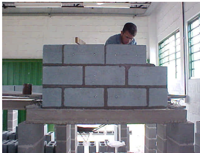
Figura 53: Parede com pastilhas coladas nos blocos sendo executada
