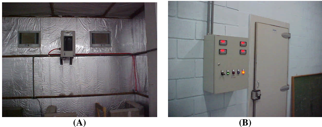
Figura 47: (A) Câmara climatizada para resfriamento; (B) Controle externo da câmara climatizada
