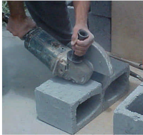
Figura 51: Corte de meio bloco
