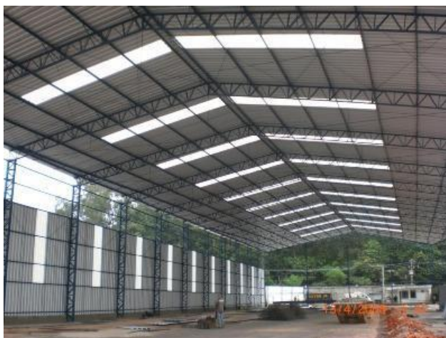
Figura 6 – Galpão com pilares treliçados em aço.
