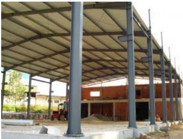
Figura 5 – Exemplo de galpões com pilar em alma cheia;
