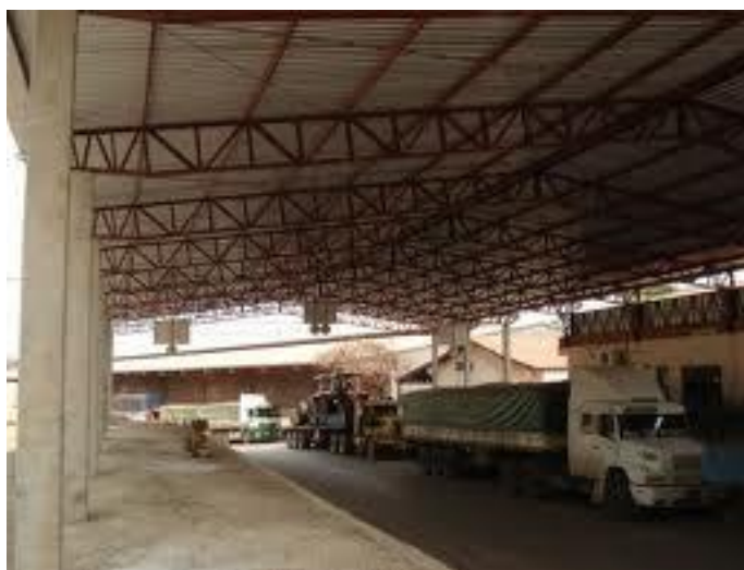
Figura 7 - Galpões com pilares em concreto e treliças metálicas. Fonte: Matpar pré-fabricados;
