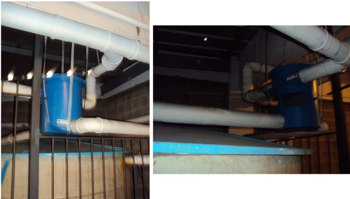
Figura 16. Filtro Residencial VF1 3P Technik – Edifício Tipo. Fonte: Autor
