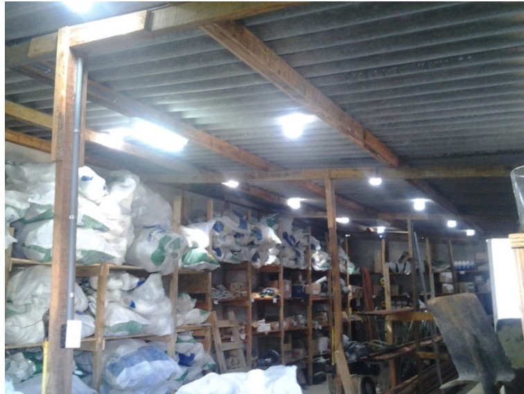
Figura 39 – Iluminação com garrafas PET
