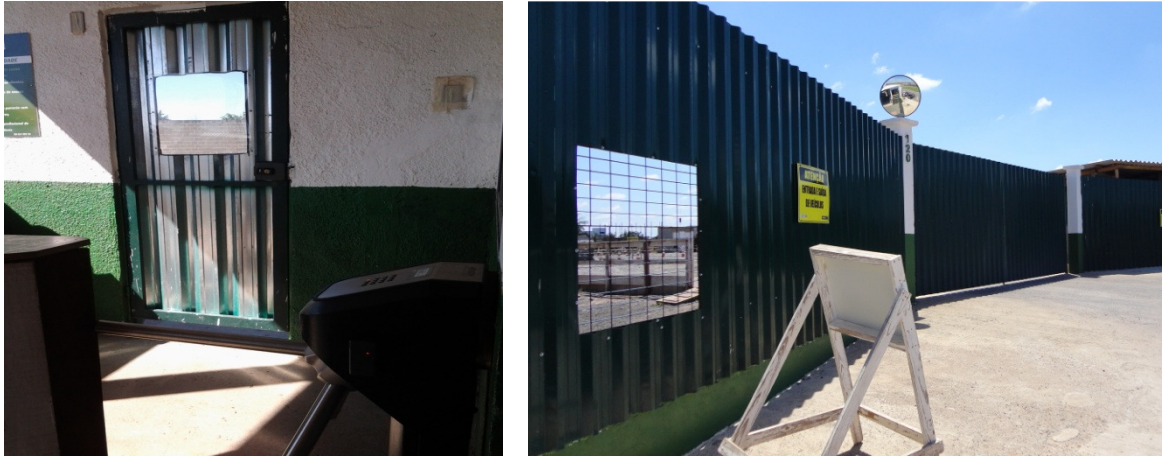
Figura 76 – Entradas ao canteiro de obras pedestres x veículos
