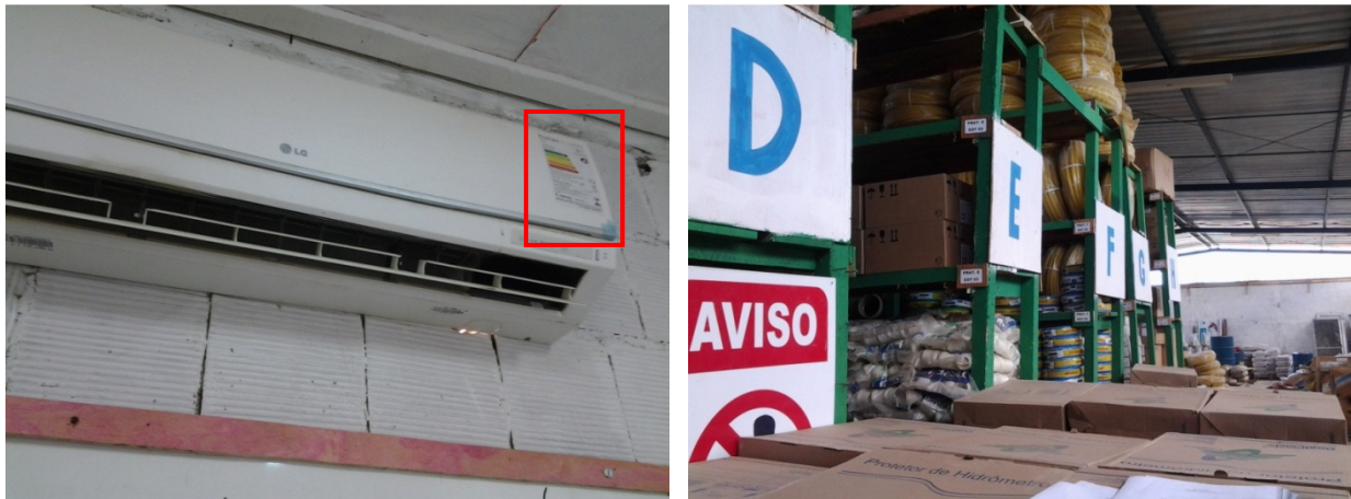
Figura 66 – Escritório com equipamento não emissor de CFC e almoxarifado organizado
