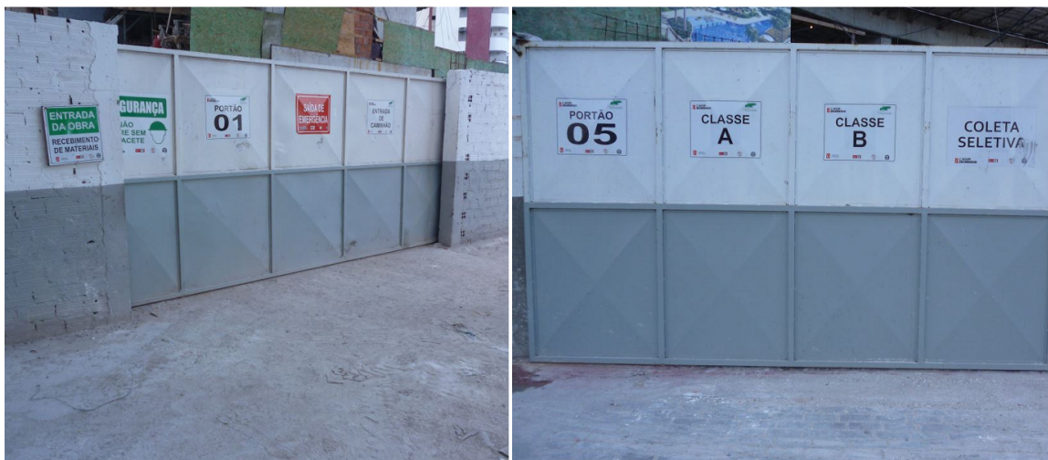
Figura 96 – Descarregamento de materiais e portões de resíduos
