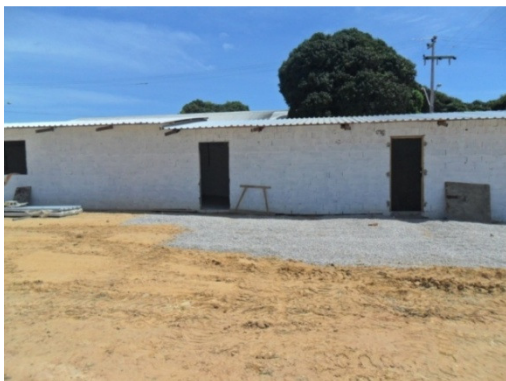
Figura 27 – Instalações provisórias da Obra A externamente – escritórios e banheiros
