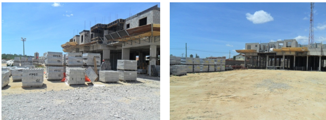
Figura 31 – Armazenamento de blocos de concreto próximo ao local de uso
