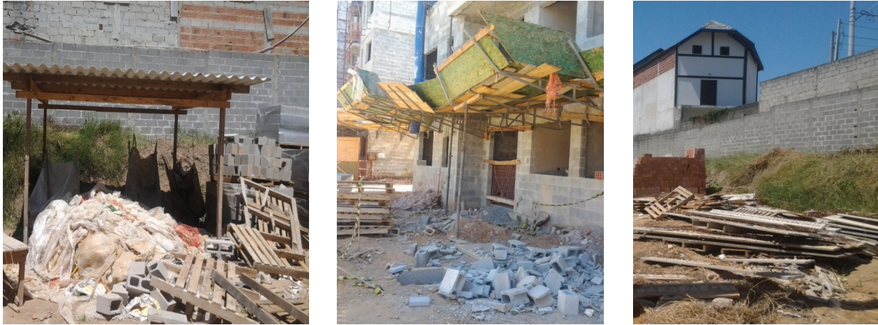
Figura 43 - Armazenamento de resíduos
