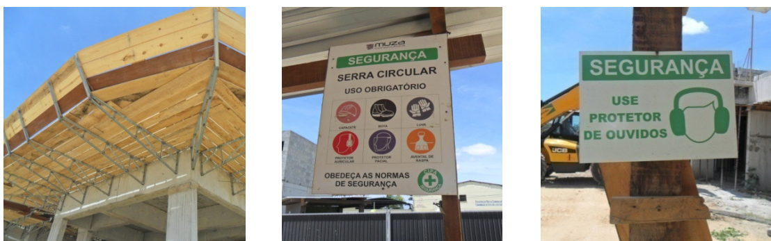
Figura 32 – Bandejas de segurança e incentivo para uso de EPI
