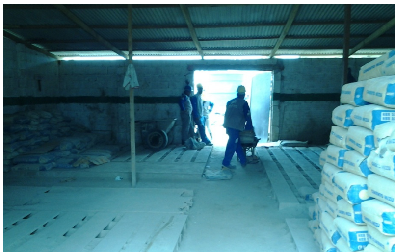
Figura 70 – Estoque de cimento Obra D
