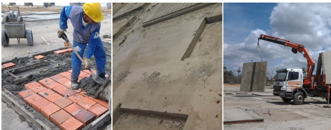
Figura 60 – Etapas de produção, secagem, e transporte
