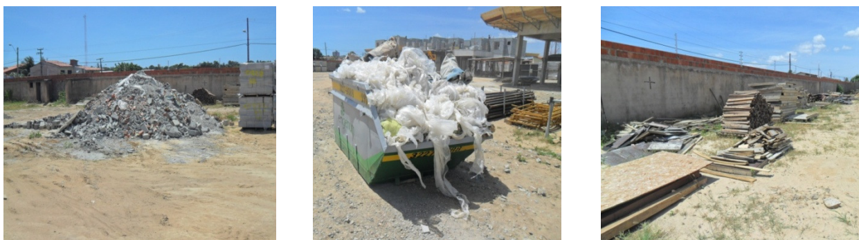
Figura 33 – Disposição dos resíduos da obra
