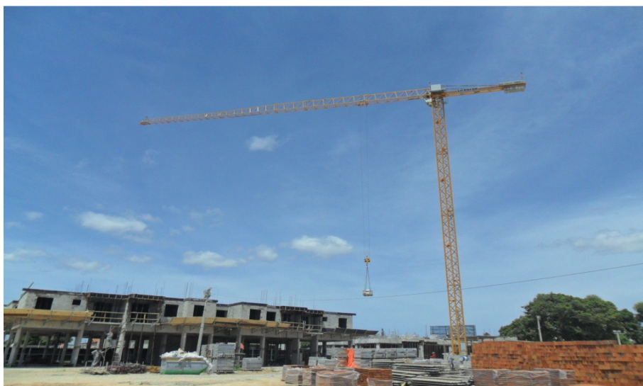
Figura 25 - Visão do canteiro
