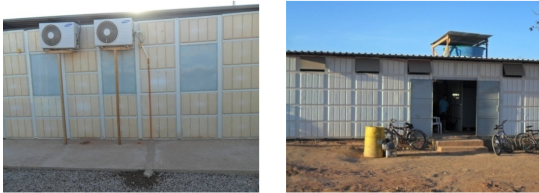
Figura 51 – Instalações provisórias de plástico reciclado
