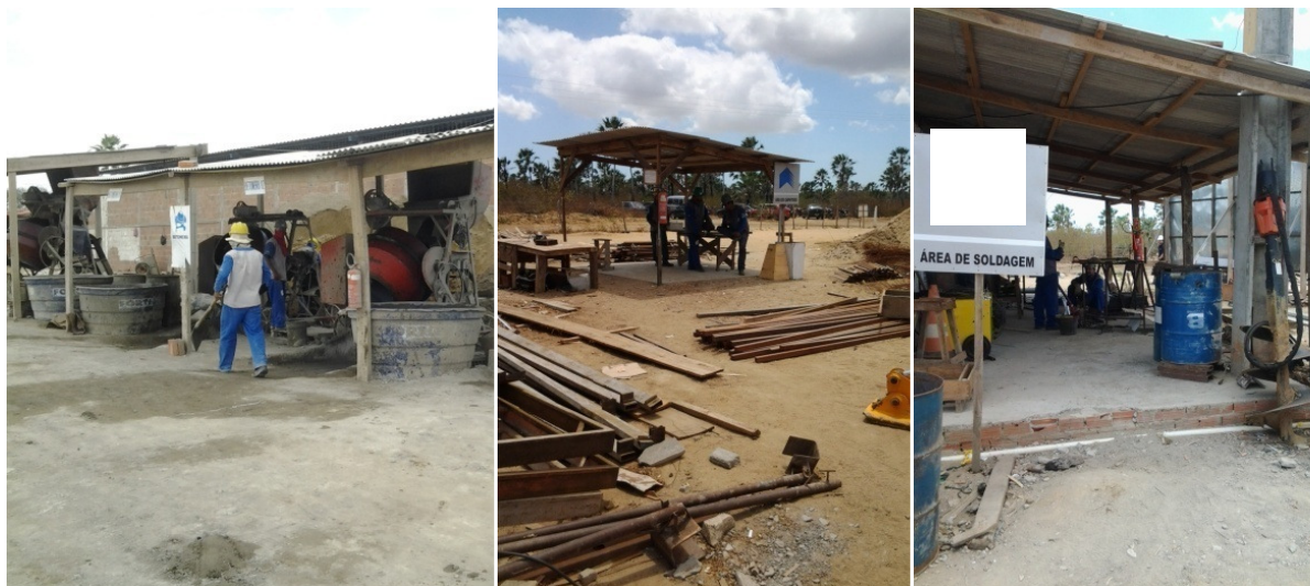
Figura 74 – Local de trabalho dos operários Obra D
