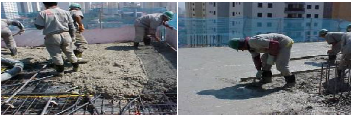
Figura 8 - Exemplo de concretagem no local da obra
