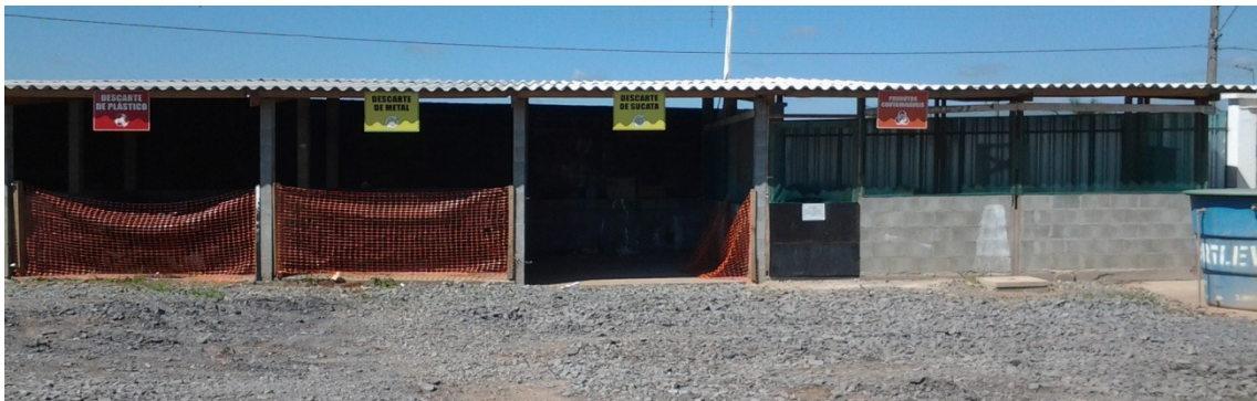
Figura 86 – Baias de separação dos resíduos obra E
