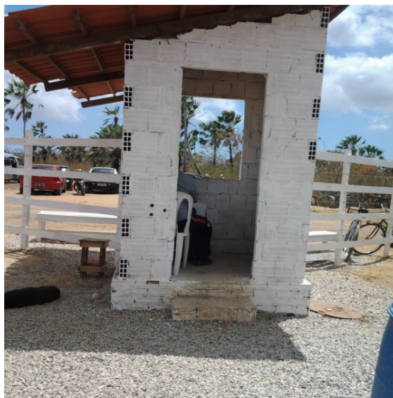
Figura 73 – Guarita de entrada no canteiro Obra D
