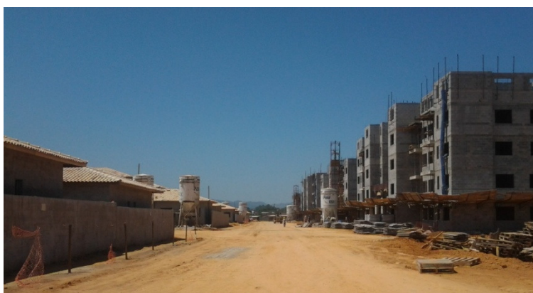
Figura 35 – Visão do canteiro da Obra B
