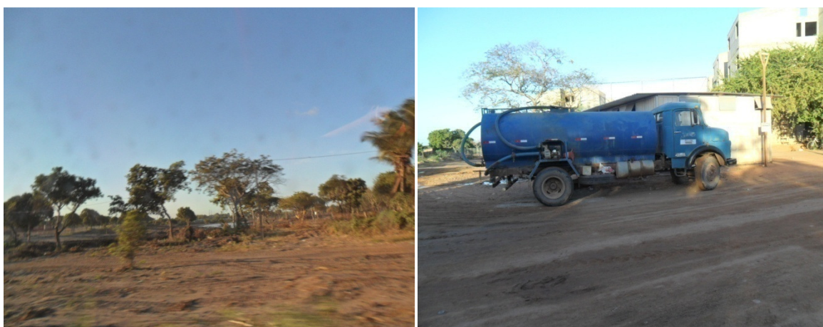
Figura 54 – Preservação da vegetação natural e irrigação de água no canteiro
