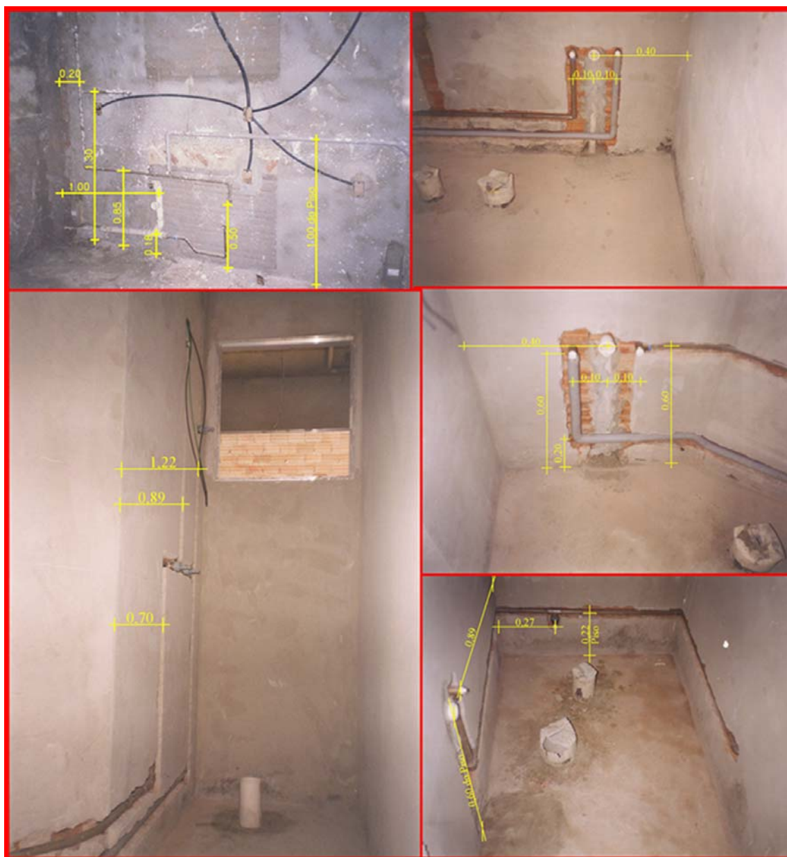
Figura 48 Fotografias para um “as built”: instalação hidráulica e elétrica
