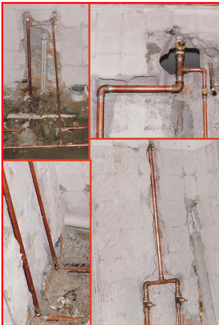
Figura 49 Fotografias para um “as built” de reparos em tubulação hidráulica
