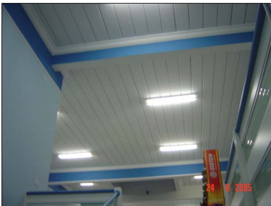
Figura 6.10 – Teto com aplicação de massa corrida e pintura
