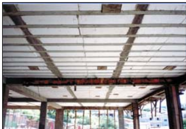
Figura 2.1 – Laje pré-moldada unidirecional com utilização de elemento de enchimento em EPS. Disponível em: http://www.gerdau.com.br
