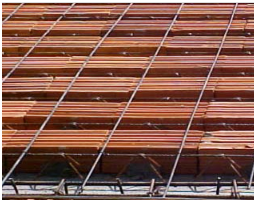
figura 2.13- tijolos cerâmicos de 6 furos usados em pré-laje. (Arquivo do autor).
