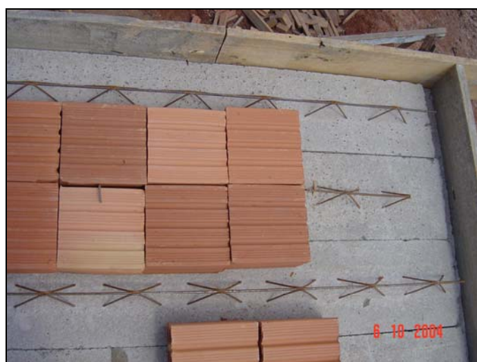
Figura 5.3 – detalhe da colocação dos elementos de enchimento. Arquivo do autor.
