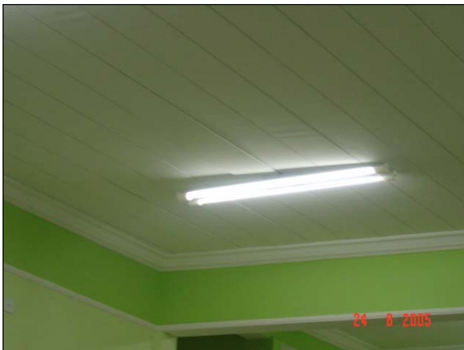
Figura 6.9 – Teto com aplicação de massa corrida e pintura
