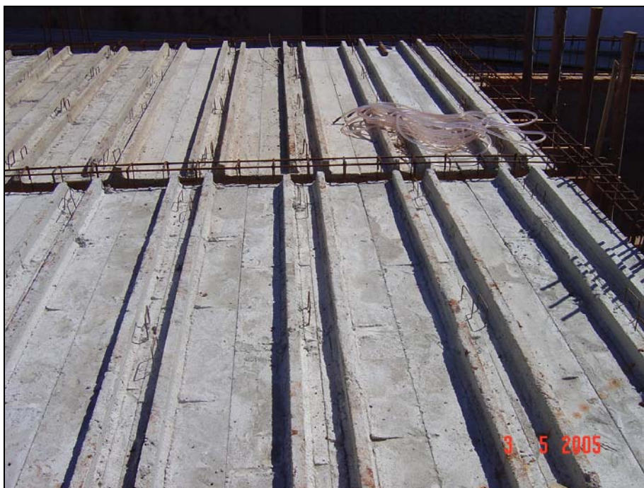
Figura 6.5 – Vista dos painéis na fase de montagem
