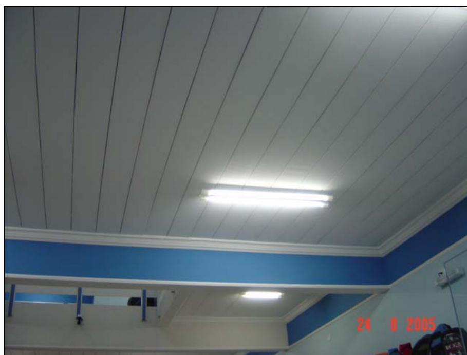
Figura 6.8 – Teto com aplicação de massa corrida e pintura
