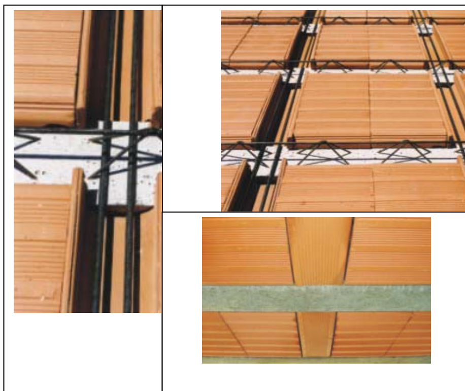
figura 2.9 – canaleta para direção transversal. Disponível em < http://www.trefor.com.br >
