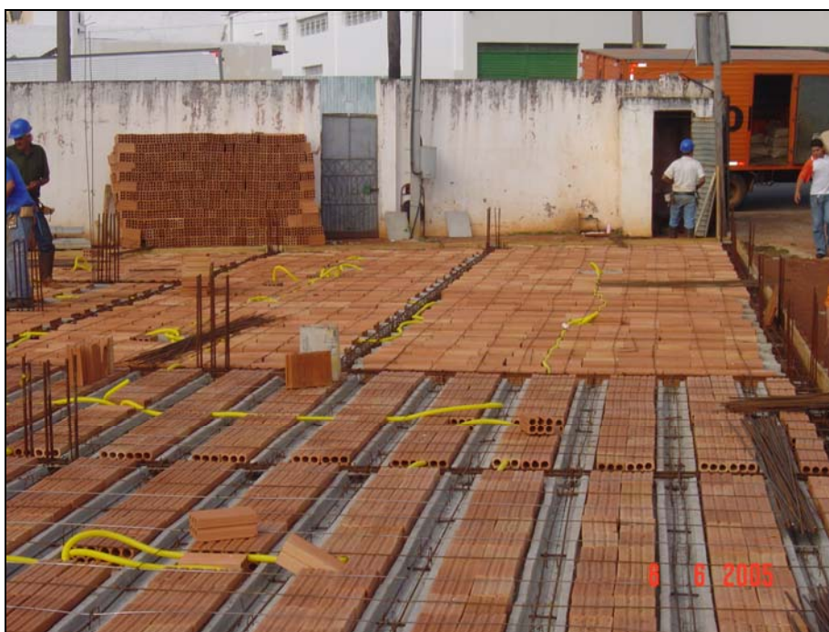
Figura 6.6 – Laje com armadura e elementos de enchimento
