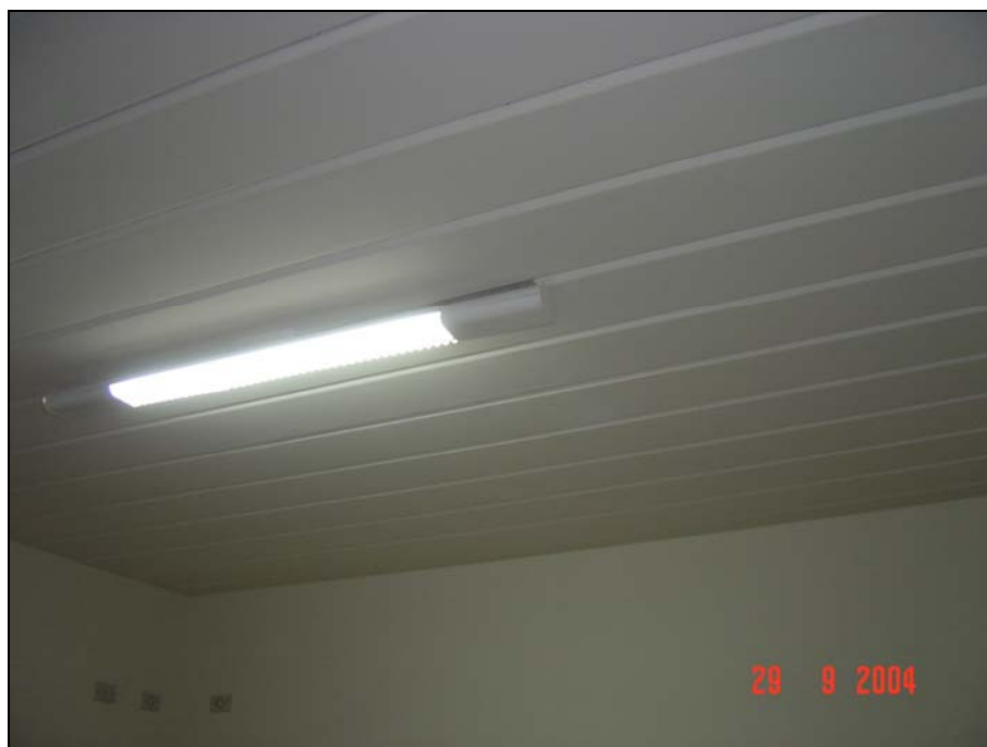
Figura 6.7 – Vista do teto somente com aplicação de tinta acrílica
