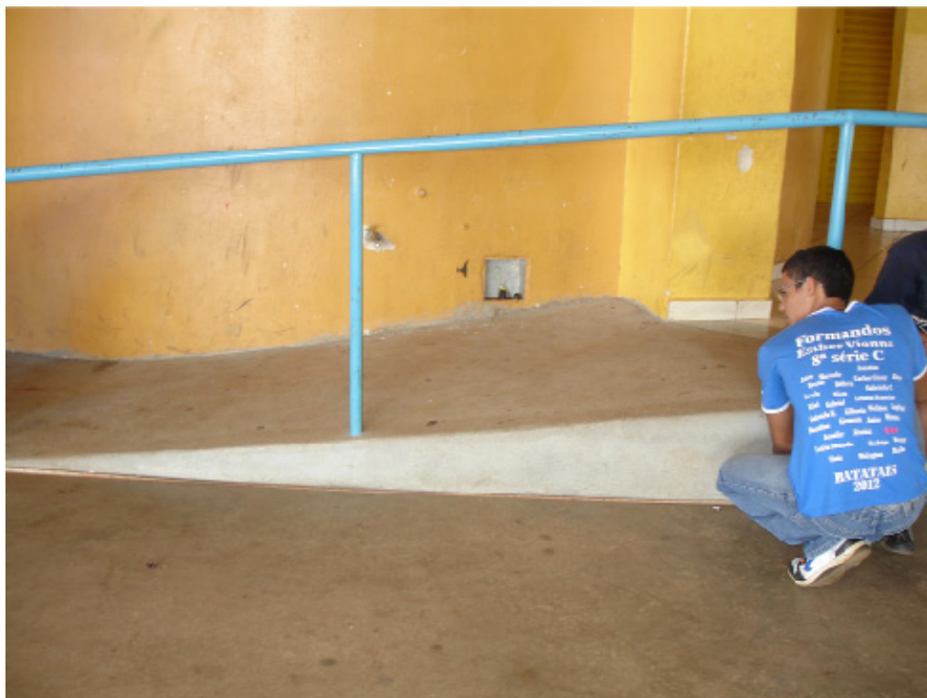
Figura 13 – Rampa de acesso ao palco da escola
