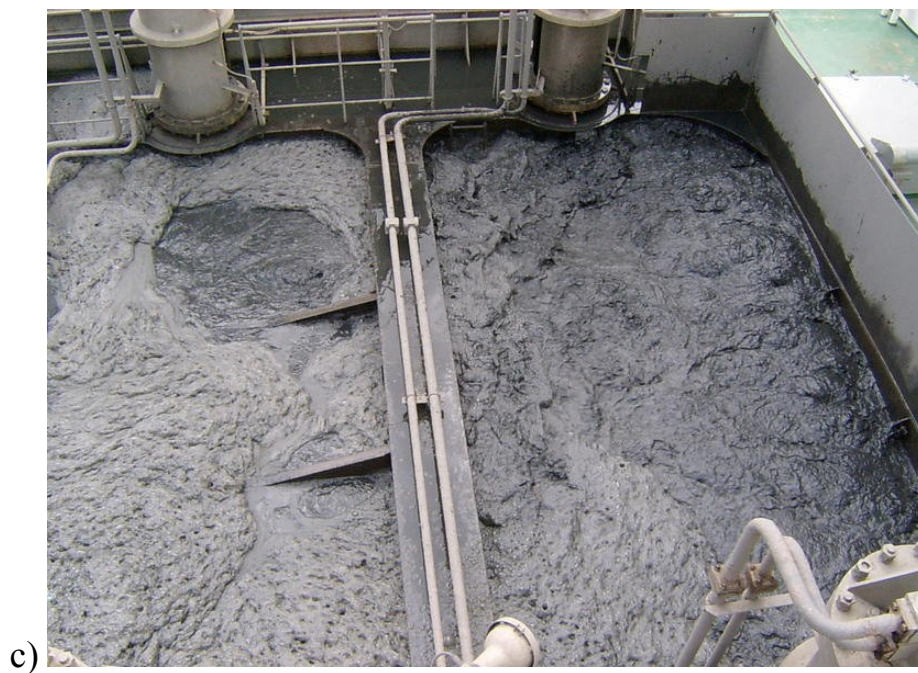
FIGURA 7. a) Imagem do overflow da draga Hang Jun 3001. b) Recolhimento do braço de dragagem. c) Interior da cisterna da draga Hang Jun 3001 no momento em que estava sendo realizada a dragagem.
