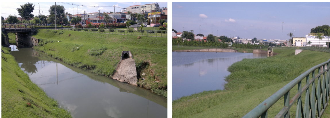
FIGURA 3.4 - Ponto 2, região de urbanização e captação de água.
