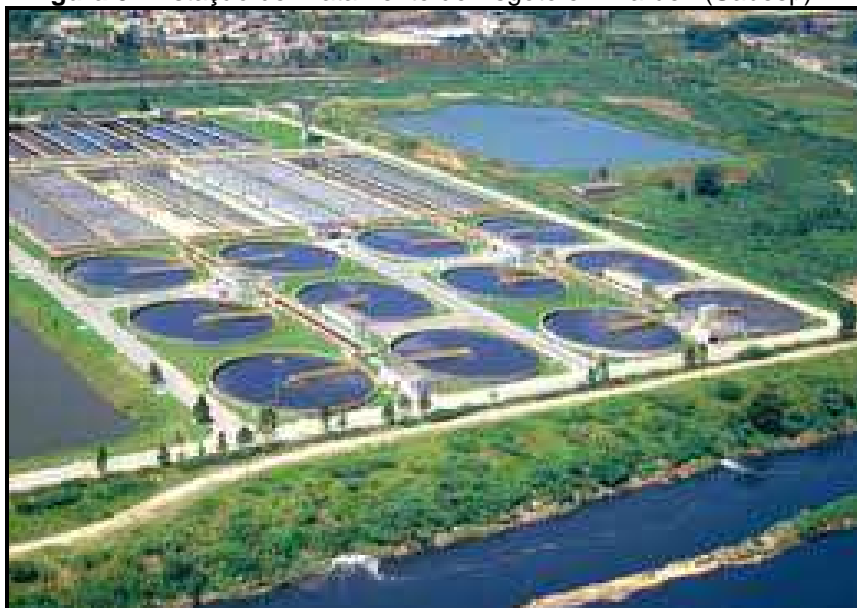
Figura 9 - Estação de Tratamento de Esgoto em Barueri (Sabesp).
