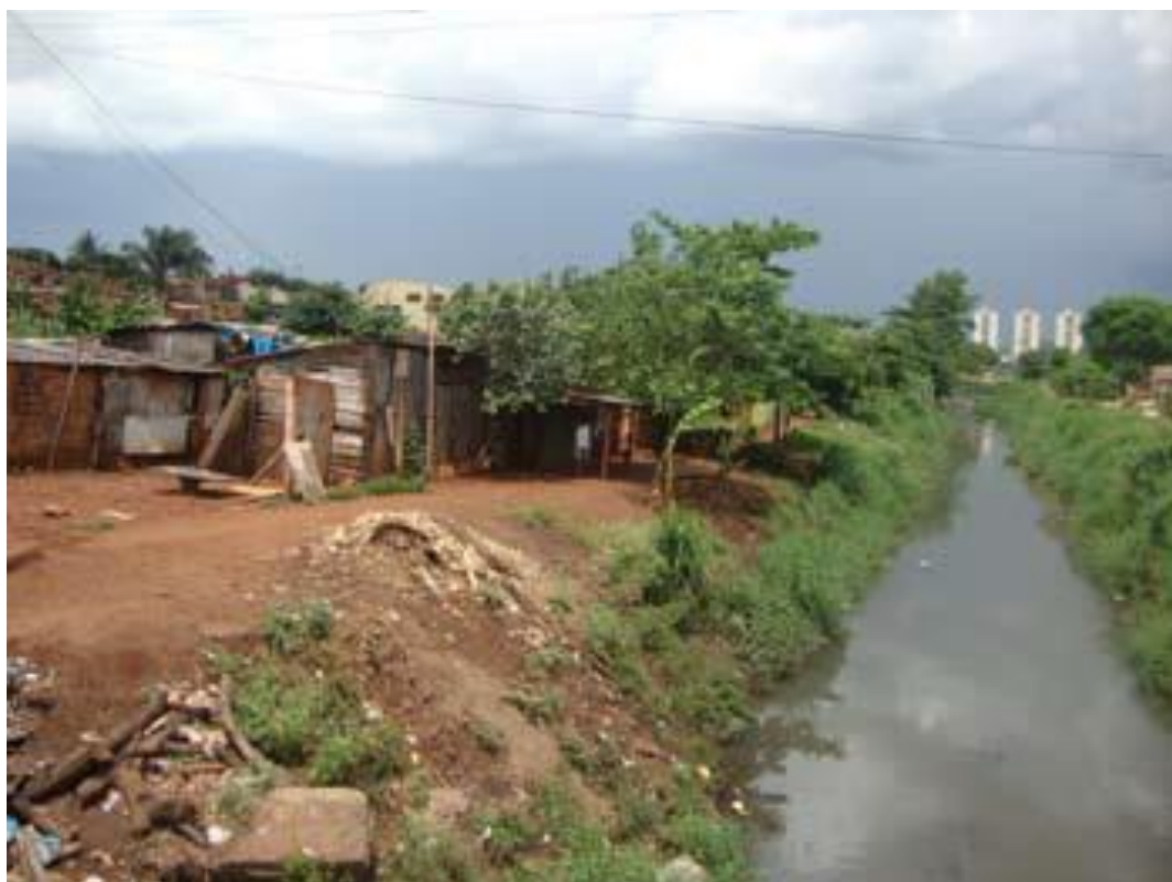
Figura 11: Parte do núcleo de favela do Tanquinho localizado nas margens do córrego de mesmo nome. Nota-se, a proximidade das casas em relação ao córrego e a distância em relação a cidade promissora. (Autor: Marília Nardin – PLHIS, 2010).
