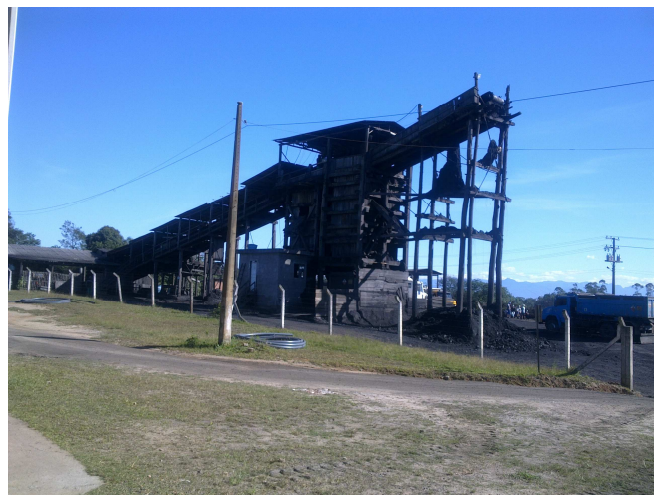
Figura 2 – Estrutura de correias na Cooperminas
