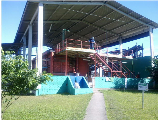
Figura 1 - Estação de tratamento de água da Cooperminas
