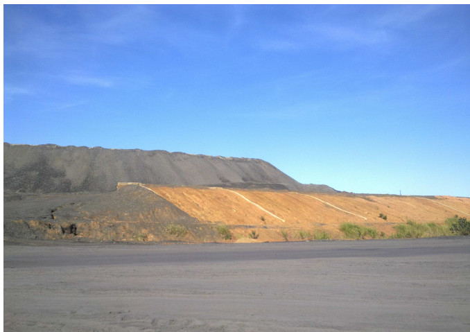
Figura 5 - Depósito controlado de rejeitos na Cooperminas
