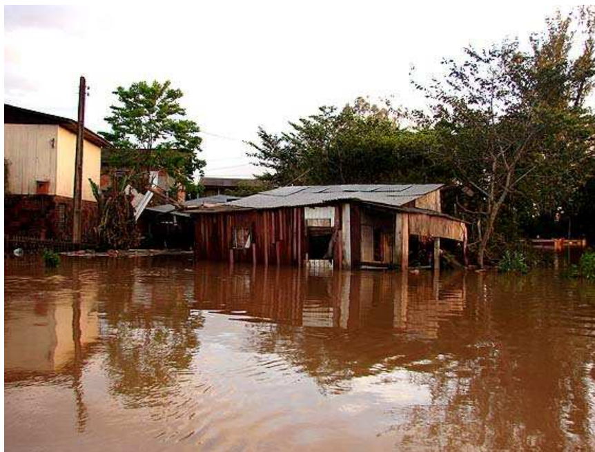
Figura 24 – Moradia afetada pela cheia do rio Caí, outubro de 2007, no bairro Navegantes.
