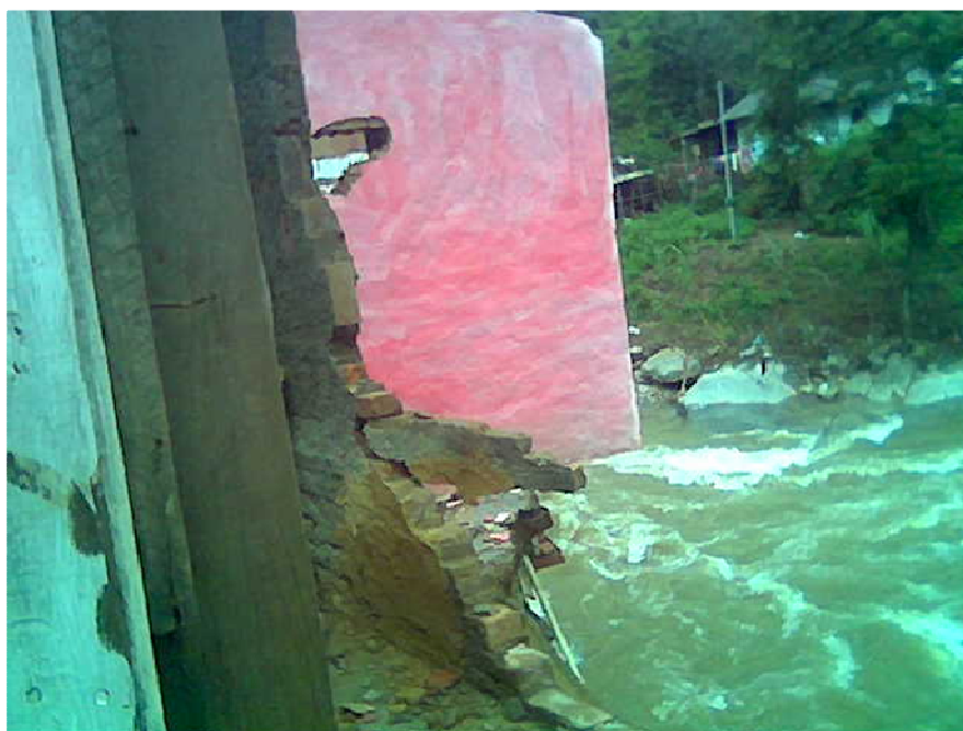
Figura 14 – Única parede que restou da casa que foi levada pelo rio. Distrito de Riograndina (Acervo NEPED, 18 jan. 07).
