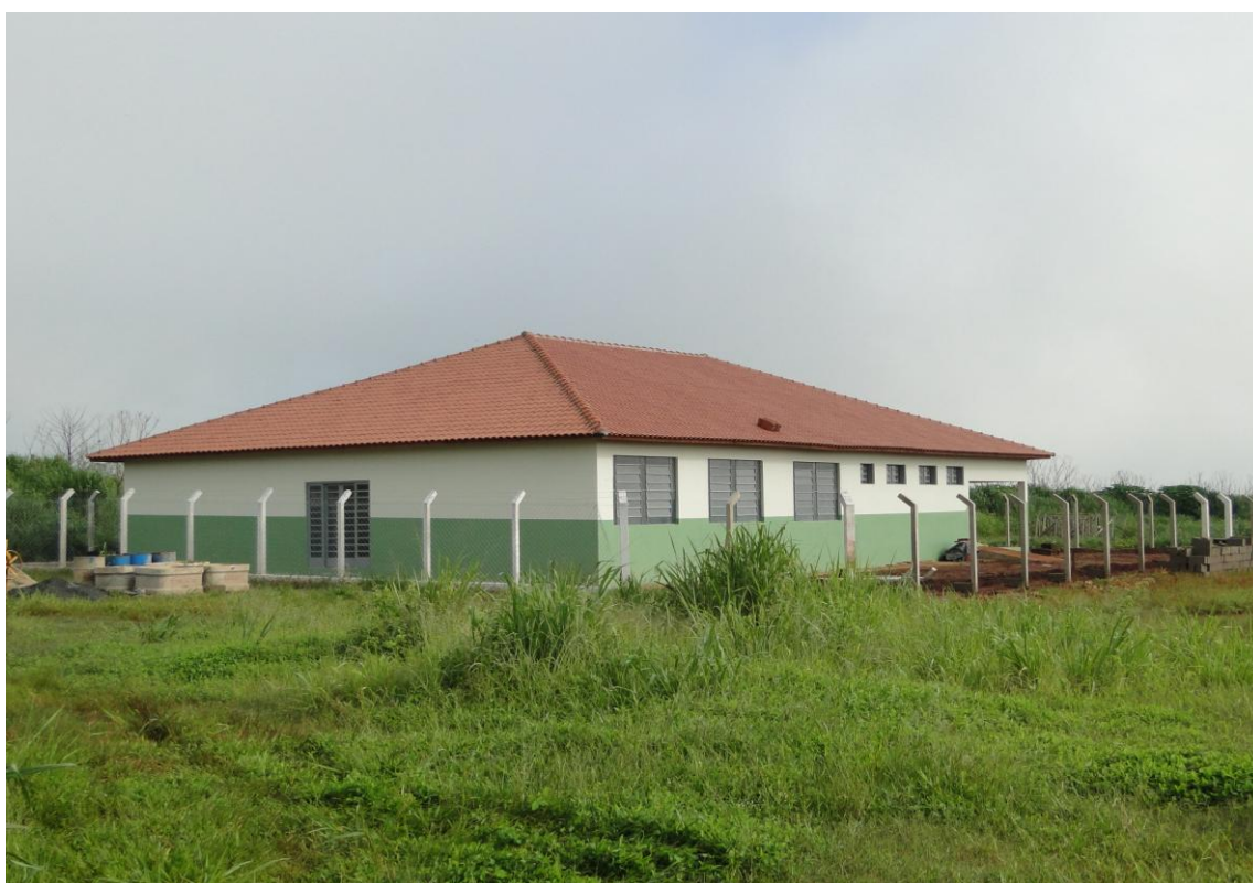
Figura 2. Escola no Assentamento Sepé Tiarajú em fase de conclusão.
