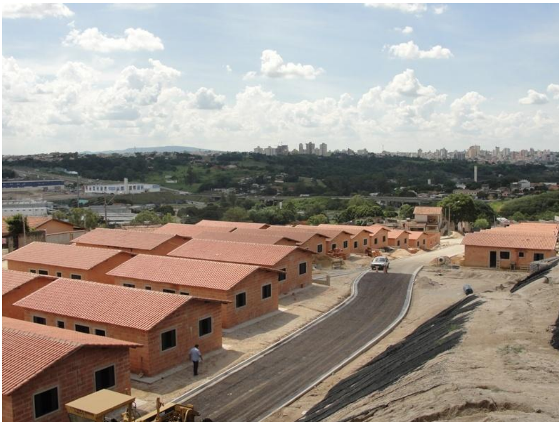
Figura 21. Vista da construção das novas moradias no Jardim Archilla em 2009. Fonte: COHAP - Cia de Habitação Popular de Votorantim, 2009.
