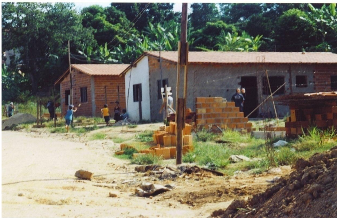
Figura 17. Imagem da construção de casas populares no Jardim Morumbi pelo sistema de mutirão no ano de 2005. Fonte: COHAP – Cia de Habitação Popular de Votorantim, 2005.
