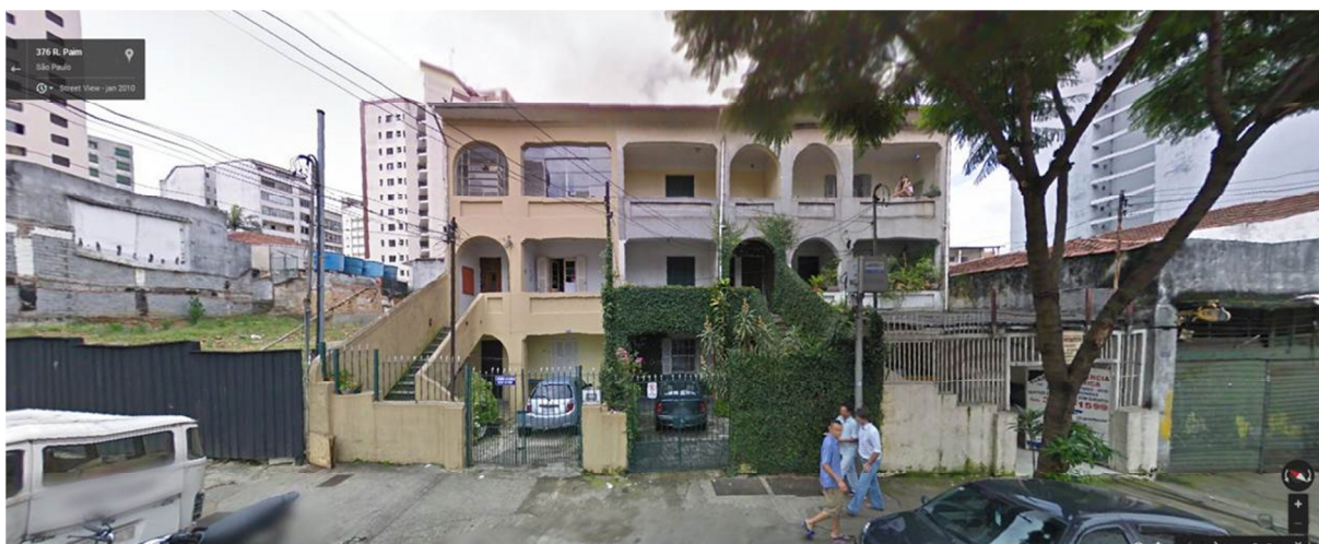
Figura 44 - Registros fotográficos da Rua Paim em 2010 (acima) e 2014 (abaixo), tiradas do mesmo ponto, mostrando as edificações demolidas para construção do Residencial MaxHaus Paulista.
