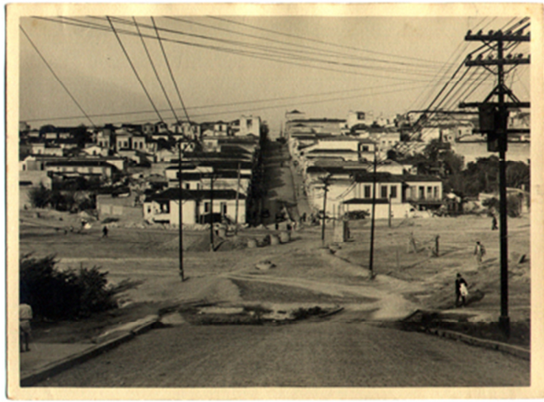
Figura 16 - Praça 14 Bis (1935). Obras de abertura da via. Autor desconhecido.
