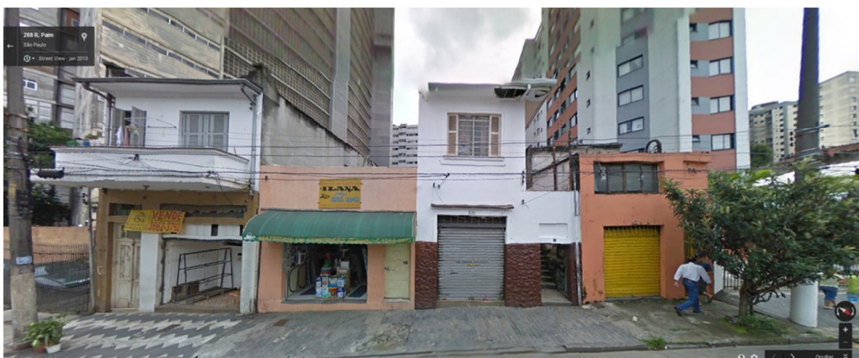
Figura 40 - Registros fotográficos da Rua Paim em 2010 (acima) e 2014 (abaixo), tiradas do mesmo ponto, mostrando as edificações demolidas para construção do Residencial Soul Paulista.
