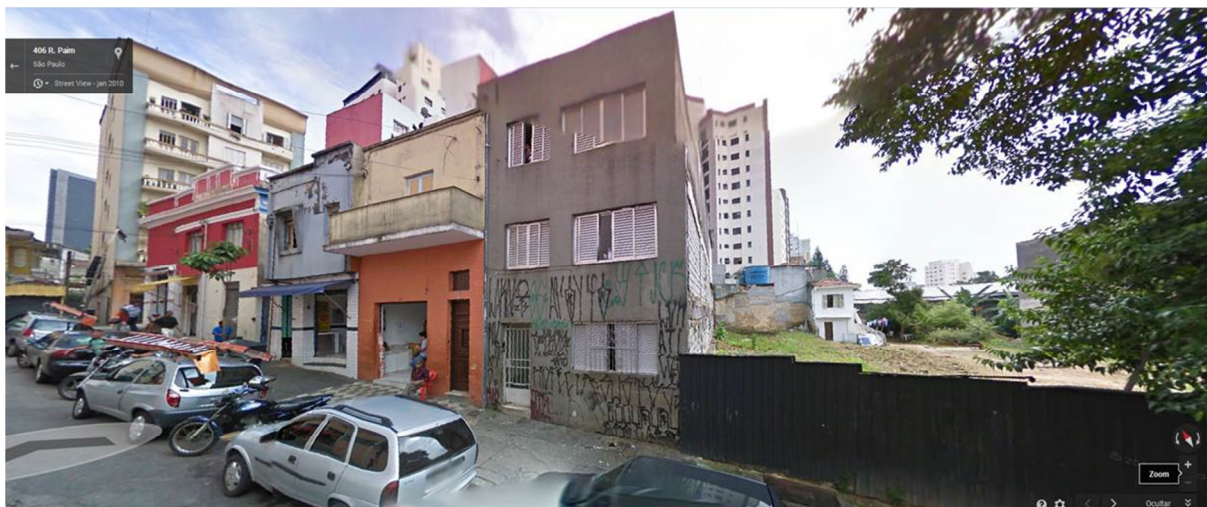
Figura 45 - Registros fotográficos da Rua Paim em 2010 (acima) e 2014 (abaixo), tiradas do mesmo ponto, mostrando as edificações demolidas para construção do Residencial MaxHaus Paulista.
