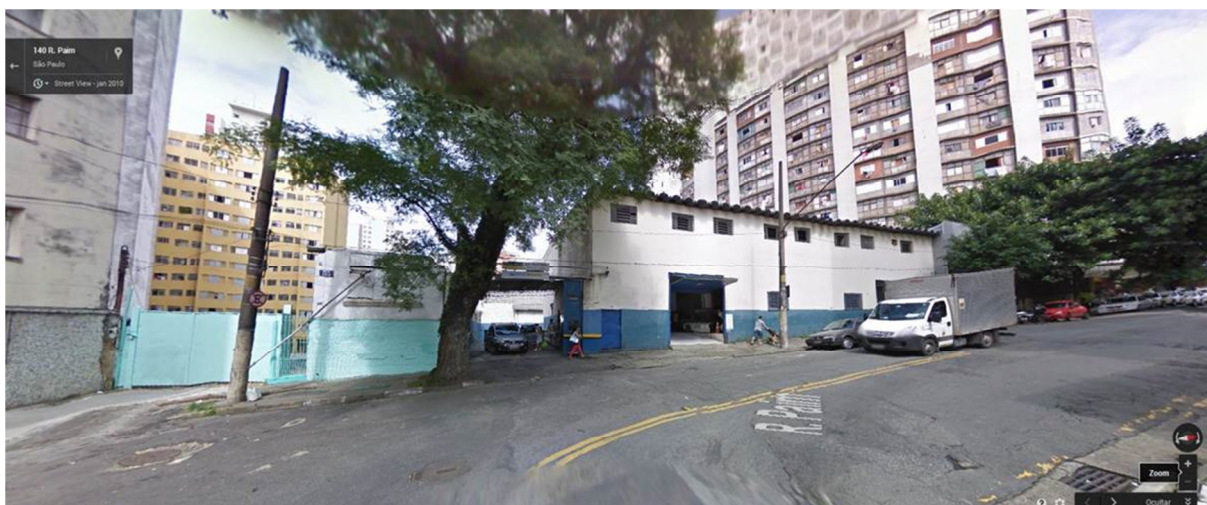
Figura 46 - Registros fotográficos da Rua Paim em 2010 (acima) e 2014 (abaixo), tiradas do mesmo ponto, mostrando as edificações demolidas para construção do Residencial Cena Paulista.
