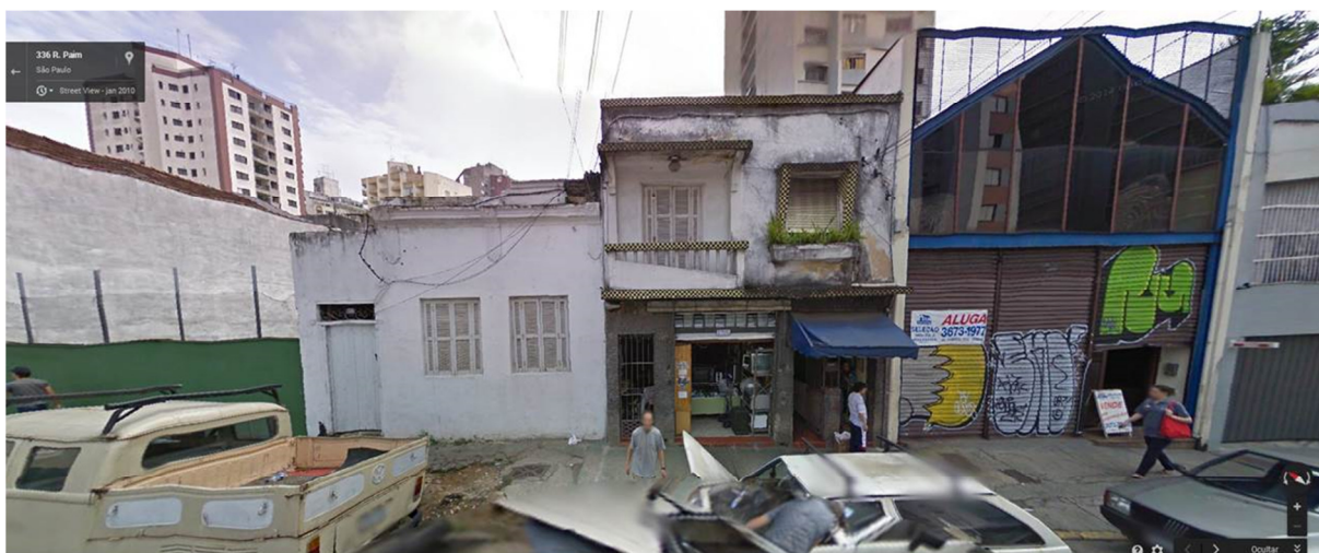
Figura 43 - Registros fotográficos da Rua Paim em 2010 (acima) e 2014 (abaixo), tiradas do mesmo ponto, mostrando as edificações demolidas para construção do Residencial Zoom Paulista.
