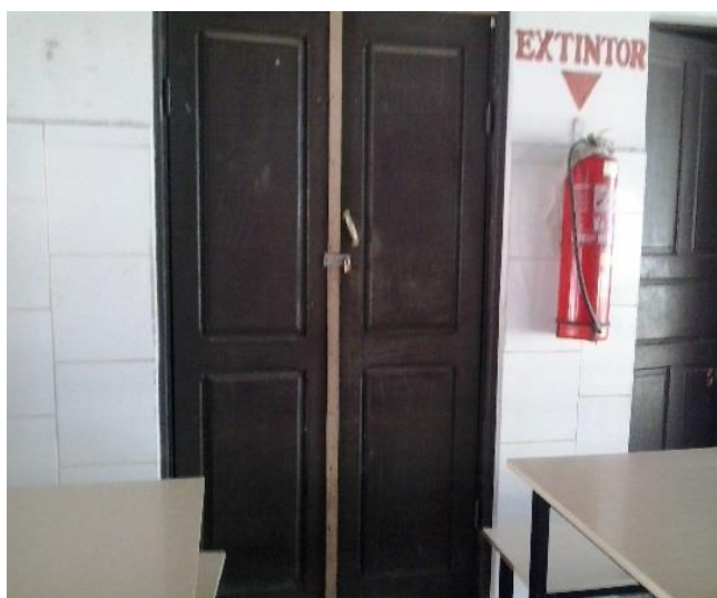
Foto 53: Banheiro para PcD
