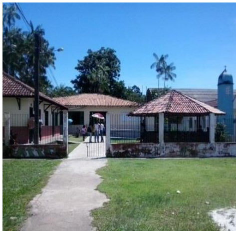
Foto 16: fachada da escola.
