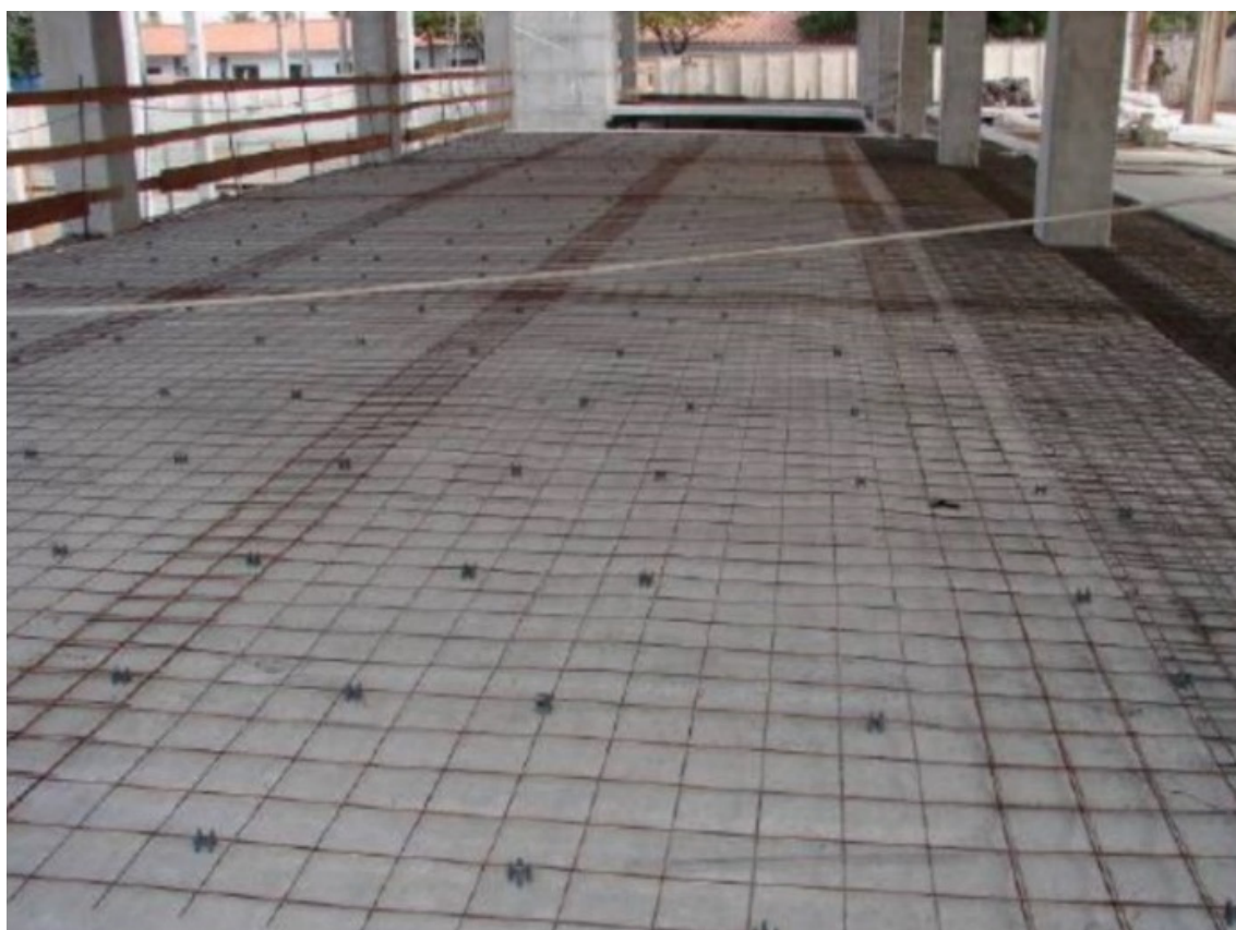
Figura 3.8 – Pavimento preparado para receber a capa estrutural.
