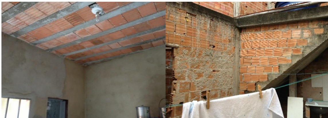
Figura 40: Da esquerda para direita, primeira foto mostra a laje do segundo pavimento concluída; segunda foto, ao fundo, mostra a escada para o segundo pavimento.
