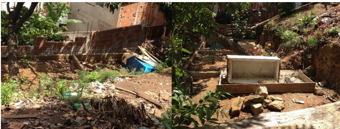
Figura 45: da esquerda para direita, foto tirada de cima do lote do TC9 mostrando parte da fundação; a segunda foto tirada do mesmo plano da fundação mostra a parte inferior do lote e parte da fundação. Fonte: arquivo do autor.
