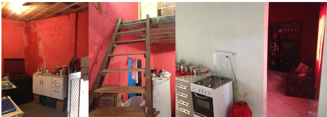
Figura 28: Da esquerda para direita, foto do primeiro pavimento e a laje do segundo; escada de acesso ao segundo pavimento; cozinha e sala do segundo pavimento com piso cerâmico e revestimento nas paredes feitos com o crédito habitacional.
