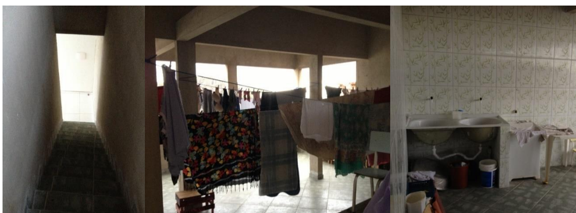
Figura 43: Da esquerda para direita, escadaria de acesso ao terceiro pavimento; segunda foto mostra o terceiro pavimento atualmente utilizado como área de lazer e serviço; terceira foto mostra o terceiro pavimento com cerâmicas no piso e paredes.
