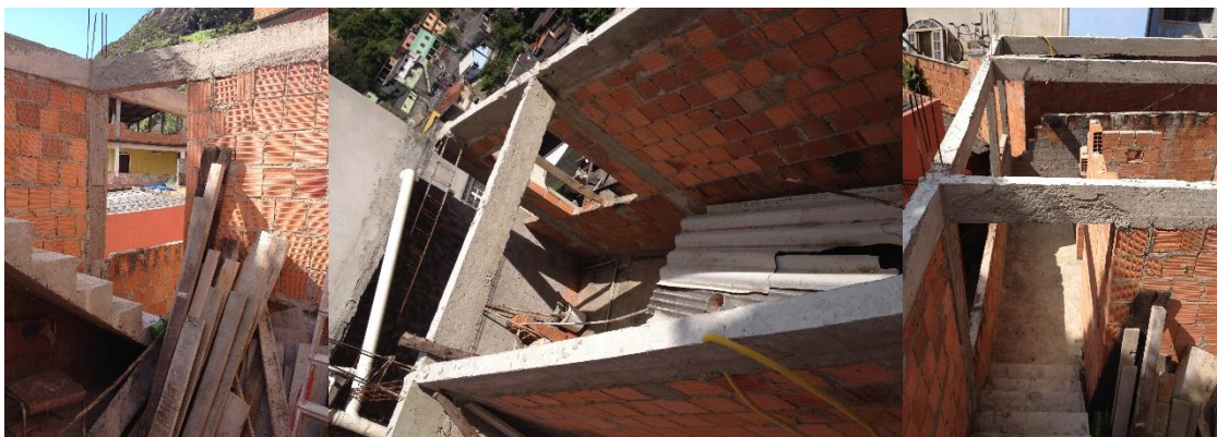
Figura 27: da esquerda para direita, a primeira foto mostra a escada na porta de acesso a um dos cômodos; a segunda foto mostra a casa em construção do TC2 encostada na casa de seu familiar; a terceira foto mostra uma imagem do topo do segundo lance de escada.
