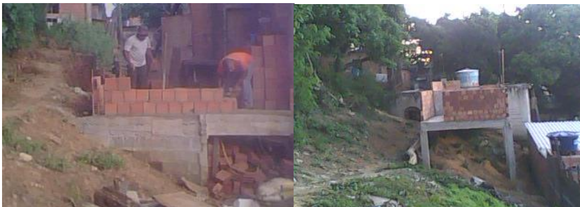
Figura 32: da esquerda para direita, primeiro foto mostra a primeira laje concluída e as paredes sendo levantadas; segunda foto mostra o lote sem muros, a estrutura da primeira laje e a laje concluída e as paredes parcialmente concluídas.
