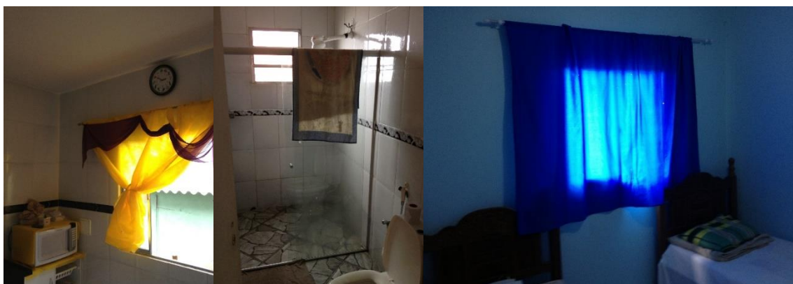
Figura 47: Da esquerda para direita, primeira foto mostra a cozinha com cerâmica nas paredes e revestimento na laje; segunda foto mostra o banheiro concluído, com piso e paredes com revestimentos cerâmicos; terceira foto mostra um dos dois quartos. Todos os cômodos foram construídos a partir do crédito habitacional acessado pelo TC10.
