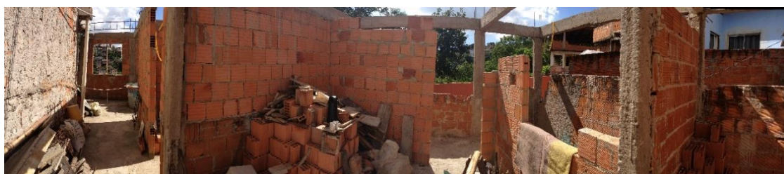
Figura 26: Vista panorâmica da habitação do TC2 em obra.
