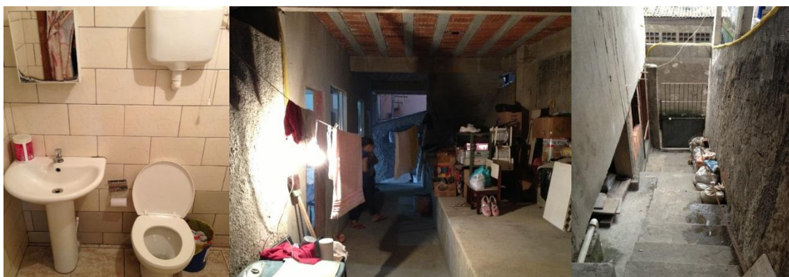
Figura 42: Da esquerda para a direita, primeira foto mostra o banheiro do primeiro pavimento; a segunda foto mostra a área de serviço do primeiro pavimento e a laje do segundo pavimento; a terceira foto mostra a escadaria de acesso ao primeiro pavimento da habitação do TC8.
