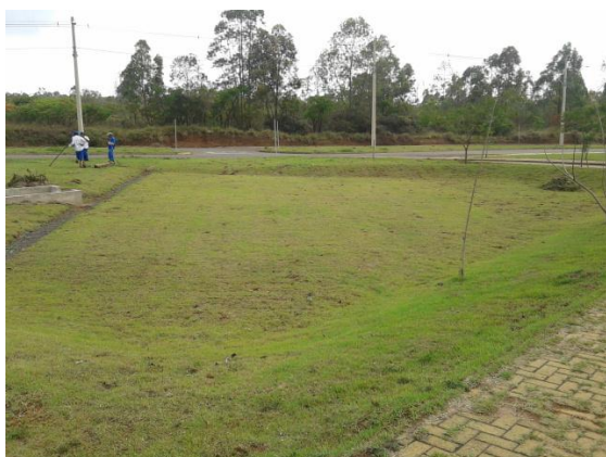
Figura 10. Plano de infiltração localizado do entorno de estacionamento (5000 m 2 ) e departamento de Medicina II e Gerontologia, localizado na Microbacia experimental do grupo de pesquisa GHIDRO – UFSCar, campus São Carlos. Fonte: Autor
