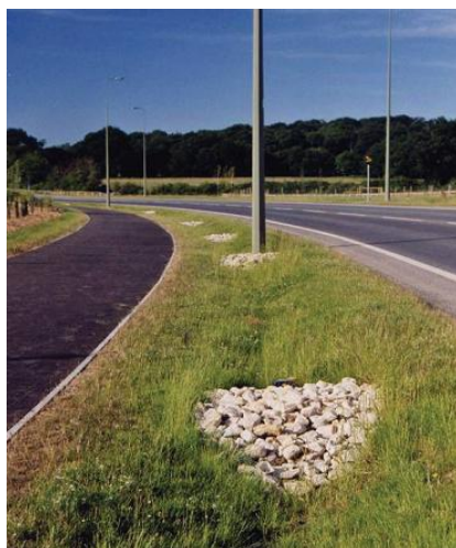
Figura 12. Canal gramado localizado paralelo a extensão de rodovia, localizado em Oxford.
