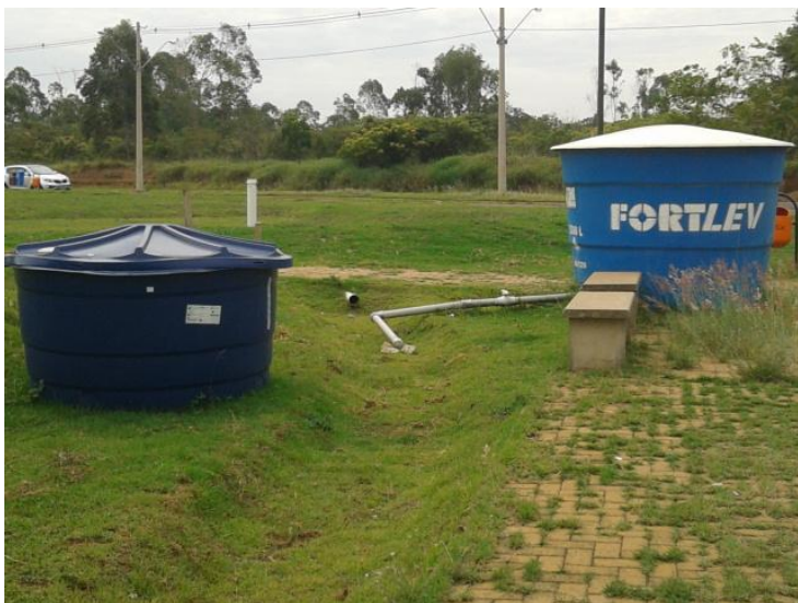
Figura 19. Reservatórios de 2m 3 e 5m 3 utilizados para aumento do volume de descarregamento no canal.
