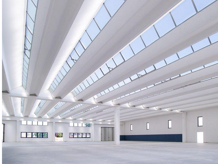
Figura 12: Cobertura com shed
