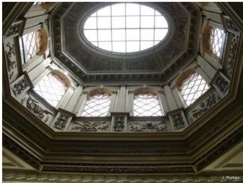
Figura 11: Lanternim em igreja
