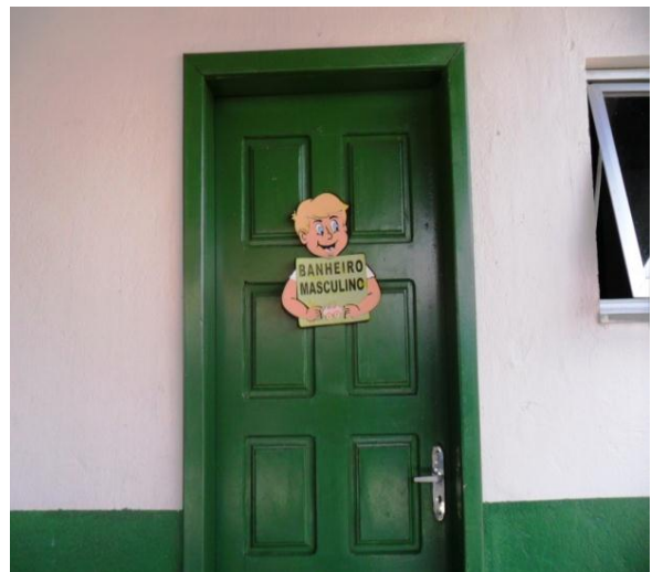
Imagem 3. Porta de banheiro. Creche Maria Bujes
