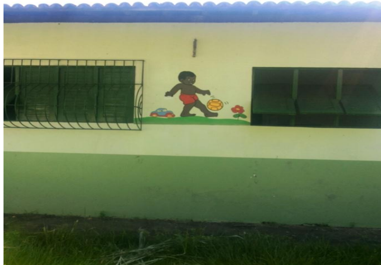
Imagem 25. Área interna. Creche Walter Kohan.
