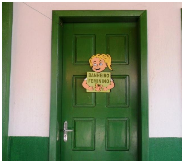
Imagem 2. Porta de banheiro. Creche Maria Bujes 47
