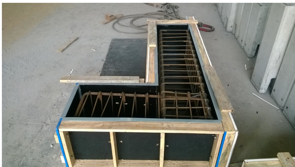
Figura 5.9 - Forma e armação do modelos B
