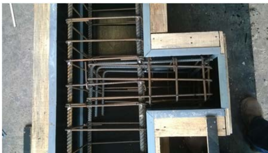
Figura 5.10 - Recorte na forma e armação do consolo
