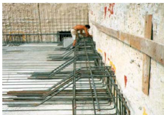
C - Conexão de laje com parede diafragma
