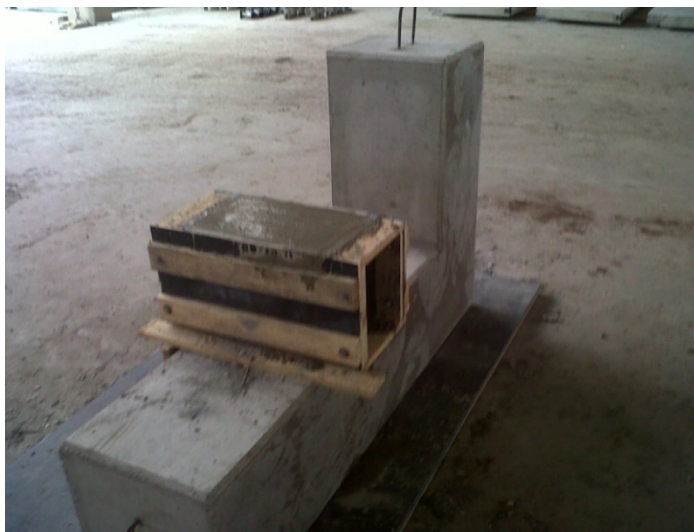
Figura 5.13 - Concretagem do consolo
