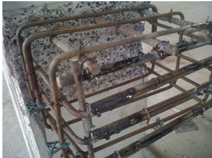
Figura 5.12 - Armadura do consolo montada e o concreto apicoado
