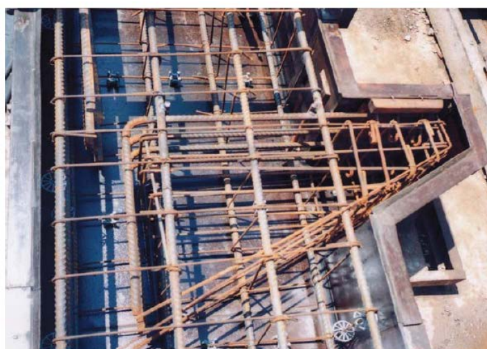
Figura 1.3 – Concretagem de pilar com consolo
