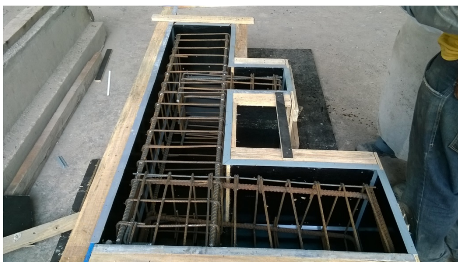
Figura 5.8 - Forma e armação do modelo A
