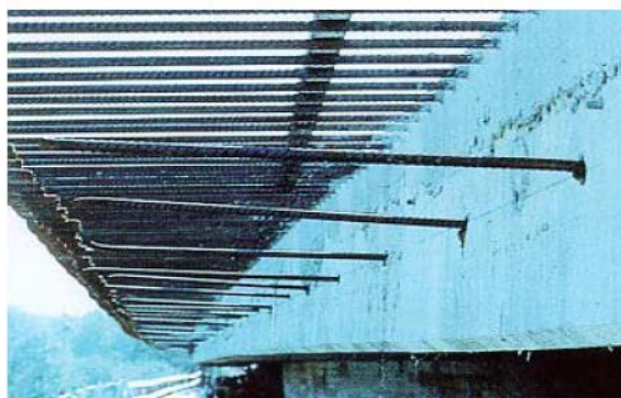
A - Ampliação de uma laje
