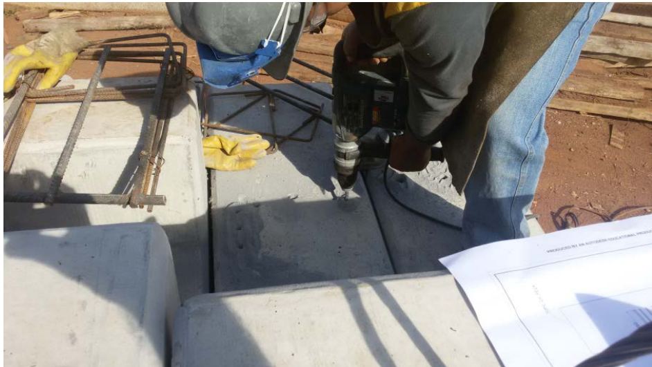
Figura 5.11 - Execução dos furos
