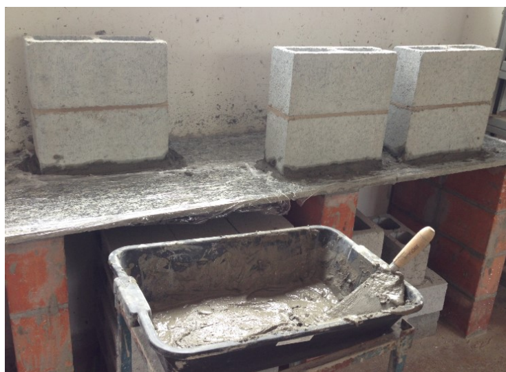
Figura 85: Caapeamento dos prismas com pasta de cimento.
