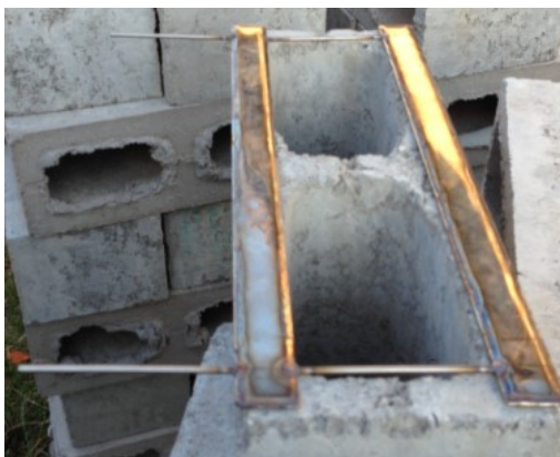
Figura 59: Macaco de duas abas posicionado no bloco.
