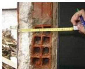
Figura 32: Paredes de blocos vazados ensaiadas com macacos planos.
