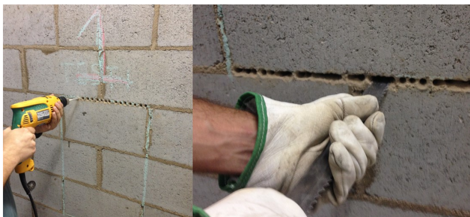
Figura 105: Processo de remoção da argamassa na junta
