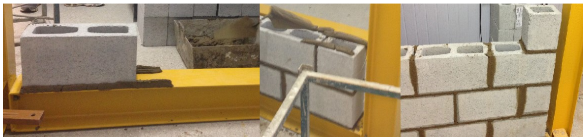
Figura 93: Construção das paredes.
