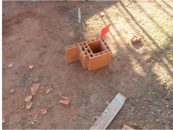
Figura 26 – Bloco sinalizado como perda por ter sido quebrado devido mau manuseio
