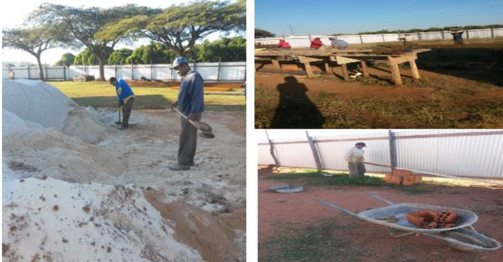
Figura 71 - Durante o treinamento – recolhimento de lixo no canteiro e material que pode ser reutilizado. Separação e organização de cada item por tipo e tamanho
