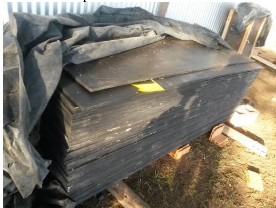
Figura 28 - Estoque de madeira compensada necessário durante a obra, mas não agrega valor
