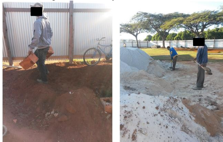
Figura 63 - Realização de 5S no canteiro
