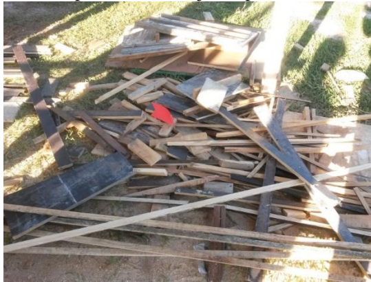
Figura 29 - Corte da madeira compensada de forma errada faz com que a placa não seja bem aproveitada e haja desperdício.
