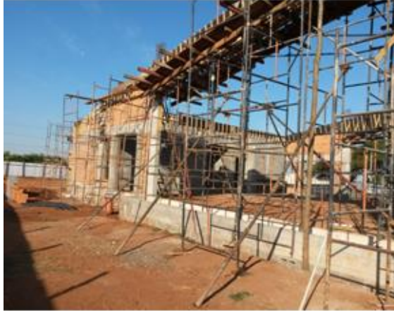
Figura 68 - Após o treinamento – obra limpa e organizada. Sem material desperdiçado pelo chão
