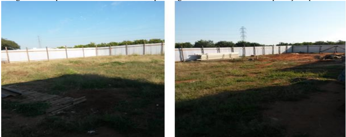
Figura 68 - Após o treinamento - obra limpa e organizada. Sem material desperdiçado pelo chão
