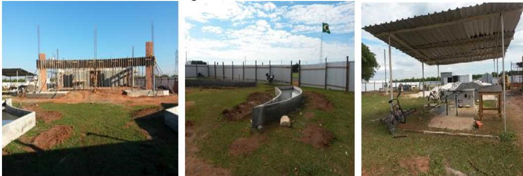
Figura 17 - Canteiro de obras
