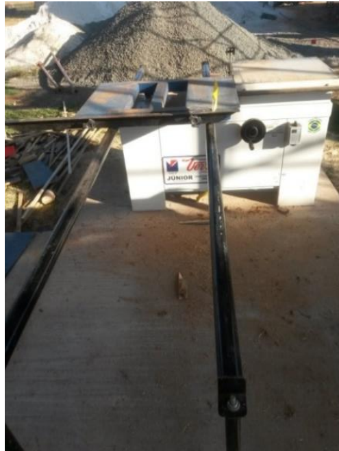
Figura 27 - Estrutura provisória sinalizada como atividade que não agrega valor pois é necessária durante a obra, mas depois será desmontada e a calçada será quebrada.
