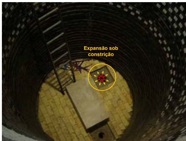
Figura 4.57 - Restrição imposta pelo revestimento do fundo da panela em uma sede de válvula composta por concreto alumina-magnésia.
