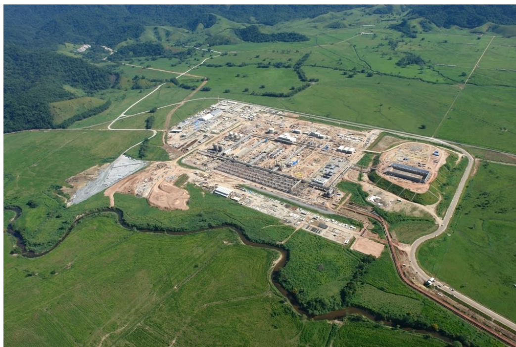
FIGURA 16 Unidade de Tratamento de Gás de Caraguatatuba (UTGCA)
