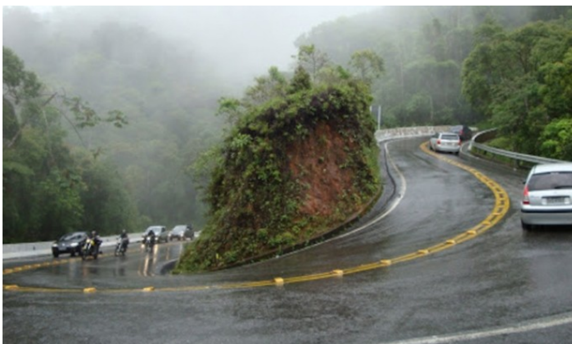
FIGURA 10 Trecho da Rodovia Oswaldo Cruz
