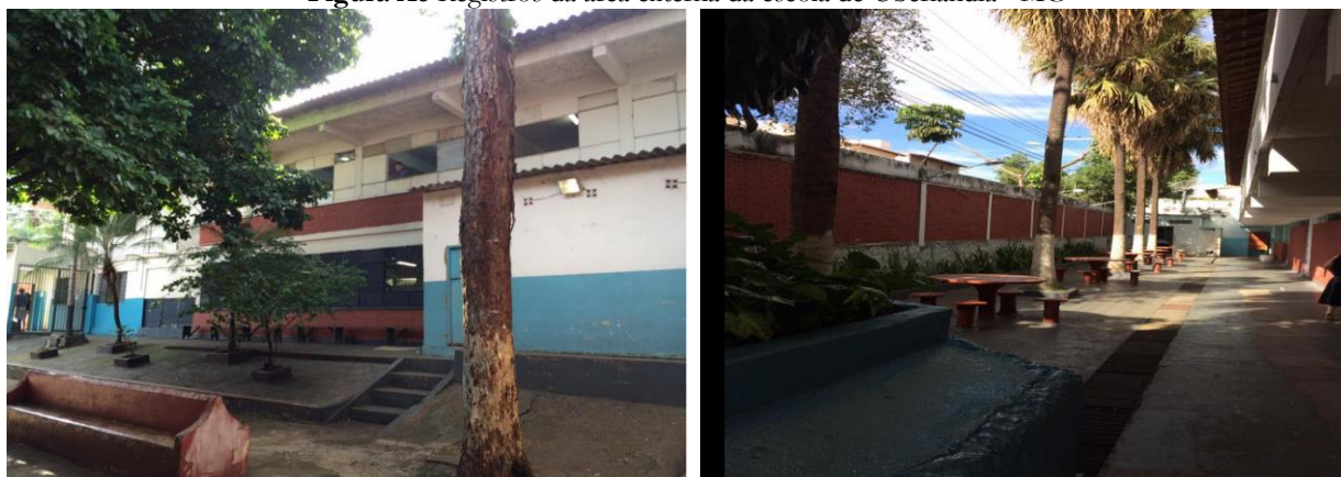
Figura A6 Registros da área externa da escola de Uberlândia - MG
