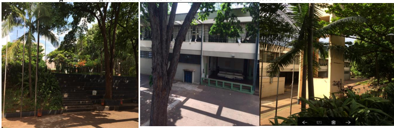
Figura A13 Registros area externas em torno das salas de aula da escola de Ribeirão Preto - SP
