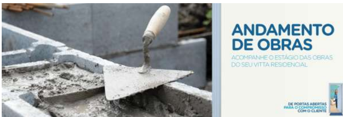
Figura 7.7 – Apresentação do andamento da obra no site
