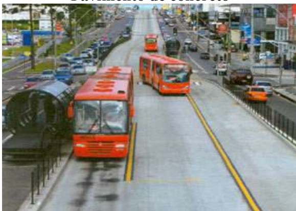
Pavimento de concreto
