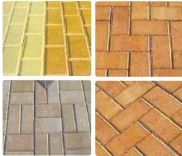
Figura 7 – Tipos de assentamento Fonte: ABCP (2010).
