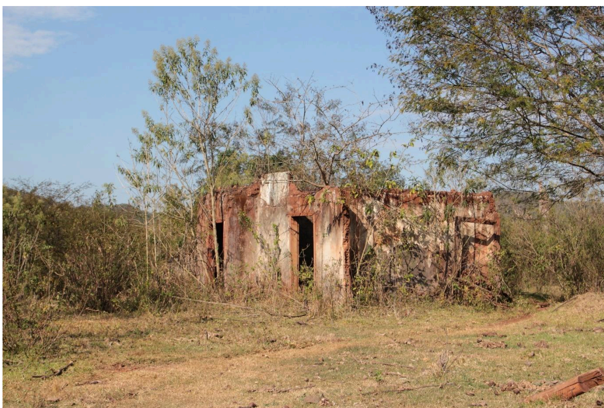
Figura 19 - Imóvel em ruínas em Bento Rodrigues. Fonte: autor, 2023.
