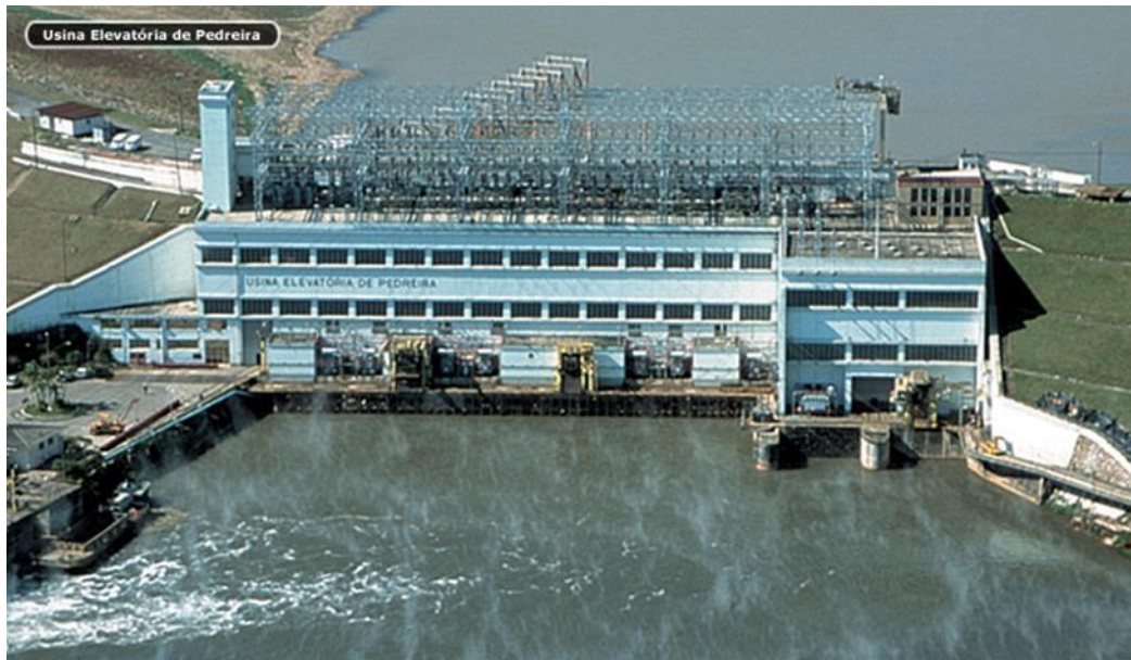
Figura 4: Usina Elevatória de Pedreira
