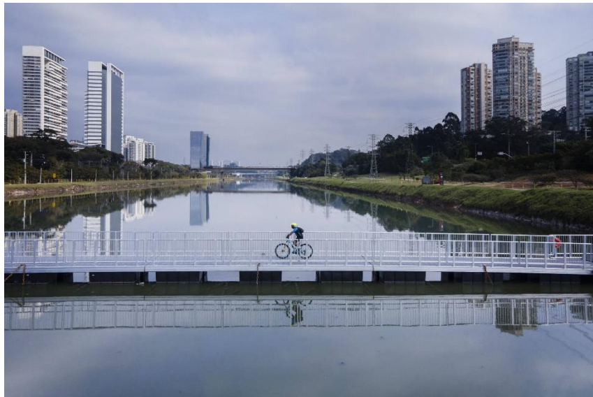
Figura 11: Passarela - estrutura flutuante
