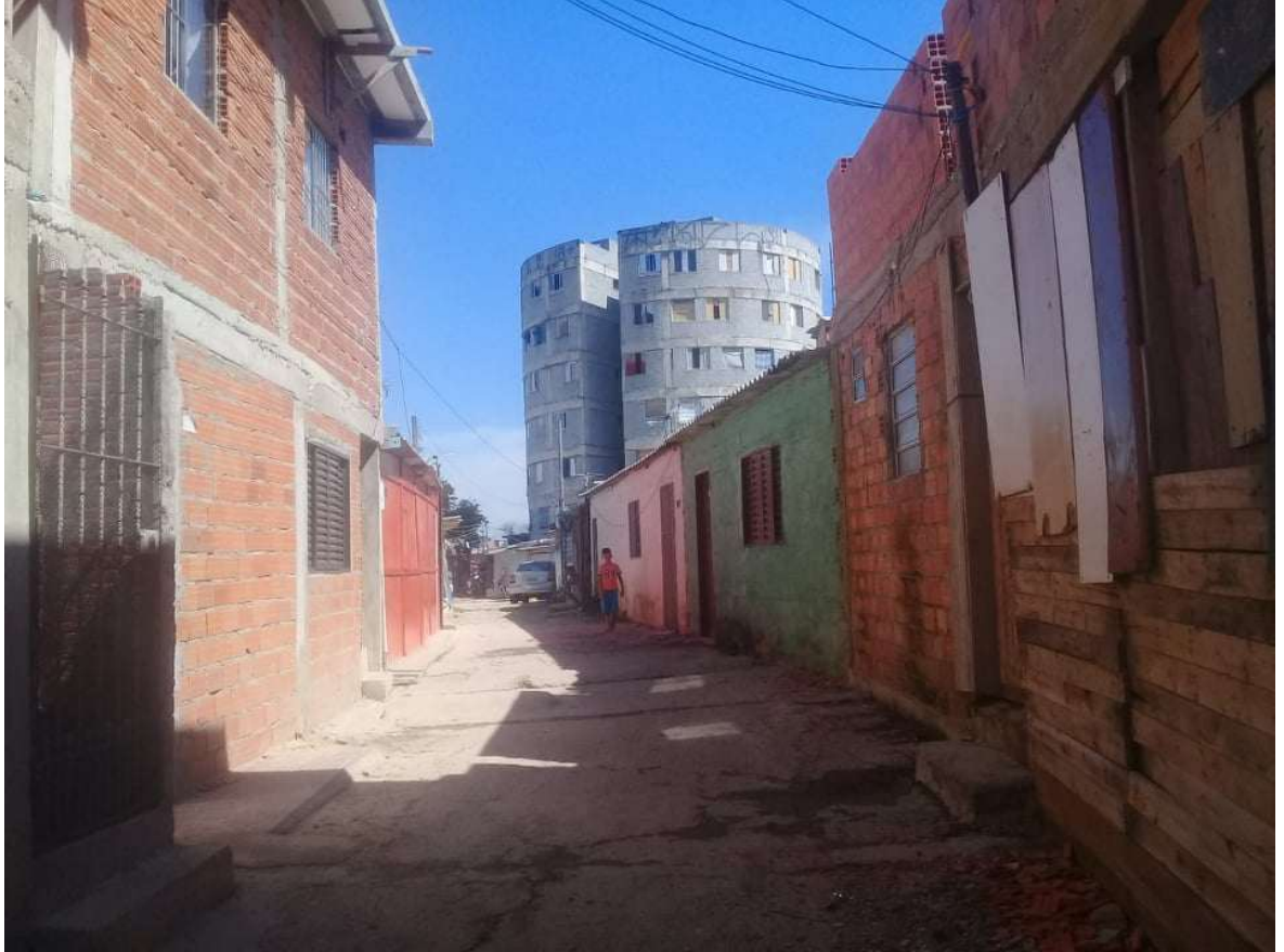
Figura 3: Visão de dentro da ocupação do terreno da SABESP, nas adjacências dos edifícios cilíndricos do PUF, cenário de séries como Sintonia e Irmandade. Quebrada feia e sem maquiagem. Ao fundo obras embargadas da intervenção (acervo pessoal)
